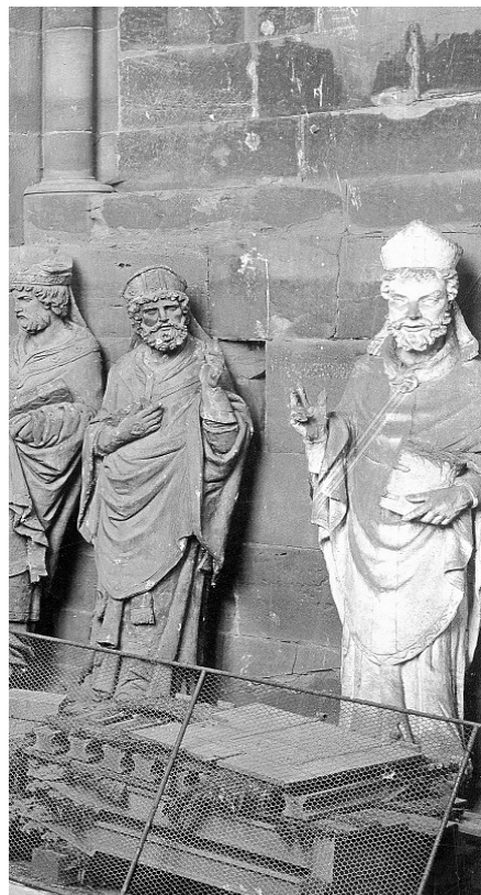
Fig. 386 : Evêques de Grass (phot. Messbild , 1897/© Fondation de l'OND).
