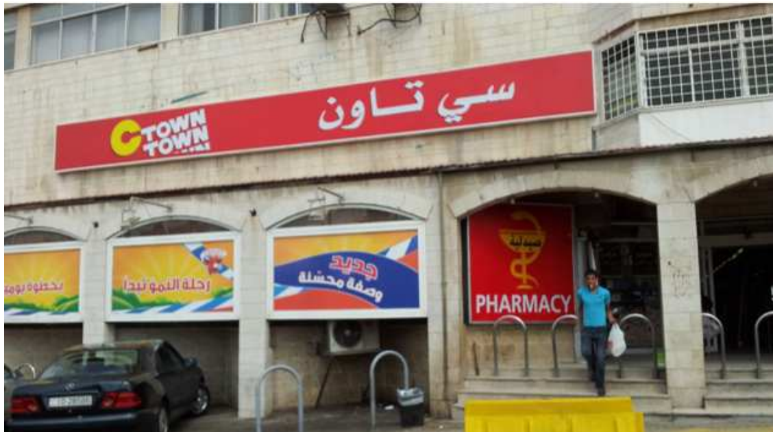
Photo 4 : Supermarché C-Town surface de la vente 2500 m 2 , date de construction 1994
