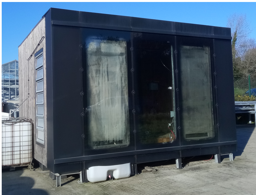
FIGURE 1.3 – Photographie du pilote SymbiO 2 Box implanté sur la plateforme Algosolis. Deux réacteurs airlift plans sont installés plein sud sur la façade. La partie se trouvant derrière permet de simuler la présence d'un bâtiment et d'étudier le couplage PBR - bâtiment.
