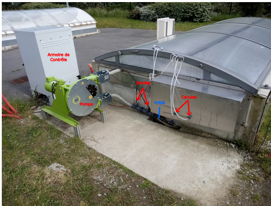
FIGURE 1.9 – Photographie des utilitaires du pilote Algofilm 10 m 2 .
