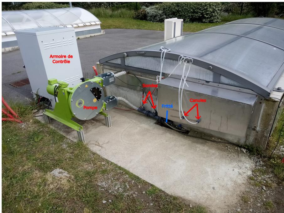
FIGURE 1.9 – Photographie des utilitaires du pilote Algofilm 10 m<sup>2</sup>.
