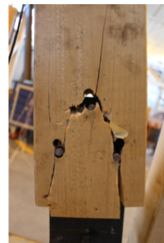
(b) éprouvette 1 : rupture de bloc en pied de diagonale
