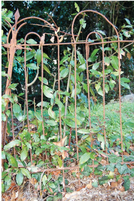
Figure 108. I. Dotte. L'ancienne clôture de la villa Eugénie , photographie, 2017
