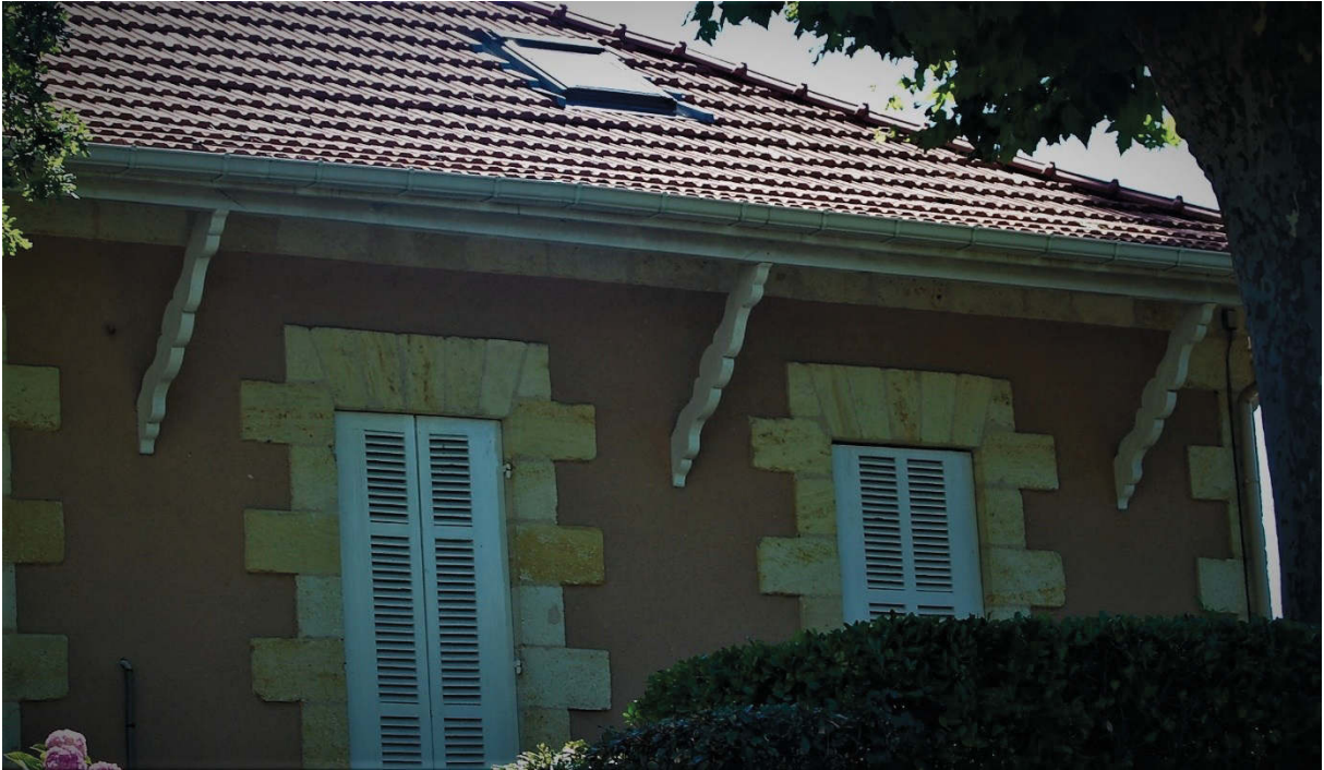
Figure 199. I. Dotte. Villa Desbief , aisseliers découpés, photographie, 2017
