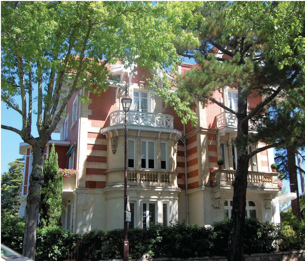
Figure 148 A-B-C-D-E-F-G-H. A. Alphonse Terpereau. Villa Shakespeare , in « Vues d'Arcachon », album de photographies, AMA B. I. Dotte. La villa aujourd'hui, devenue Sigurd , façade sud, photographie 2017
