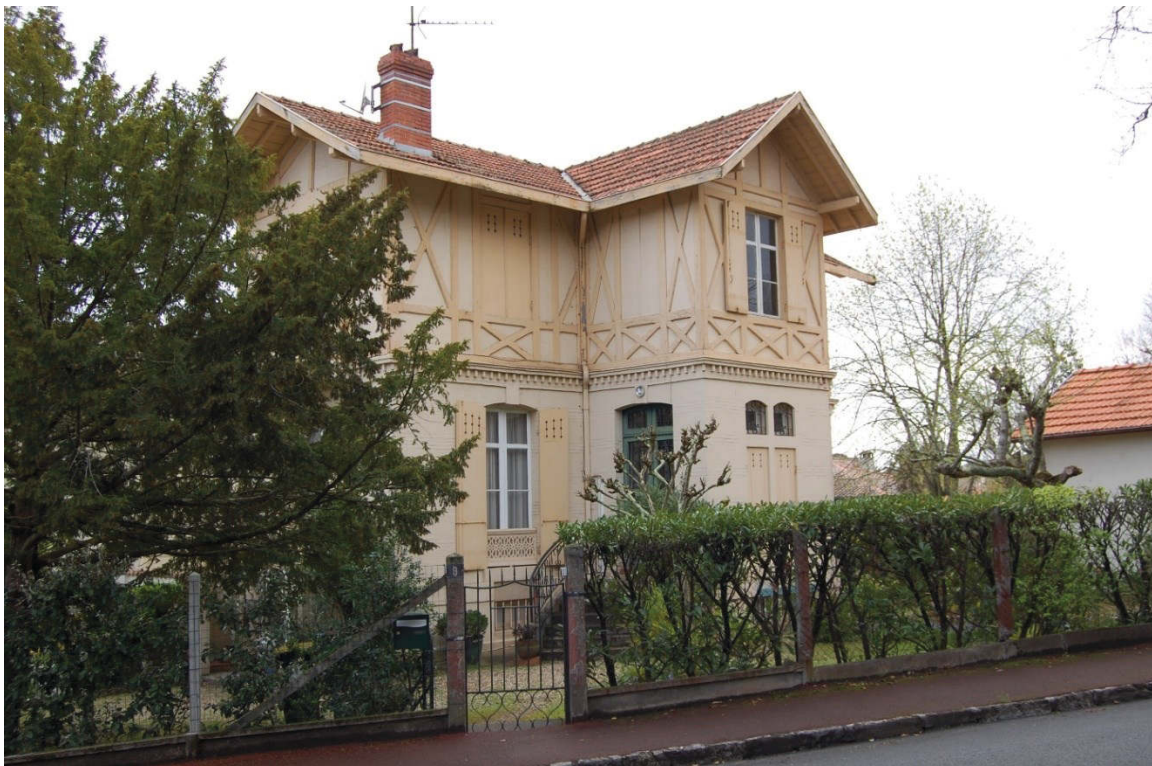
Figure 152 A-B. A. Alphonse Terpereau. Villa Vauban , in « Vues d'Arcachon », album de photographies, AMA B. I. Dotte. La villa aujourd'hui, photographie
