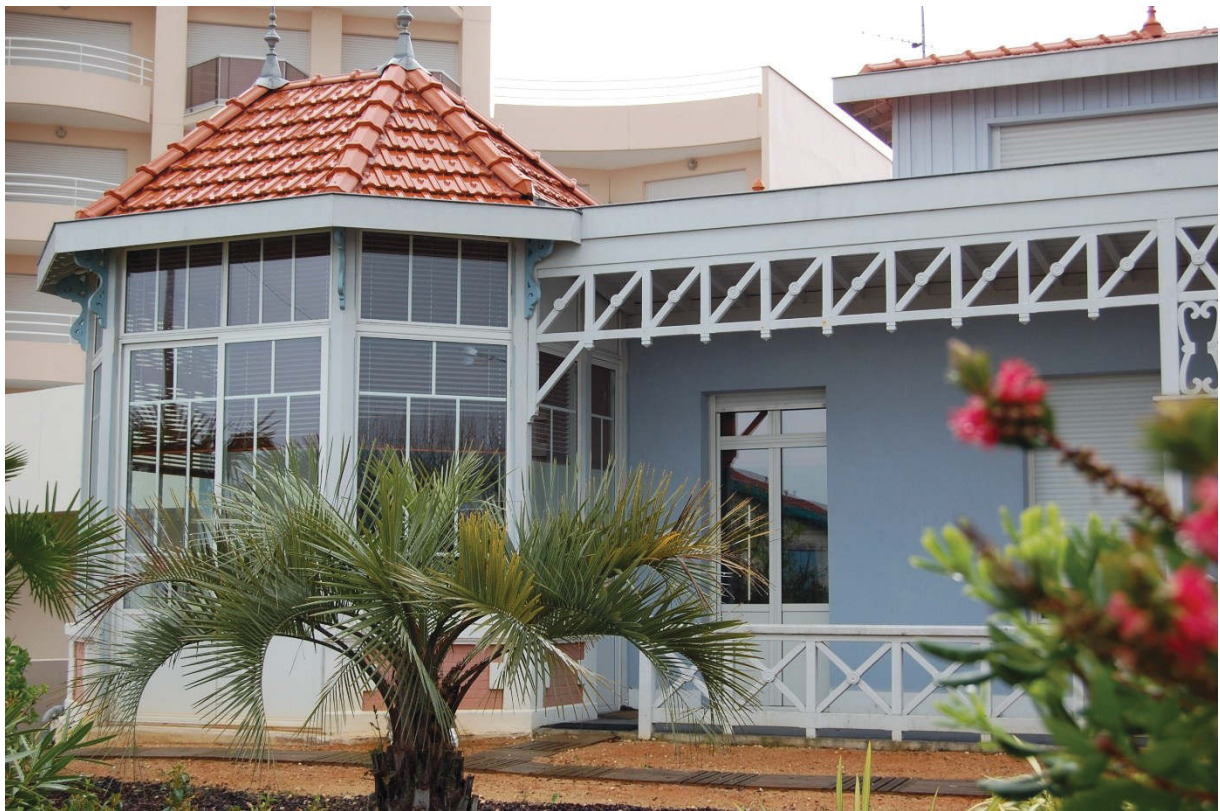
Figure 68 A-B. I. Dotte. Villa Isly , façade sur rue, photographies
