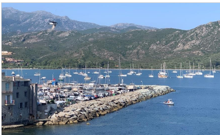
Figure 17 : Digue nord du port de Saint-Florent vue du large : zone de relâché des juvéniles de corb de l'année 2022
