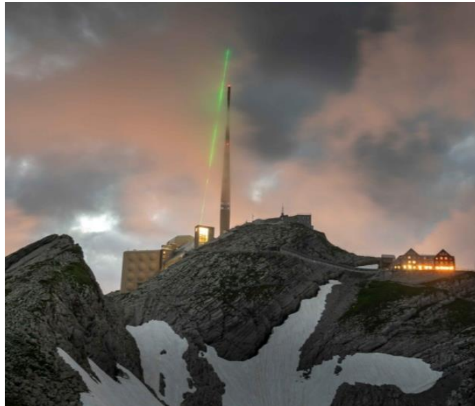
Figure 1 : Photo de l'expérience Laser Lightning Rod, lors de laquelle nous avons utilisé un laser pour guider des éclairs ascendants depuis la tour située au sommet du mont Säntis.
