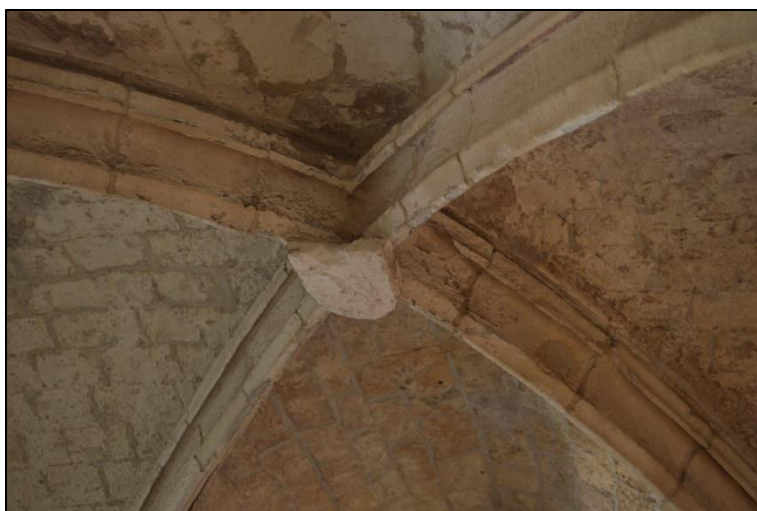
Figure 11.32 : Voûte quadripartite simple (© Lise Levieux).
