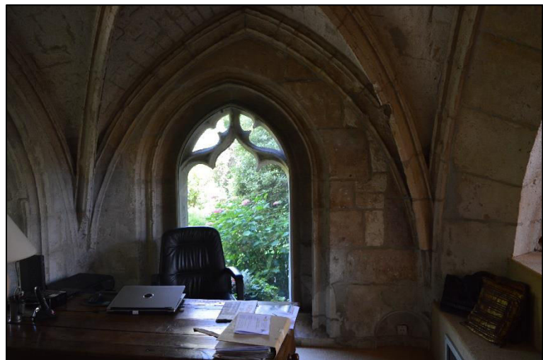
Figure 11.30 : Mur oriental, baie (© Lise Levieux).
