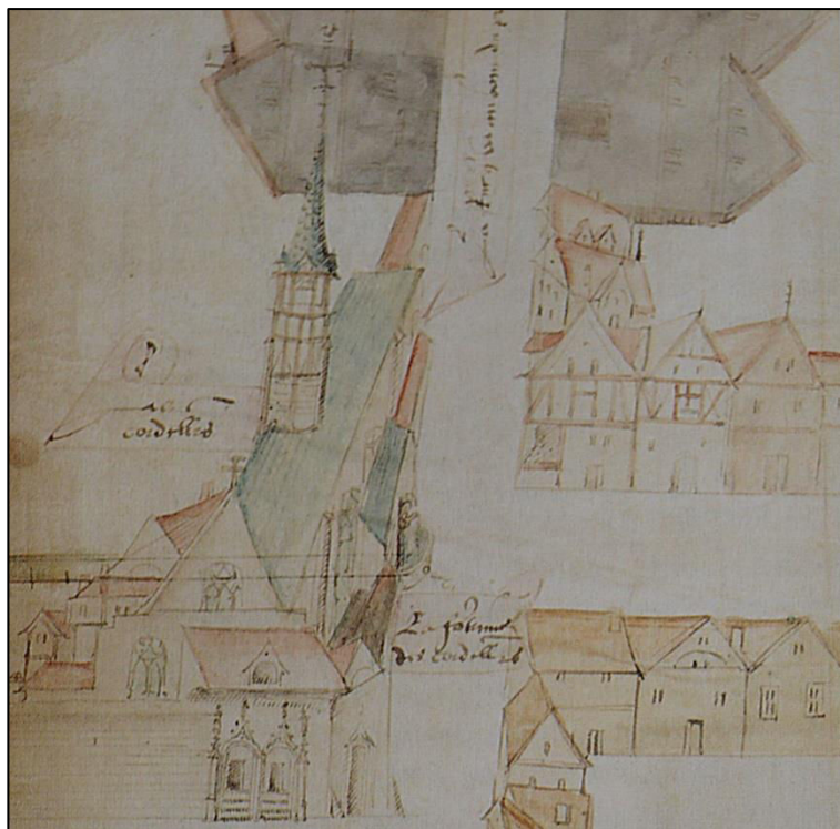
Figure 14.16 : Les Franciscains sur la bande de Gaalor.
