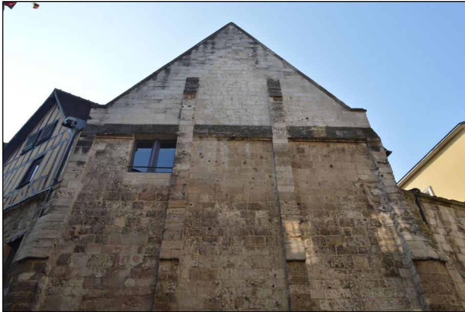
Figure 2.12 : Pignon du bâtiment monastique, partie haute (© Lise Levieux).
