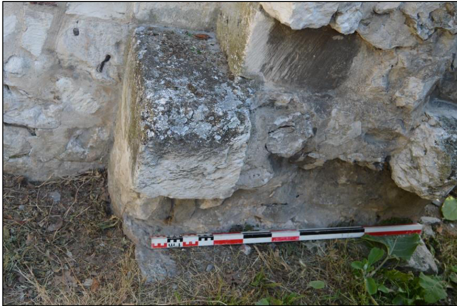
Figure 17.30 : Mur oriental du bâtiment communautaire (© Lise Leveux).
