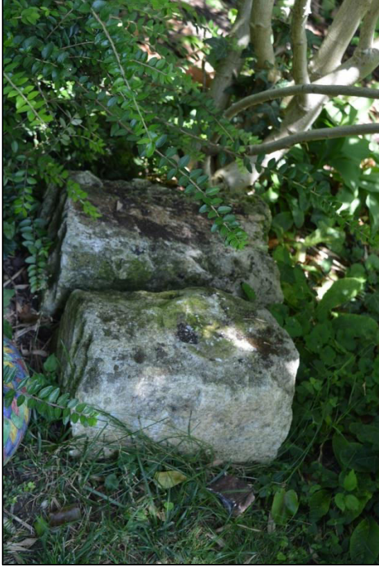
Figure 11.46 : Fondations d'un mur d'orientation nord-sud (© Lise Levieux).
