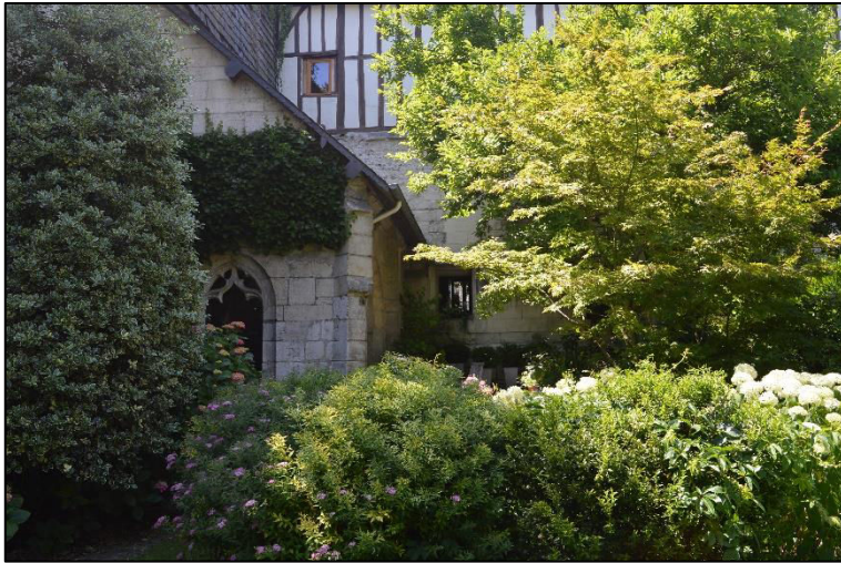
Figure 11.29 : Bâtiment nord accolé à l'église (© Lise Levieux).
