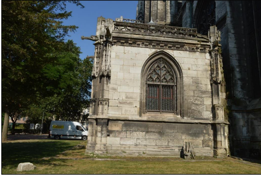
Figure 5.15 : La sacristie, mur oriental (© Lise Levieux).
