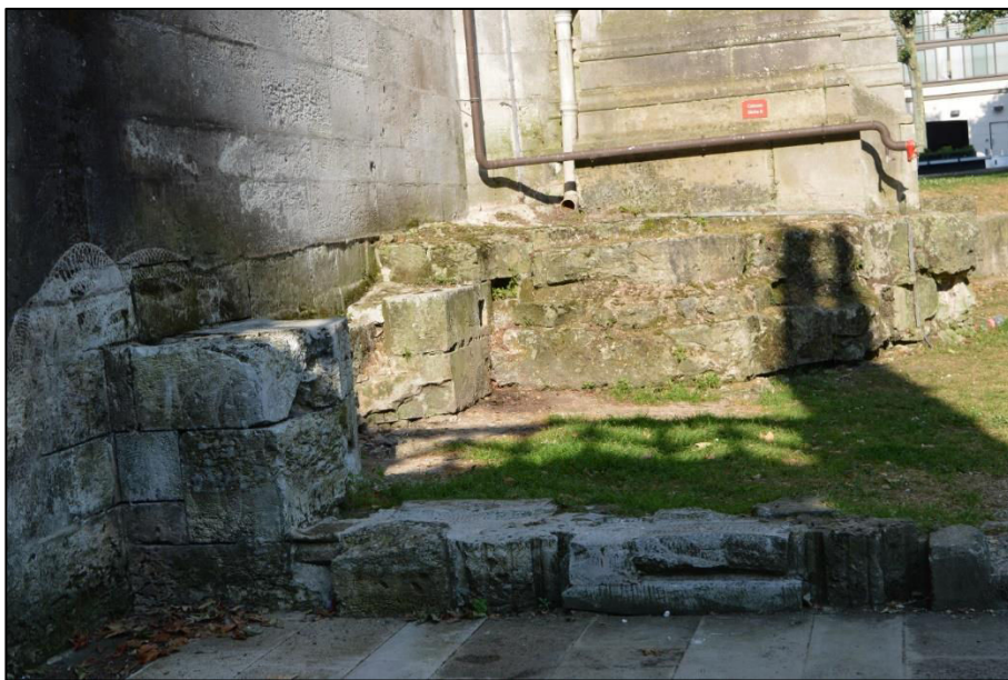
Figure 5.27 : Vestige du bâtiment communautaire à l'ouest du cloître (© Lise Levieux).
