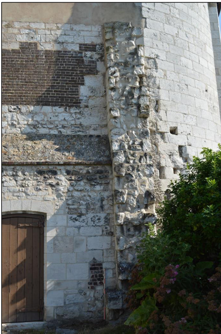
Figure 17.31 : Mur oriental du bâtiment communautaire (© Lise Leveux).
