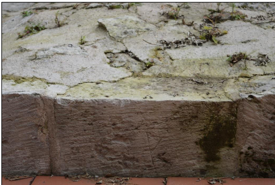
Figure 12.14 : Marques lapidaires sur les vestiges mis au jour au Rectorat.
