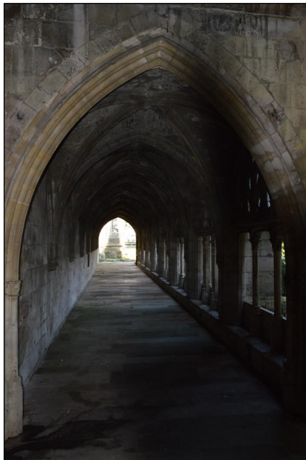
Figure 5.19 : Galerie du cloître, vue intérieure (© Lise Levieux).
