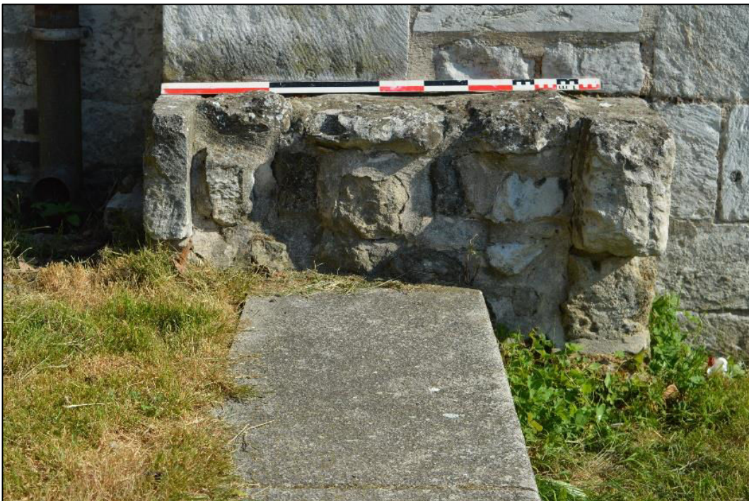
Figure 17.29 : Mur occidental du bâtiment communautaire (© Lise Leveux).
