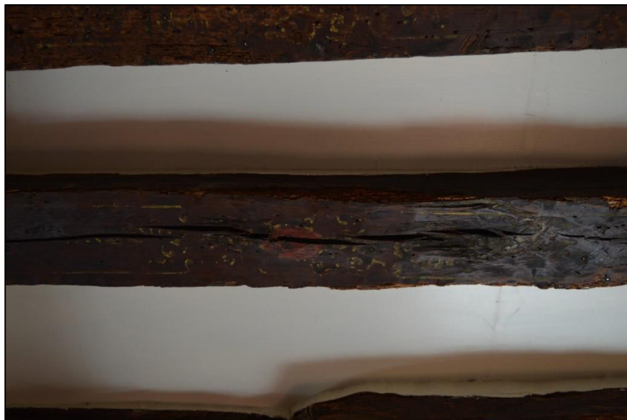
Figure 11.45 : Bâtiment D, intérieur, poutre peinte (© Lise Levieux).
