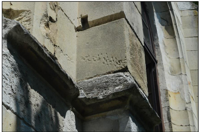
Figure 11.19 : Façade méridionale, traces d'outils (© Lise Levieux).
