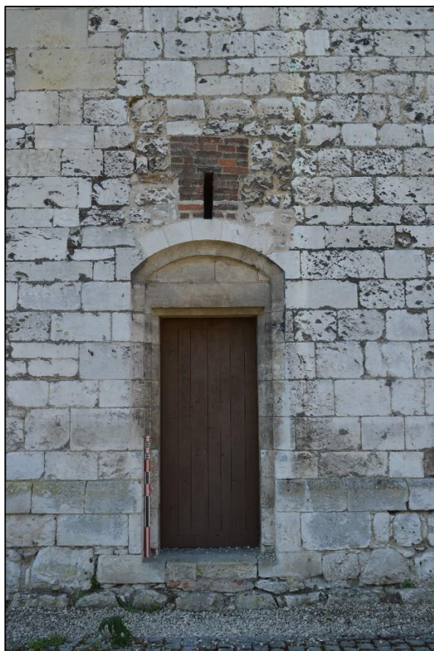
Figure 17.22 : Porte d'accès à la chapelle Sainte-Catherine (© Lise Levieux).
