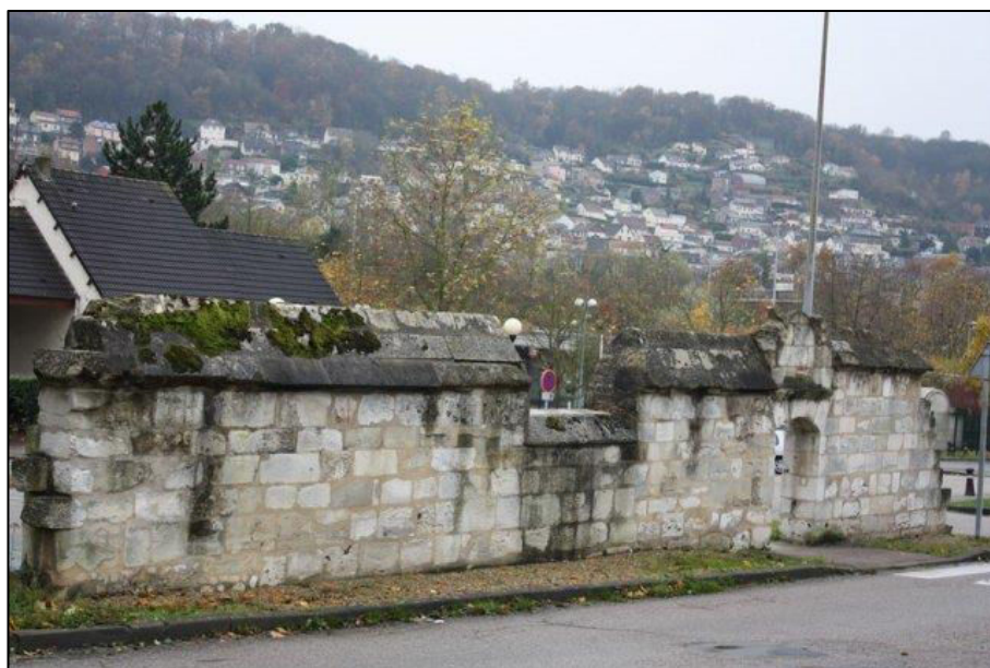
Figure 15.7 : Le mur d'enceinte ( www.patrimoines-rouen-normandie.fr ).
