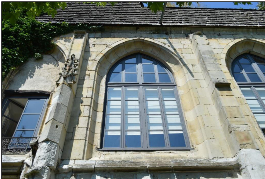
Figure 11.12 : Fenêtre de la façade méridionale (© Lise Levieux).
