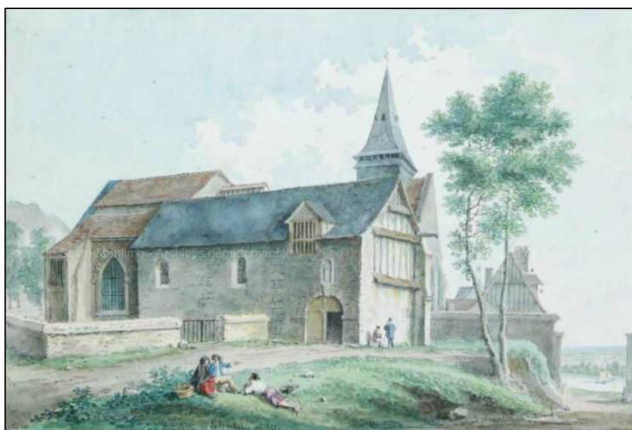
Figure 6.22 : Vue latérale de l'église paroissiale de Saint-Paul de Rouen, du côté de la ville, 1827 (dessin : Hyacinthe Langlois) (A.D.S.M. 6 Fi 1).
