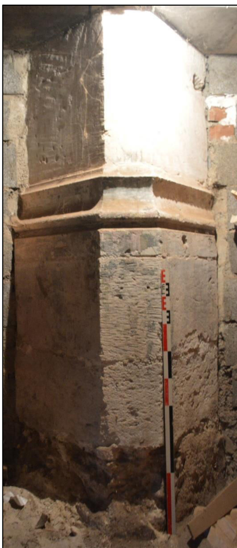
Figure 11.28 : Pilier de l'église (© Lise Levieux).
