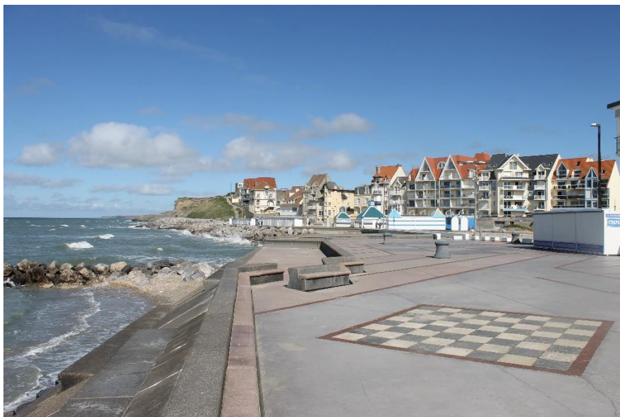
Figure 44. Le front de mer de Wimereux protégé par son perré (septembre 2020 et 2021)
