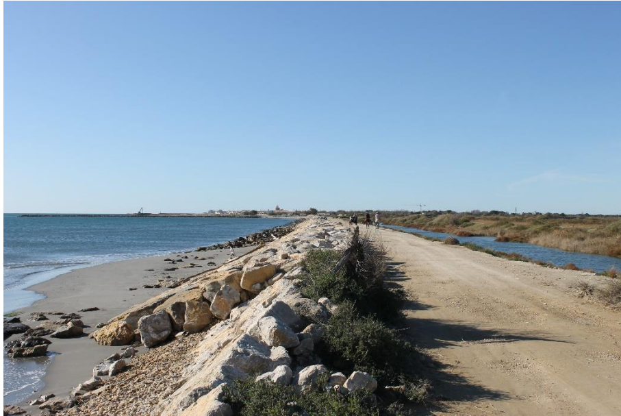
Figure 30. La Digue à la mer aux Saintes-Maries-de-la-Mer (octobre 2021) 34
