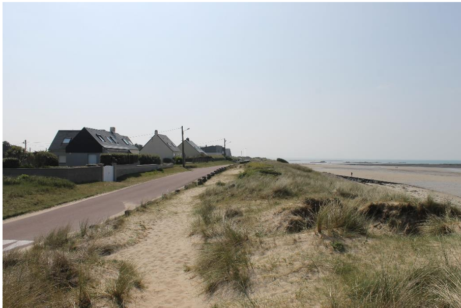
Figure 52. Le lotissement de la plage de Saint-Germain-sur-Ay protégé par un enrochement (avril 2022)
