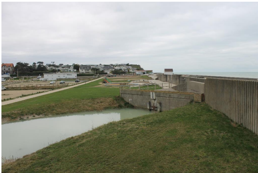
Figure 36. Le débouché de la vallée du Dun à Saint-Aubin-sur-mer, protégé par une digue et fermé par une buse (novembre 2021)
