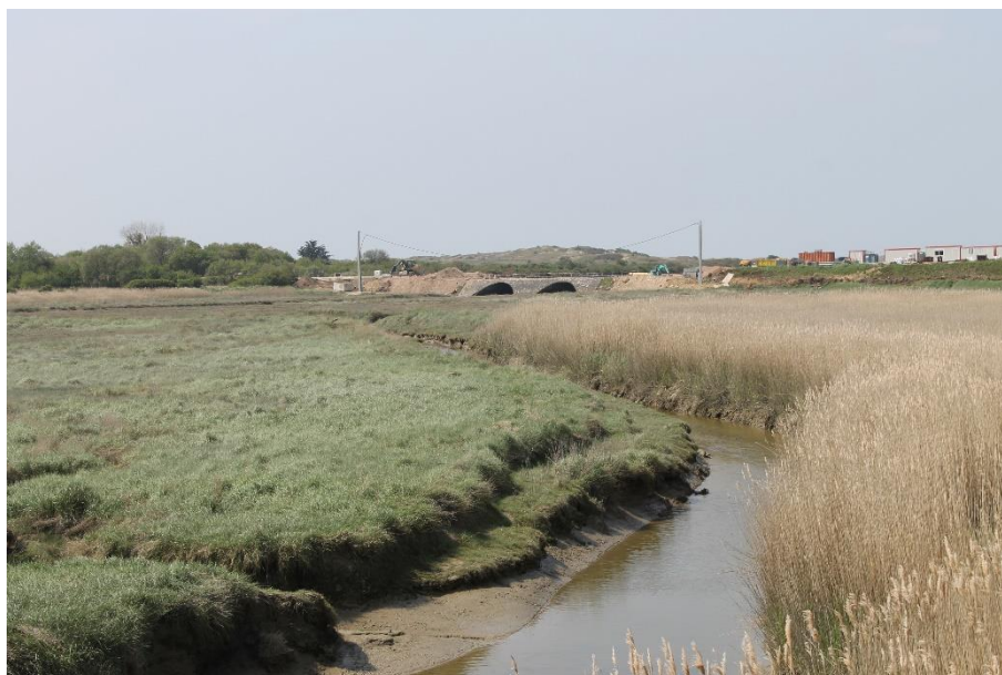
Figure 77. L'ouvrage à deux buses de Port-Bail-sur-mer, aujourd'hui réouvert (avril 2022)
