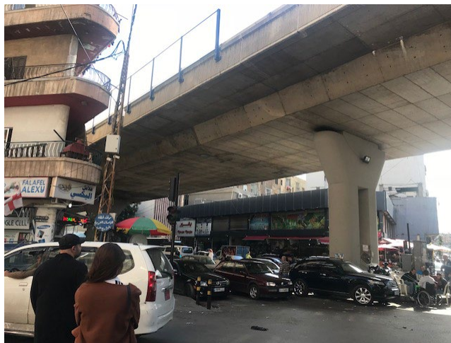
Figure 56: Au-dessous du Pont Yerevan, a Bourj Hammoud, rive droite. Source: photo prise par FAYAD, Nadine, le 12-01-2018
