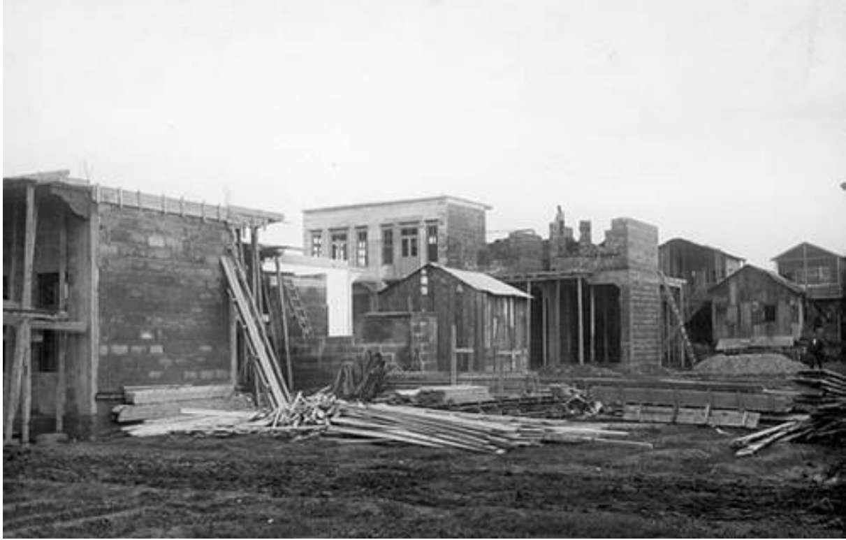
Figure 50: La construction de Nor Marach en 1930. Source : Archives de la municipalit  de Bourj Hammoud.
