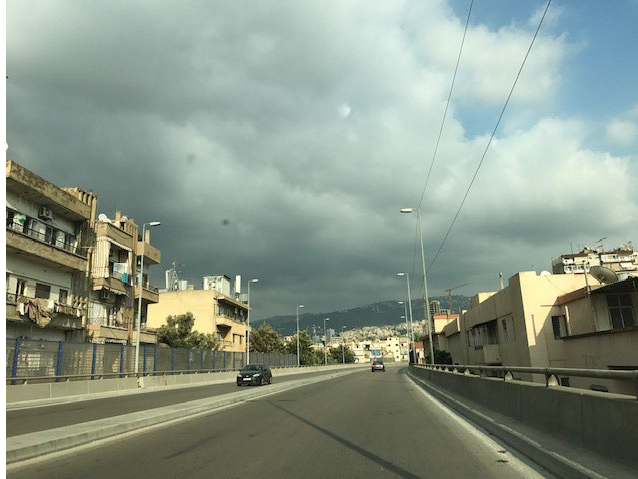
Figure 54: Le pont Yerevan. Côté Achrafiyeh, rive droite du fleuve. Source : photo prise par FAYAD Nadine, le 23-08-2017
