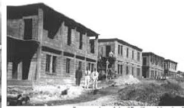
Construction des pavillons blanches
