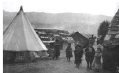
Les habitations à l'intérieur des camps
