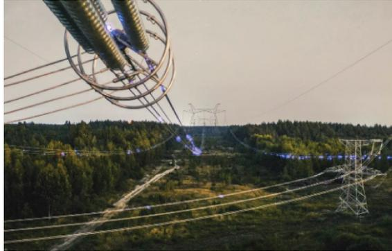
FIGURE 5.19 – Phénomène de couronne observé tout au long des câbles de transport d'électricité [Source<sup>7</sup>].
