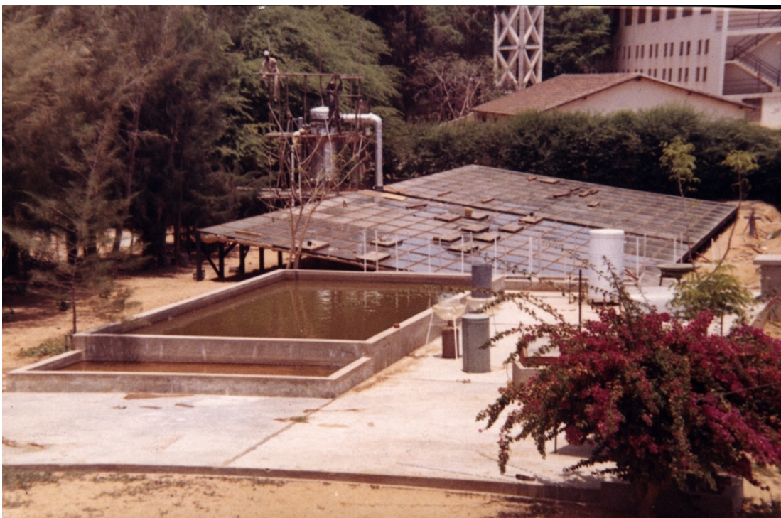
Figure 7 : l'insolateur et l'échangeur ITTEC en cours de montage à l'IPM de Dakar. Archives personnelles de Jean-Pierre Girardier. Une photographie quasiment identique est publiée dans GIRARDIER Jean-Pierre, MASSON Henri, « Le moteur solaire face au moteur diesel », Annales des Mines , mai 1967, p. 3, tiré à part, archives personnelles de Jean-Pierre Girardier.
