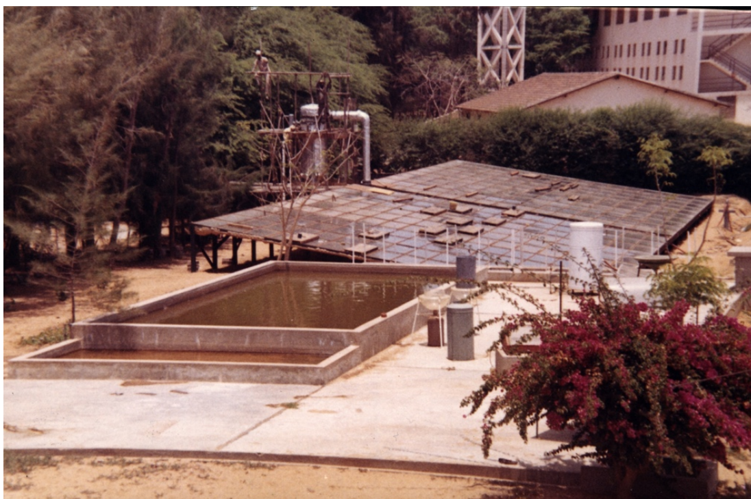
Figure 7 : l'insulateur et l'échangeur ITTEC en cours de montage à l'IPM de Dakar. Archives personnelles de Jean-Pierre Girardier. Une photographie quasiment identique est publiée dans GIRARDIER Jean-Pierre, MASSON Henri, « Le moteur solaire face au moteur diesel », Annales des Mines , mai 1967, p. 3, tiré à part, archives personnelles de Jean-Pierre Girardier.
