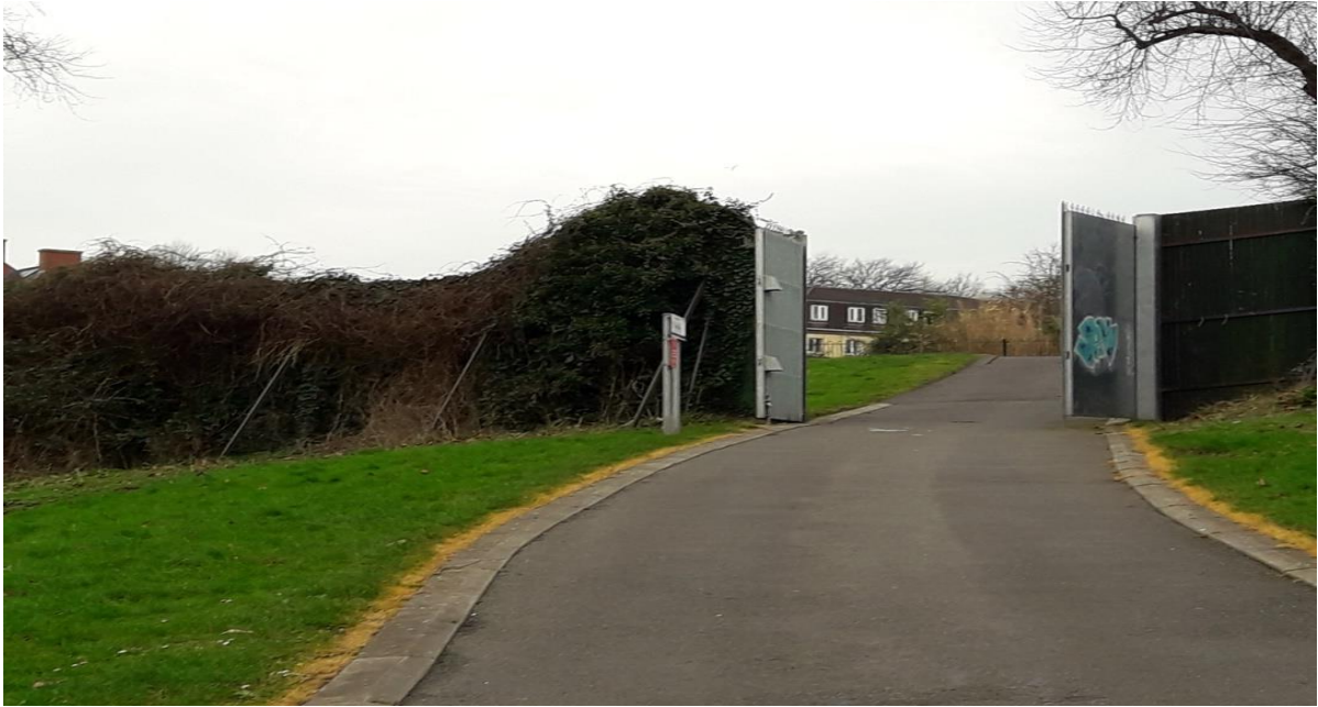
Fig. 37 : Clôture et barrière dans Alexandra Park, Belfast Nord (photo Ann Wilmot 2019).
