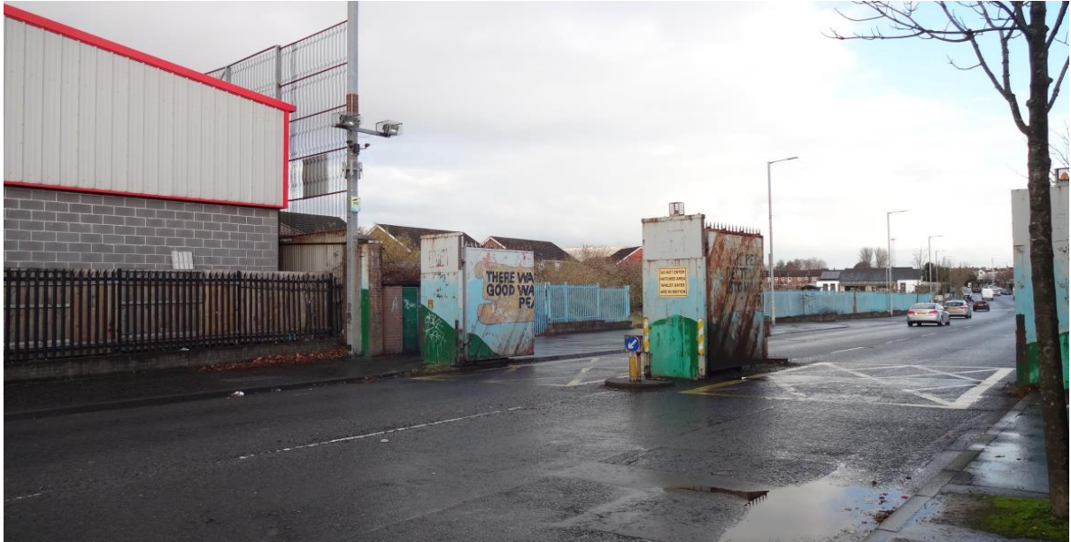
Fig. 9 : Barrière à fermeture automatique (photo Ann Wilmot 2019).
