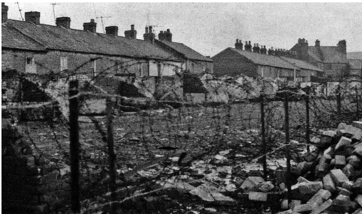
Fig 3 : Photo de la première version du mur de Cupar Way - Falls/Shankill en 1969 fermant l'accès entre Falls et Shankill. Barricade faite de barbelés à lames tranchantes, montés sur des poteaux métalliques. Cette barricade fut remplacée la même année par une construction en dur 1459 .
