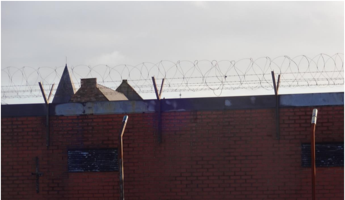
Fig. 22 : Barbelés sur un mur de division (photo Ann Wilmot 2019).
