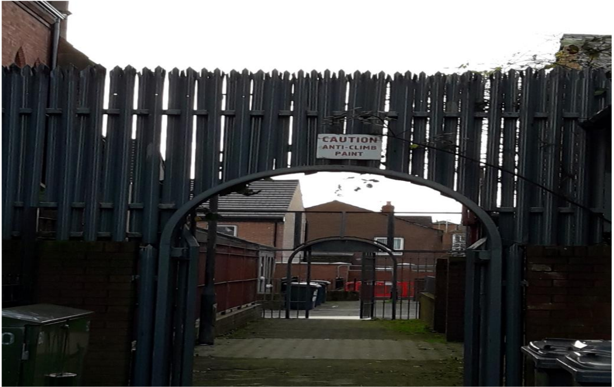
Fig. 17 : Peinture anti-escalade sur une clôture de passage piéton (photo Ann Wilmot 2019).
