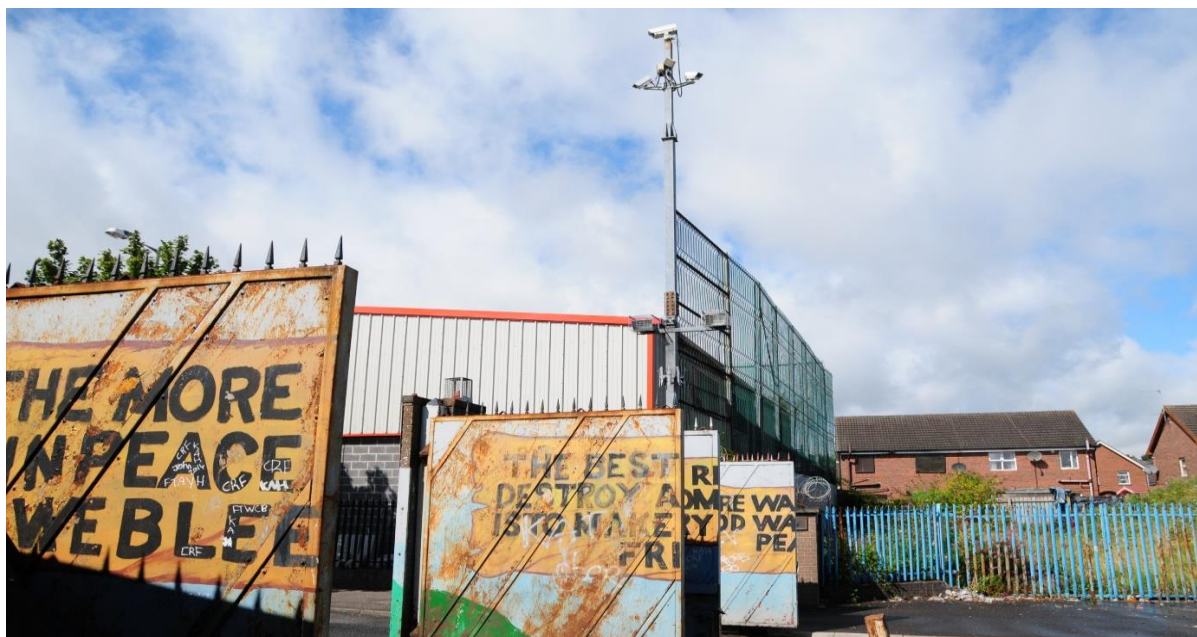
Fig. 48 : Barrières contrôlées électroniquement : de 4 mètres de hauteur et de 10 mètres de largeur, surmontées de treillis métalliques et de barbelés, ainsi que d'un système de vidéo-surveillance contrôlant l'accès de Larnark Way par Springfield Road , Belfast : Construction : 1988 1469 (photo Ann Wilmot 2018).
