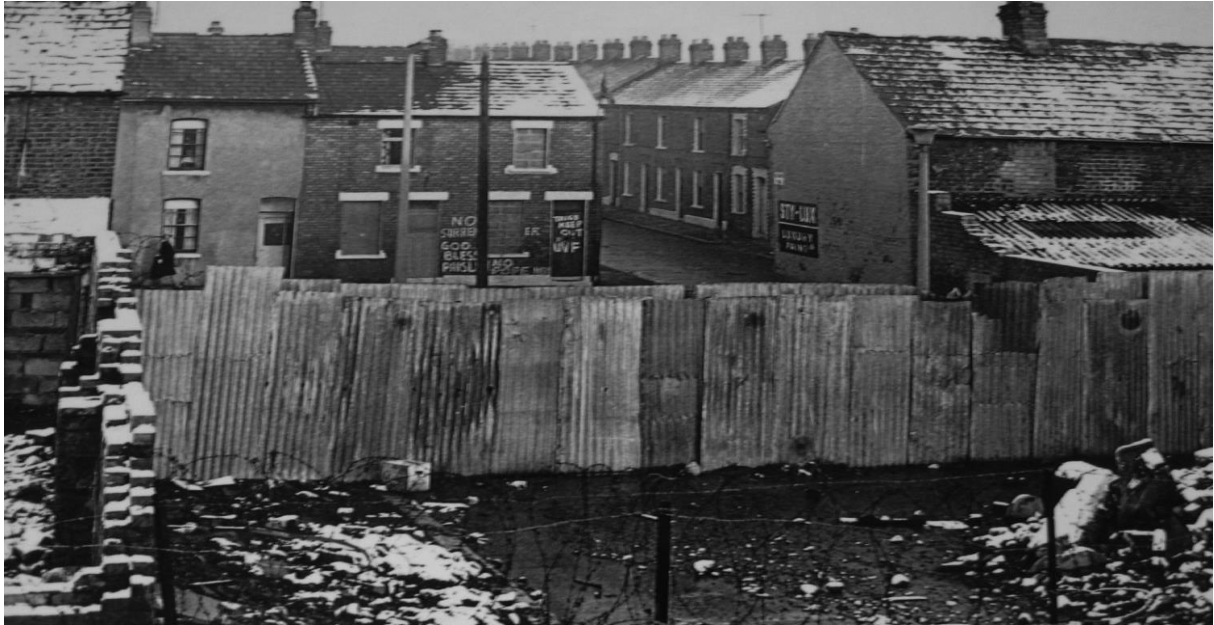
Fig. 5 : Bombay Street/Kashmir Road : séparations en tôles ondulées - 1970 1461 .
