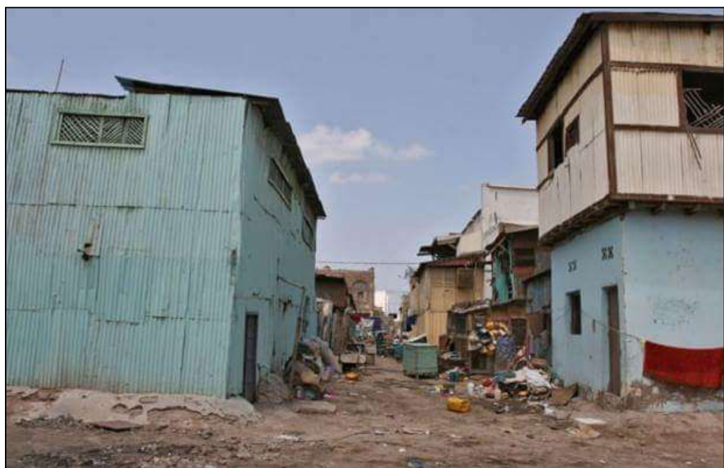
Photo 20 : Maisons en baraques habitées par les migrants à Ambouli (Ismael O.,2012)
