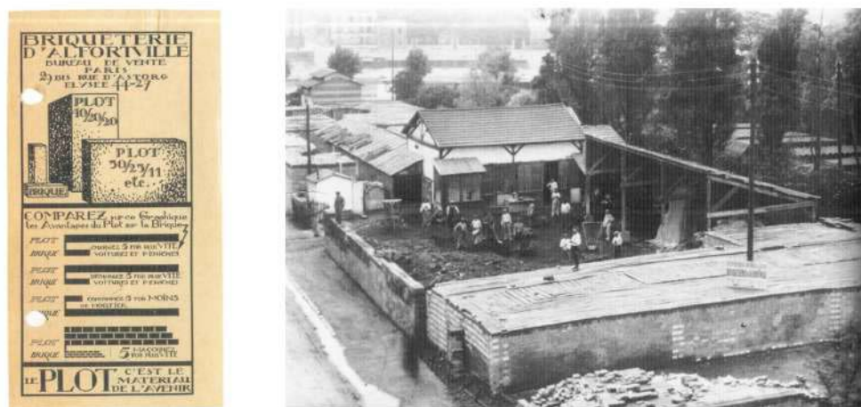
Fig. 34 : Publicité pour la briqueterie d'Alforville et lieu de production (1919), images tirées de l'ouvrage de Jean Louis Cohen Le Corbusier Le Grand - ©Fondation Le Corbusier
