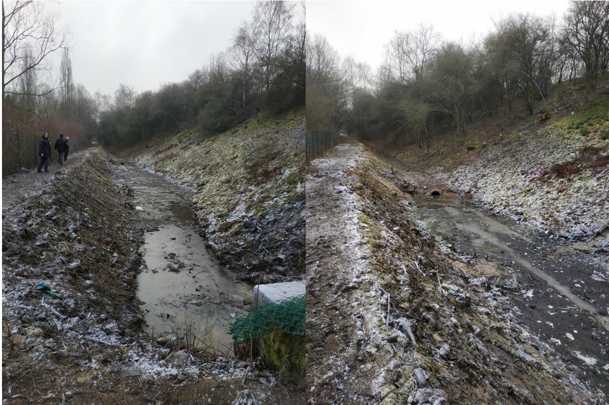
Figure II.9 : Bassin non bâché de Marcoussis A (SUO) et zoom, à droite, sur le fossé en terre drainait les eaux de la route subjacente (01/2020).
