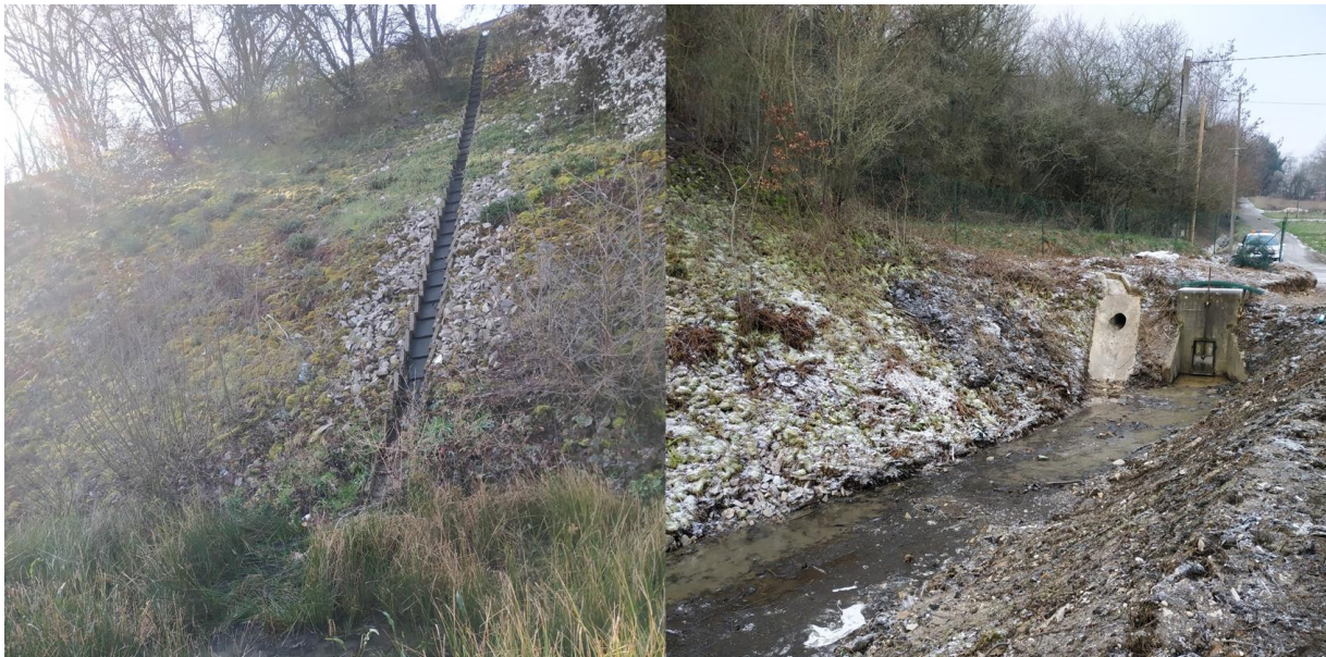
Figure II.10 : Photographies de la descente tuilée se jetant directement depuis la N104 jusqu'à Marcoussis A à gauche (03/2021) et exutoire + buse d'apport d'eau de ruissellement de la route à droite (01/2020)
