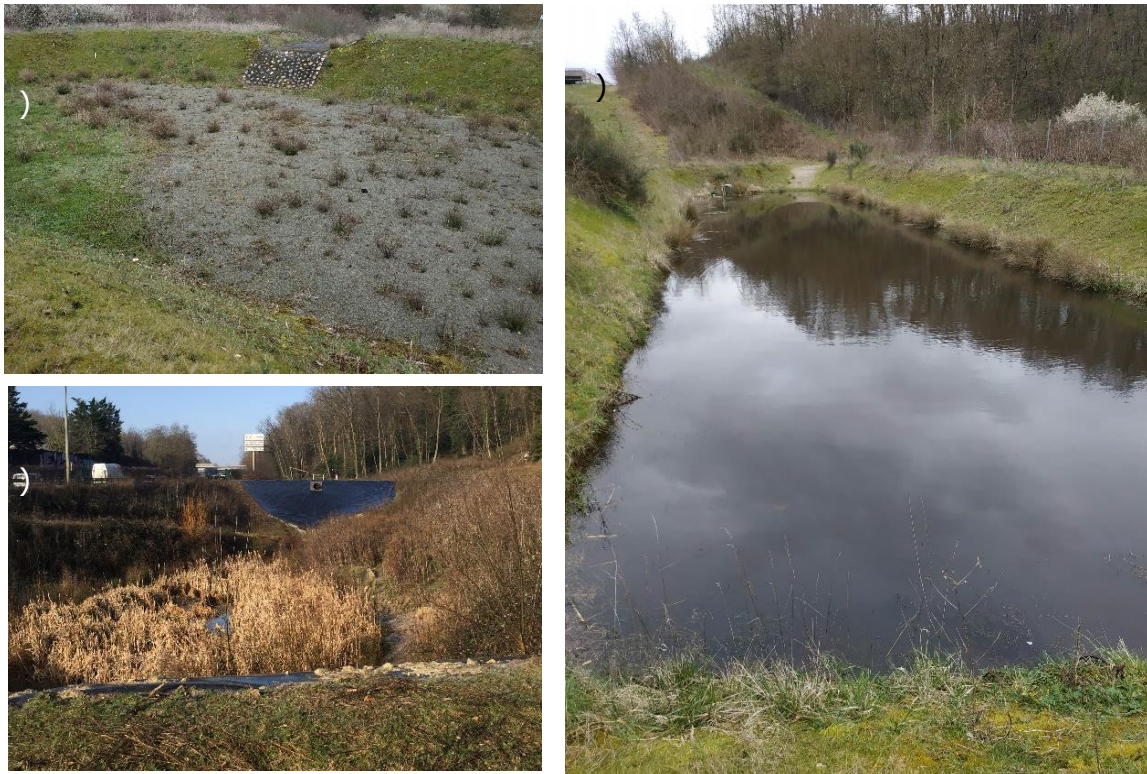
Figure I.4 : Photographie du a) bassin de filtration drainant l'A10 à Bréthencourt, b) bassin permanent de décantation et de régulation hydraulique drainant la N118 à Orsay, c) Bassin permanent de décantation drainant l'A10 à Bréthencourt
