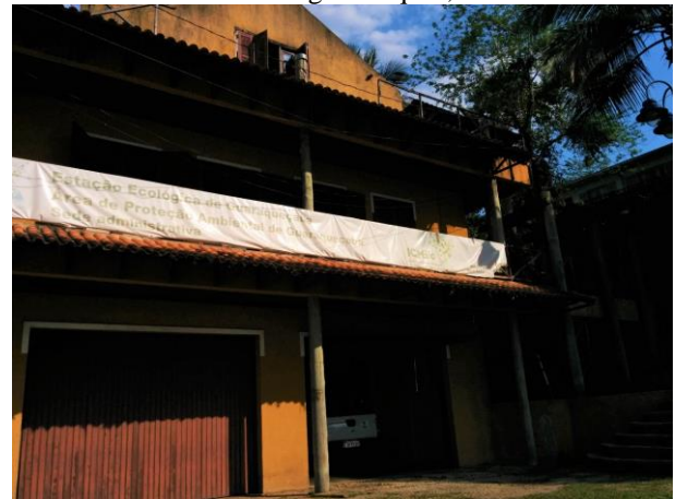
Photo : Manuelle Lago Marques, octobre 2015
