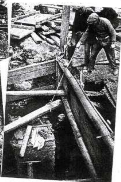
Der Stollengang vor der Kirche wird ausgefüllt.
