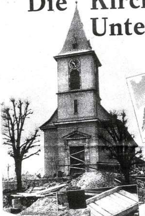
Der Kirchhügel von Biesel, der einstürzen droht.
