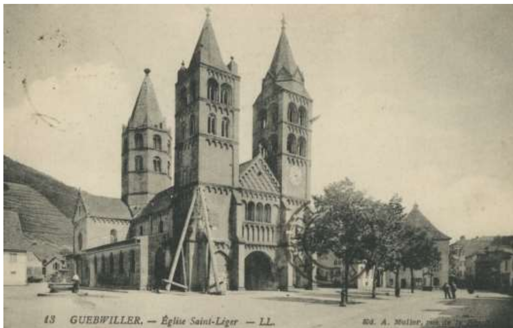
Figure 40 - Renforts mis en place sur la façade de l'église Saint-Léger de Guebwiller.
