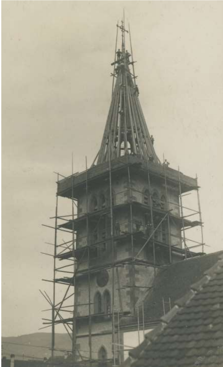
Figure 51 - Vue de la restauration du clocher de l'église de Munster.
