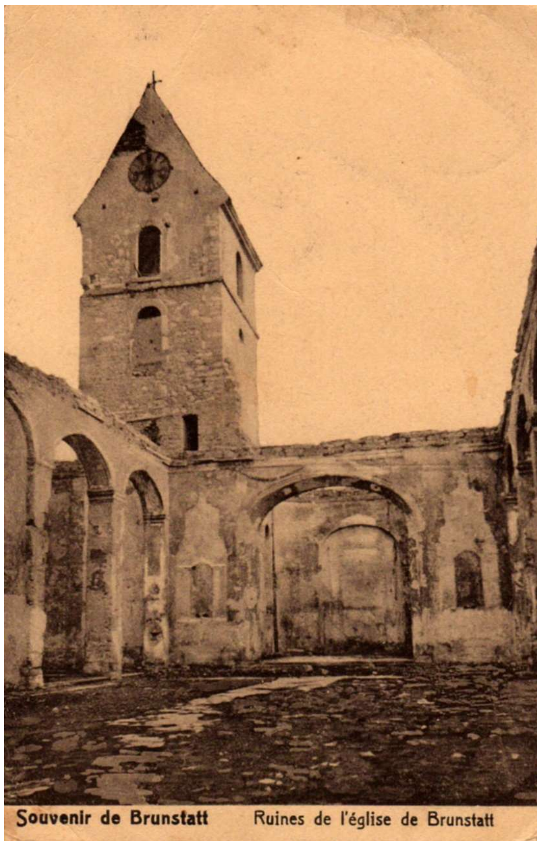
Figure 46 - État de l'église de Brunstatt après l'incendie de la nuit du 26 au 27 décembre 1916. Seuls les murs et le clocher subsistent encore.
