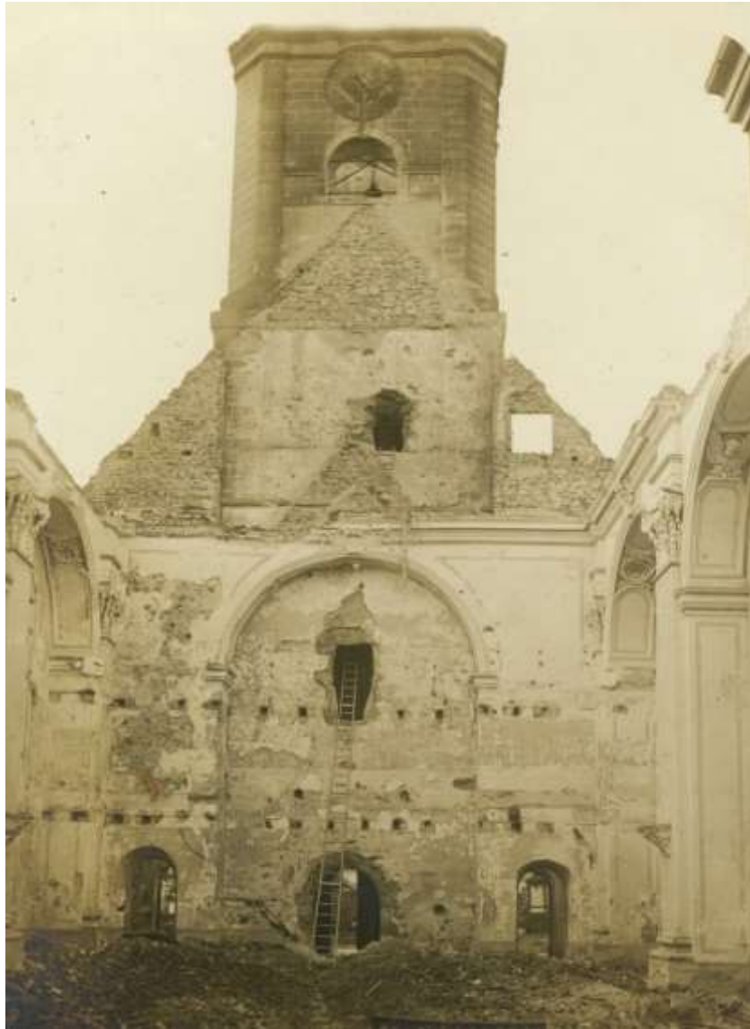
Figure 3 - Église de Reiningue. Des échelles permettent d'accéder au clocher endommagé.
