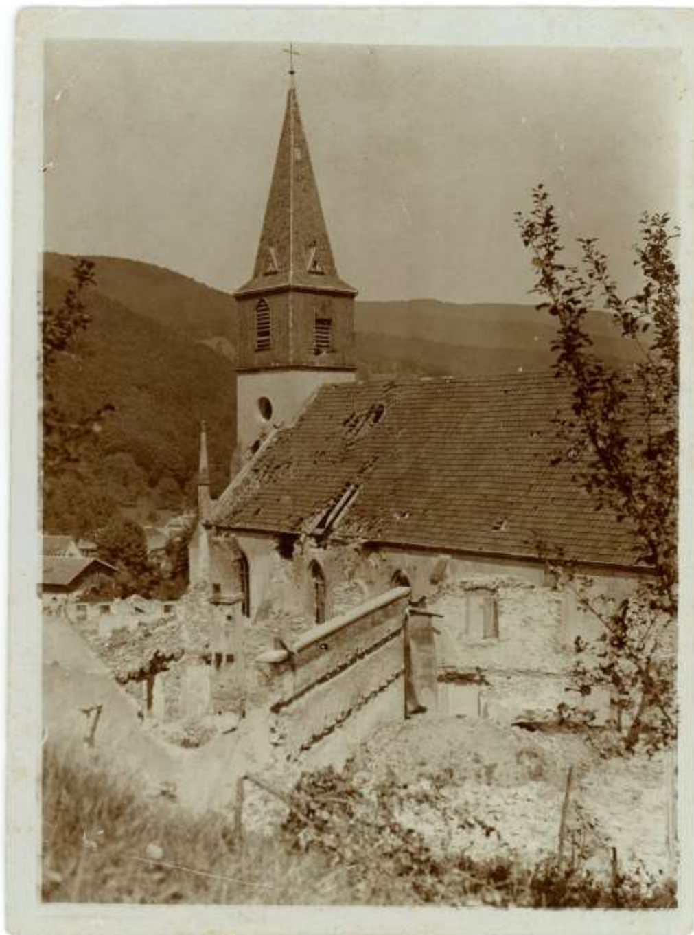
Figure 23 - État de l'église de Sengern en juillet 1916. Bien qu'elle présente quelques dégâts au niveau de la toiture, elle est relativement épargnée par rapport au bâtiment au premier plan.
