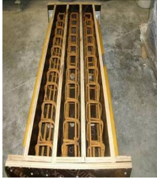
(a): Avec armatures transversales
