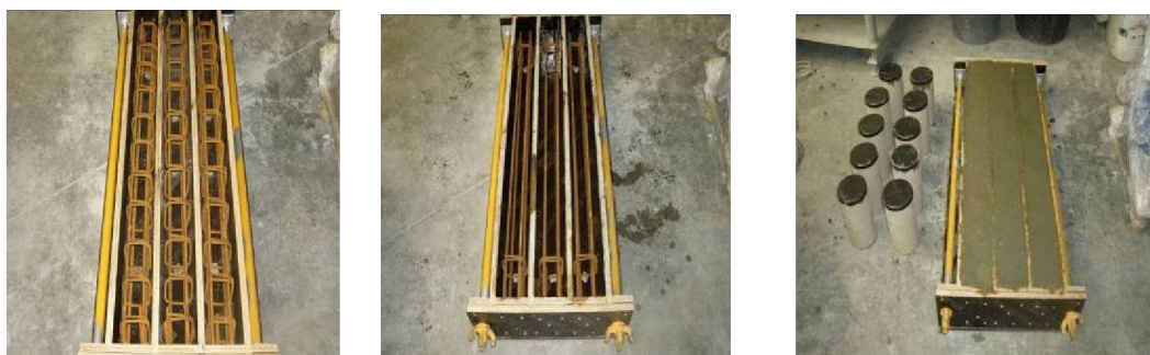
(a) poutres avec cadres (b) poutres sans cadres (c) coulage des poutres en BHP fibré
