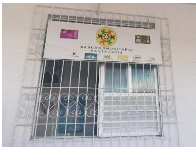
Figure 67. Façade de la BCD Santa Luzia
