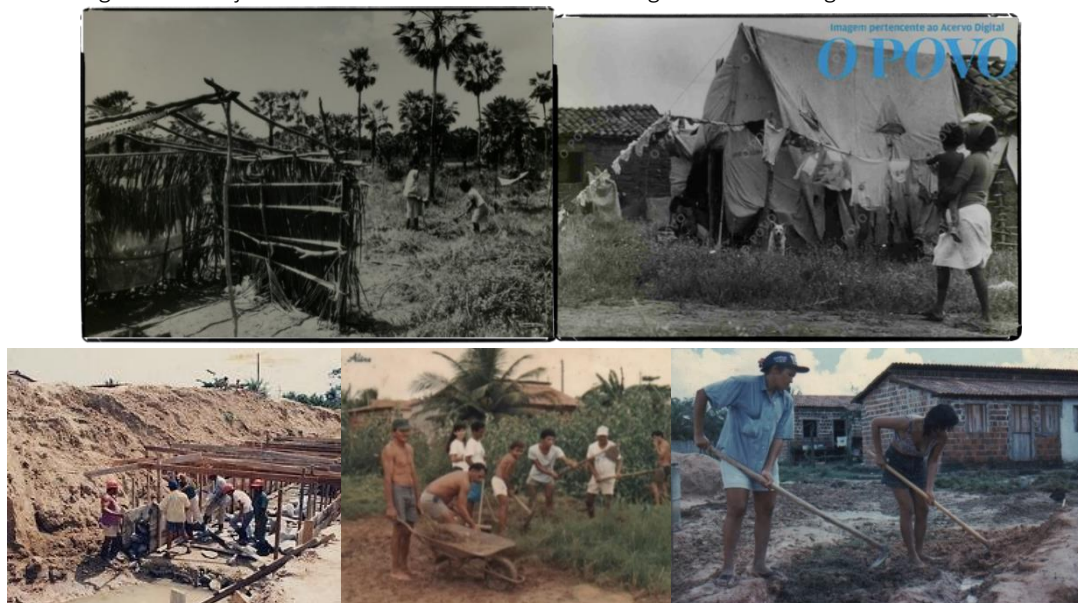
Figure 41. Conjunto Palmeira avant son urbanisation grâce à l'auto-organisation de ses habitants
