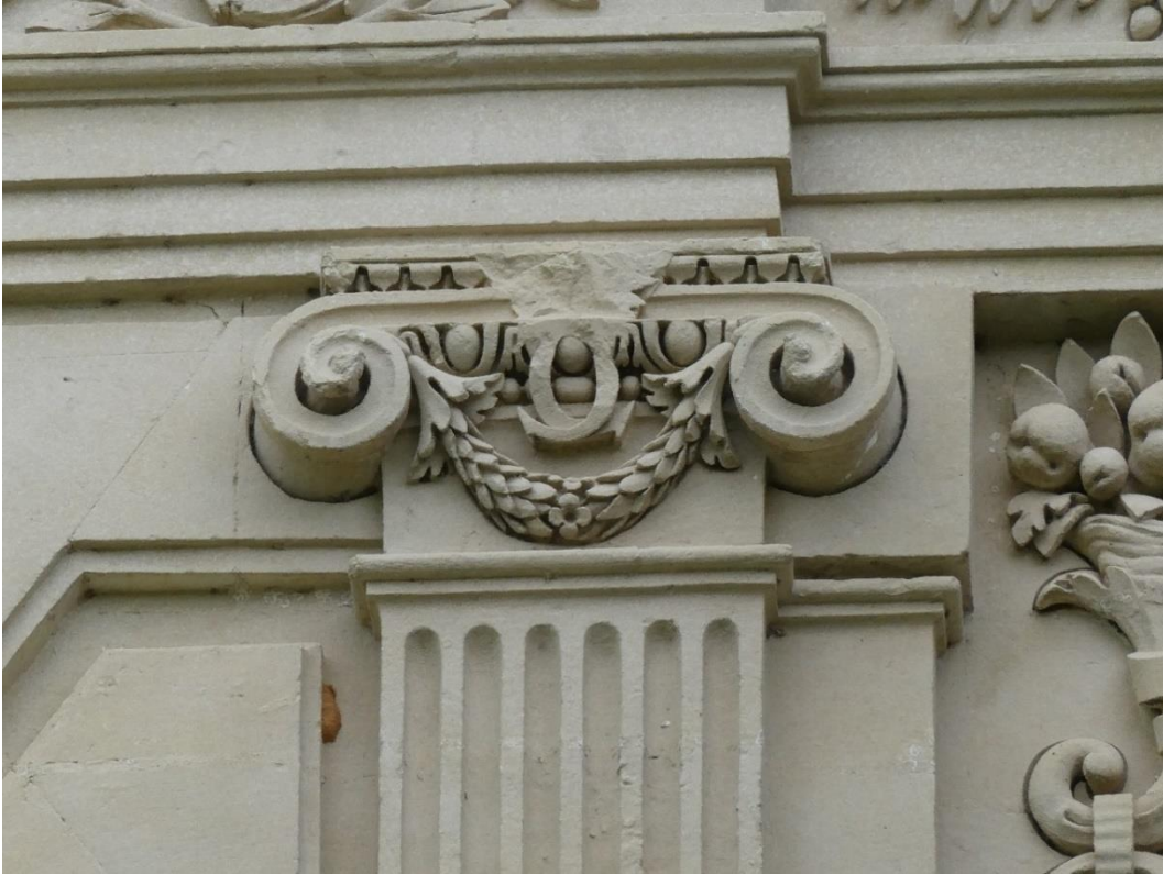
Figure 52 : Chapiteau ionique de la façade méridionale, au niveau pavillon du grand escalier, du château de Brissac, vers 1620-1625. Cl. Jessy Jouan, 2019.
