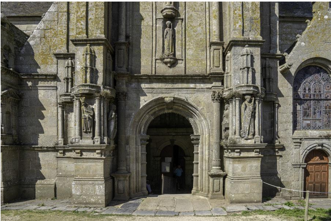
Figure 91 : Porche sud de l'église Notre-Dame de Saint-Thégonnec (Finistère), 1599. Source : Wikimedia Commons.
