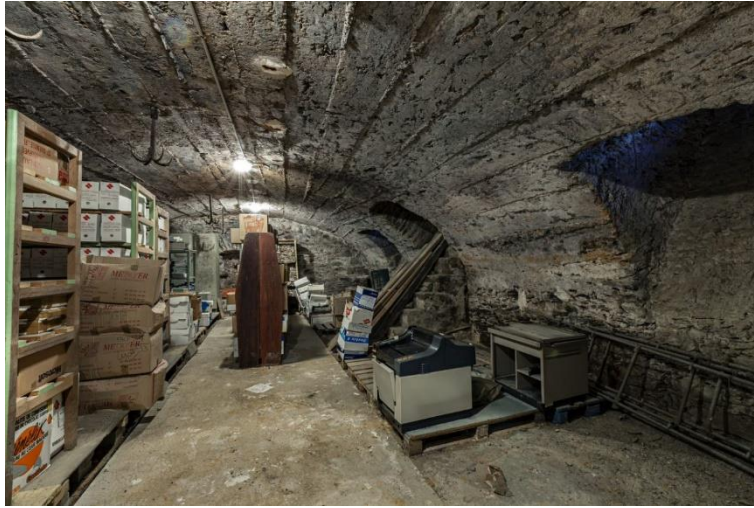
Figure 178 : Cave voûtée de l'aile sud-ouest de l'ancien couvent des ursulines et ses crochets de suspension de viande. Cl. Yves Guillotin, Inventaire du Patrimoine des Pays de la Loire, 2019, IVR52_20195301093NUCA.
