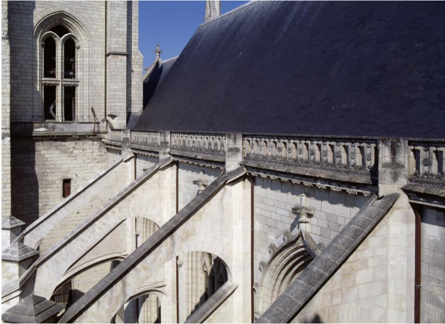
Figure 118 : Sommet du mur gouttereau sud de la nef de la cathédrale Saint-Pierre de Nantes avec sa balustrade mise en œuvre entre 1626 et 1631. Cl. Patrice Giraud et Denis Pillet, Inventaire du Patrimoine des Pays de la Loire, IVR52_19914401584XA.
