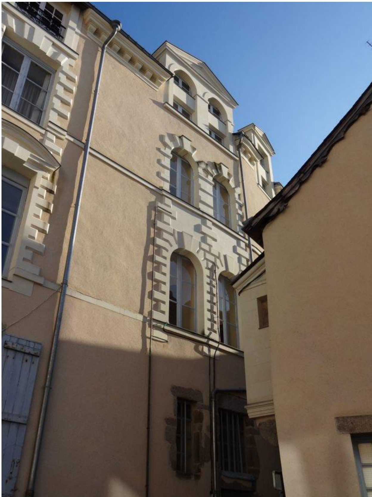
Figure 199 : Travée de l'escalier principal de la maison de la Bazoche. Cl. Jessy Jouan, 2020.
