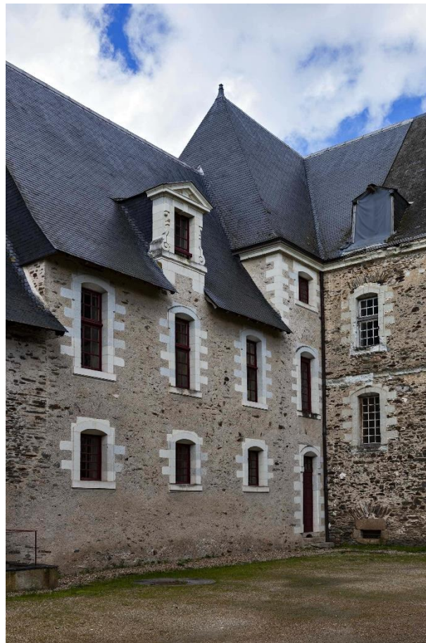
Figure 274 : Élévations sur l'arrière-cour du pavillon de liaison entre les manoirs médiévaux et l'aile sud-ouest sur le nouveau cloître. Cl. Yves Guillotin, Inventaire du Patrimoine Région Pays de la Loire, 2020, IVR52_20205300151NUCA.
