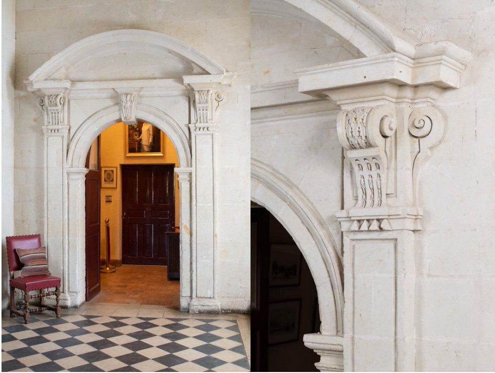
Figure 31 : Porte palière du niveau R conduisant vers l'appartement du grand corps de logis méridional depuis le grand escalier du château de Brissac. Cl. Armelle Maugin, Département du Maine-et-Loire, Inventaire du Patrimoine des Pays de la Loire, 2021, IVR52_20214900128NUCA & IVR52_20214900137NUCA.
