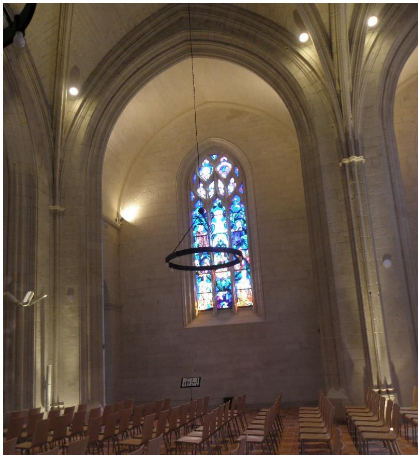
Figure 132 : Vue de la nef et du bas-côté sud de la chapelle des minimes de Nantes. Source : Le Voyage à Nantes, 360image.fr.
