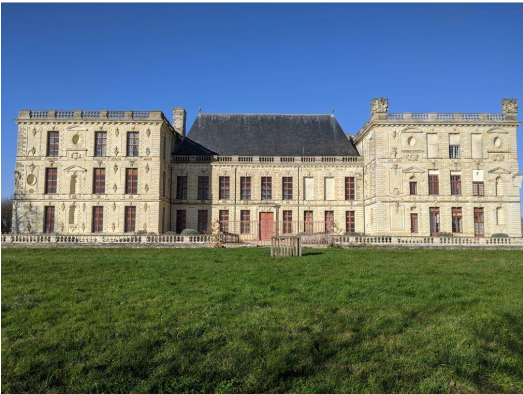
Figure 64 : Élévations sur jardin du château d'Oiron (Deux-Sèvres) avec à gauche, à l'angle du pavillon du roi, les armes des Gouffier et à droite, le même motif laissé en attente, 1620-1642. Source : Internet.
