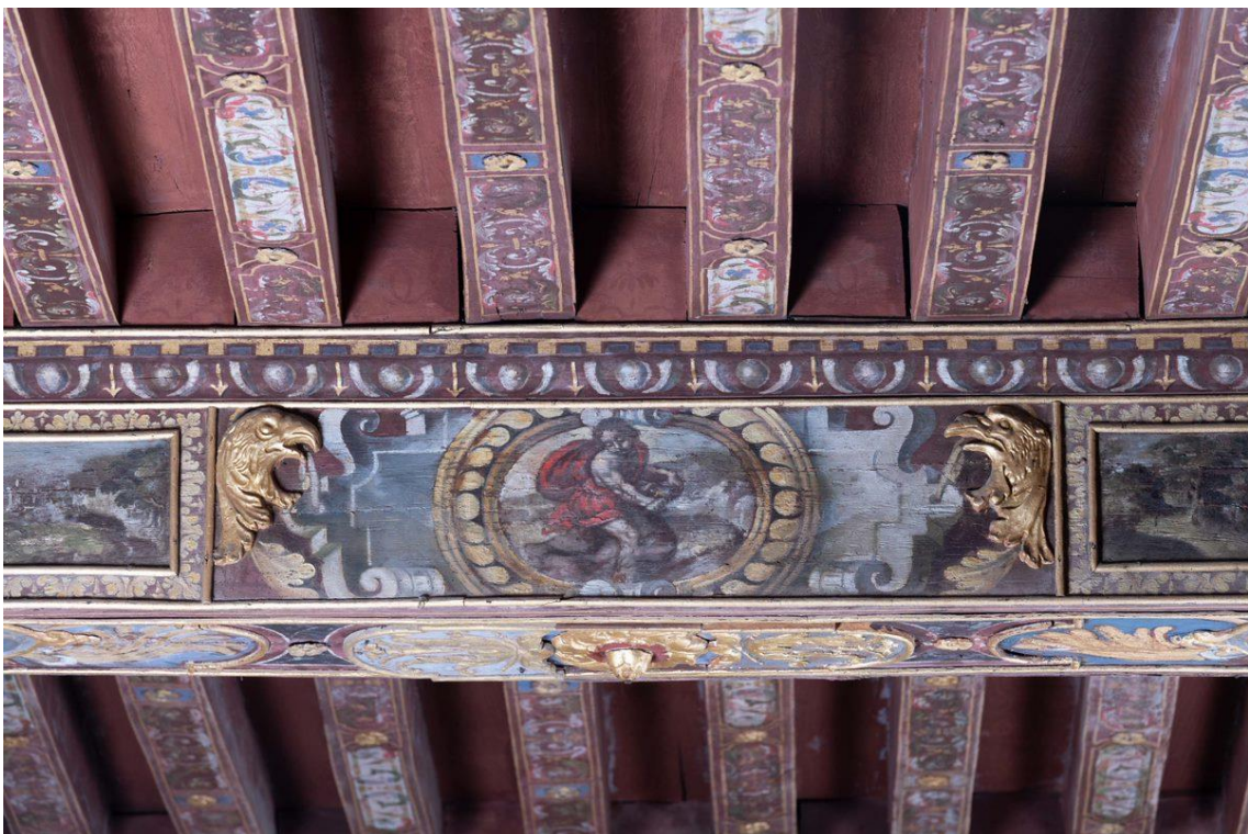
Figure 24 : Détail du plafond peint à la française de la grande galerie du château de Brissac, vers 1615-1625. Cl. Armelle Maugin, Département du Maine-et-Loire, Inventaire du Patrimoine des Pays de la Loire, 2021, IVR52_20214900149NUCA.
