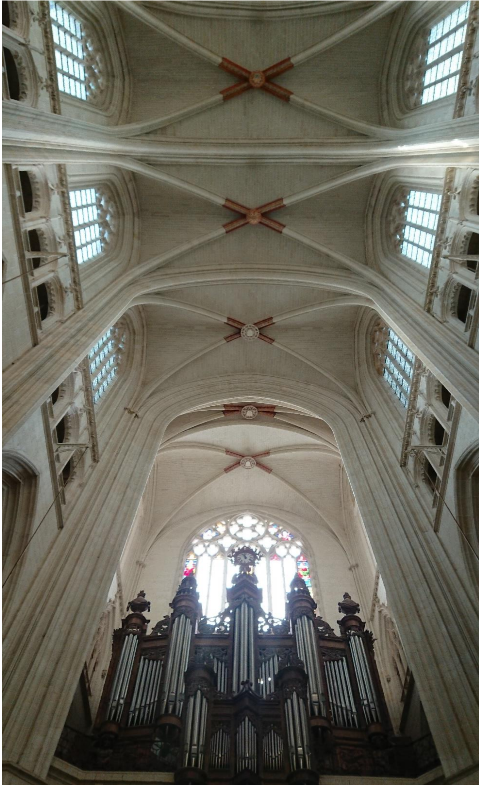
Figure 114 : Grandes voûtes de la nef de la cathédrale Saint-Pierre de Nantes vers la tribune d'orgue. La travée de la grande baie axiale (fin XV e siècle) a servi de modèle aux travées de la nef. Cl. Jouan Jessy 2018.
