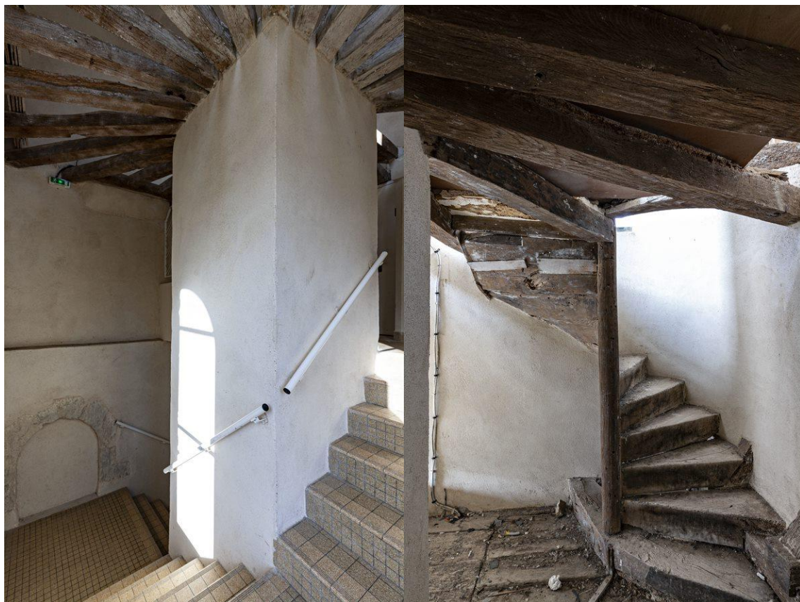
Figure 177 : Terminaison de l'escalier nord-ouest de l'ancien couvent avec un escalier secondaire en bois menant à une salle haute, ou étude, avec cheminée. Cl. Yves Guillotin, Inventaire du Patrimoine des Pays de la Loire, 2019, IVR52_20195301061NUCA & IVR52_20195301092NUCA.
