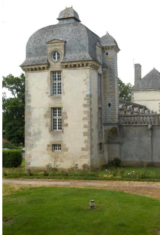
Figure 137 : Vue du pavillon sud du château de Beaumanoir à Évran (Côtes d'Armor), Cl. Norbert Lambart, Inventaire du Patrimoine de la Région Bretagne, 2011, IVR53_20112200711NUCA.
