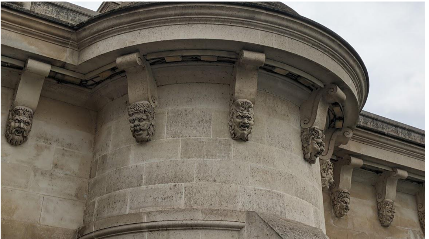
Figure 122 : Figures de grotesques ou mascarons servant de culot portant les consoles du Pont-Neuf de Paris (1578-1607). Cl. Jessy Jouan, 2021.
