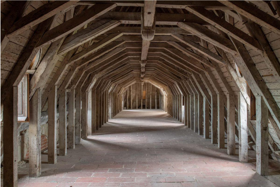
Figure 19 : Vue de la charpente de l'aile de la galerie du château de Brissac. Cl. Armelle Maugin, Département du Maine-et-Loire, Inventaire du Patrimoine des Pays de la Loire, 2021, IVR52_20214900041NUCA.
