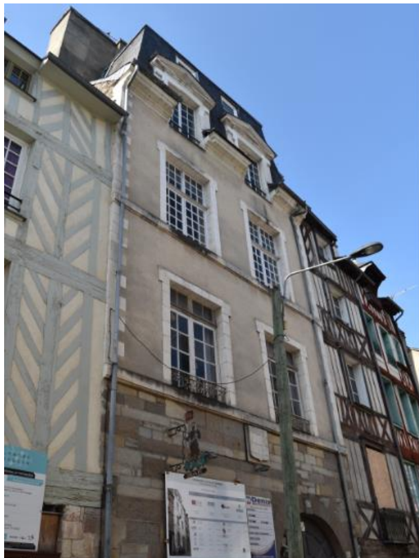
Figure 574 : Auteur inconnu, Maison située au n°26 de la rue Saint-Georges, Rennes, seconde moitié du XVII e siècle. Source : POP dossier PA00090724.
