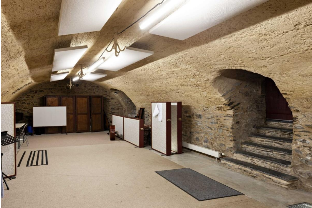
Figure 282 : Vue de l'ancienne cave de stockage dotée de crochets à suspendre les denrées, située dans l'aile sud-ouest du couvent. Cl. Yves Guillotin, Inventaire du Patrimoine Région Pays de la Loire, 2020, IVR52_20205300074NUCA.
