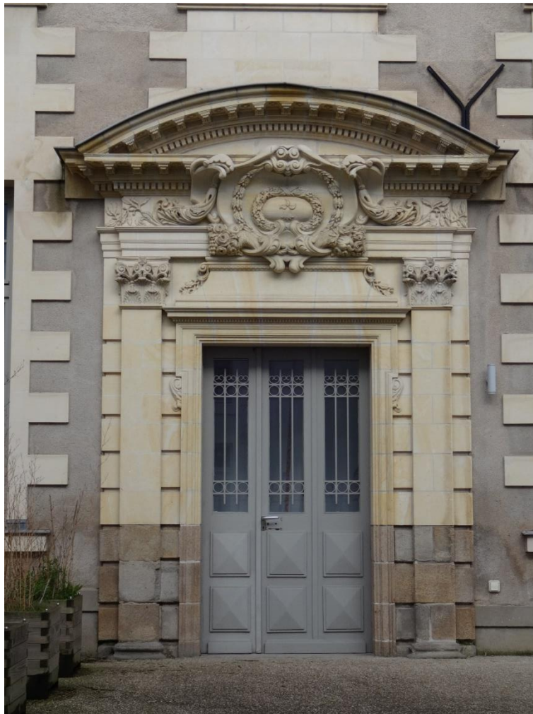
Figure 504 : Détail de la porte d'entrée du logis sud-ouest, sur la rue Dugast Matifeux, de l'ancien couvent de la Visitation. Cl. Jessy Jouan, 2019.
