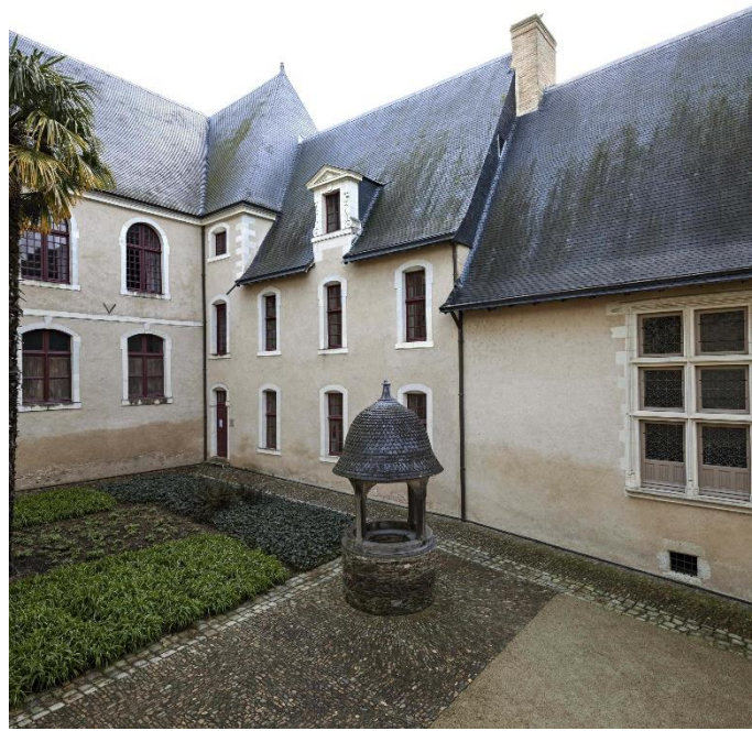
Figure 273 : Élévations des bâtiments fermant au sud et à l'est la cour du Tour : agrandissement gothique et aile du XVII e siècle dans son prolongement. Cl. Yves Guillotin, Inventaire du Patrimoine Région Pays de la Loire, 2020, IVR52_20205300173NUCA.
