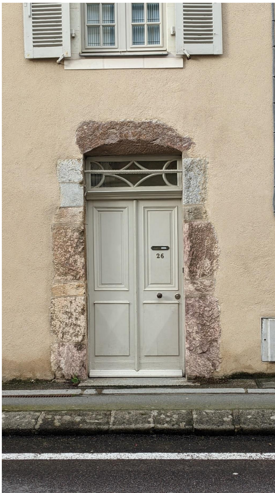
Figure 259 : Porte principale partiellement exécutée en marbre rouge, maison située au n°26 de la rue du Lycée, Laval, non datée. Cl. Jessy Jouan 2021.
