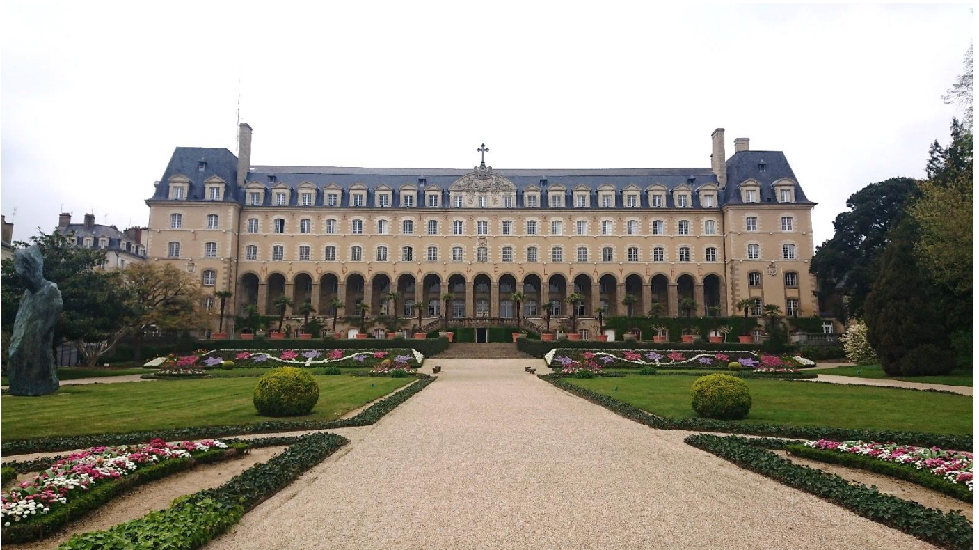
Figure 350 : Vue générale de la façade sud du palais Saint-Georges de Rennes. Cl. Jessy Jouan, 2018.
