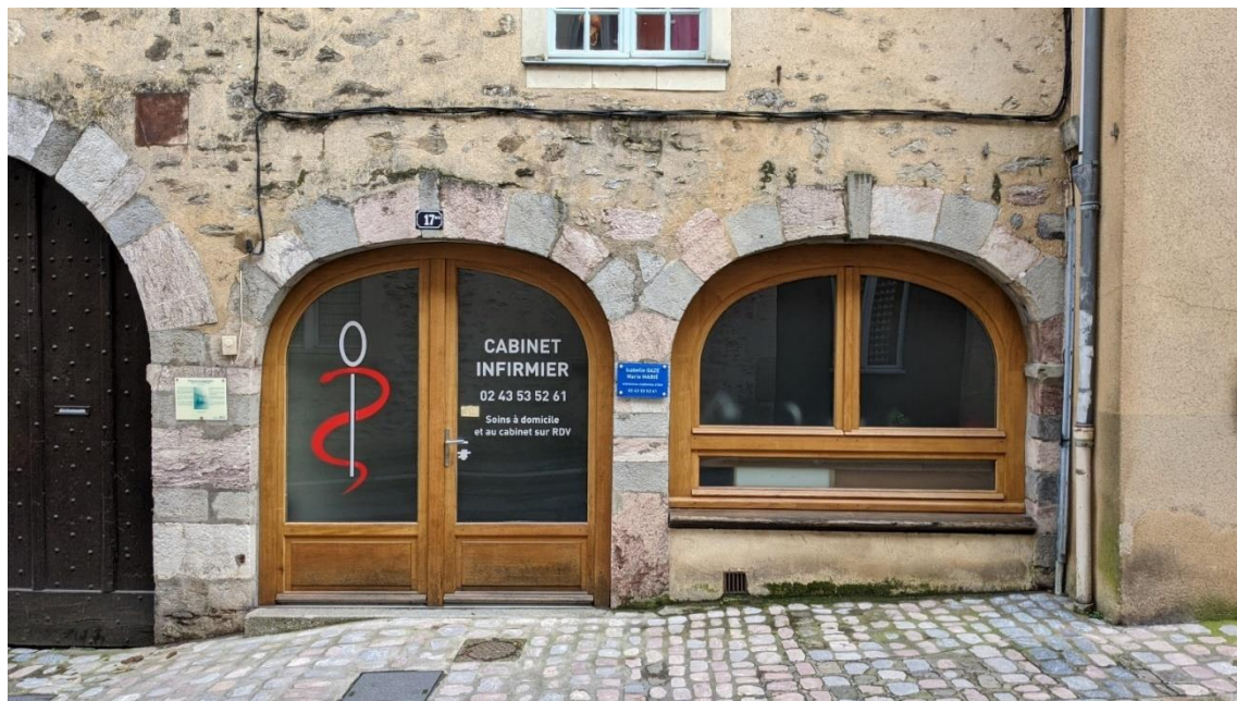
Figure 258 : Hôtel de la Barbottière, première moitié du XVII e siècle, N°17 de la rue Rennaise à Laval. Les arcades sont exécutées à partir d'une alternance de marbre rouge rose et de granit gris. Cl. Jessy Jouan, 2021.
