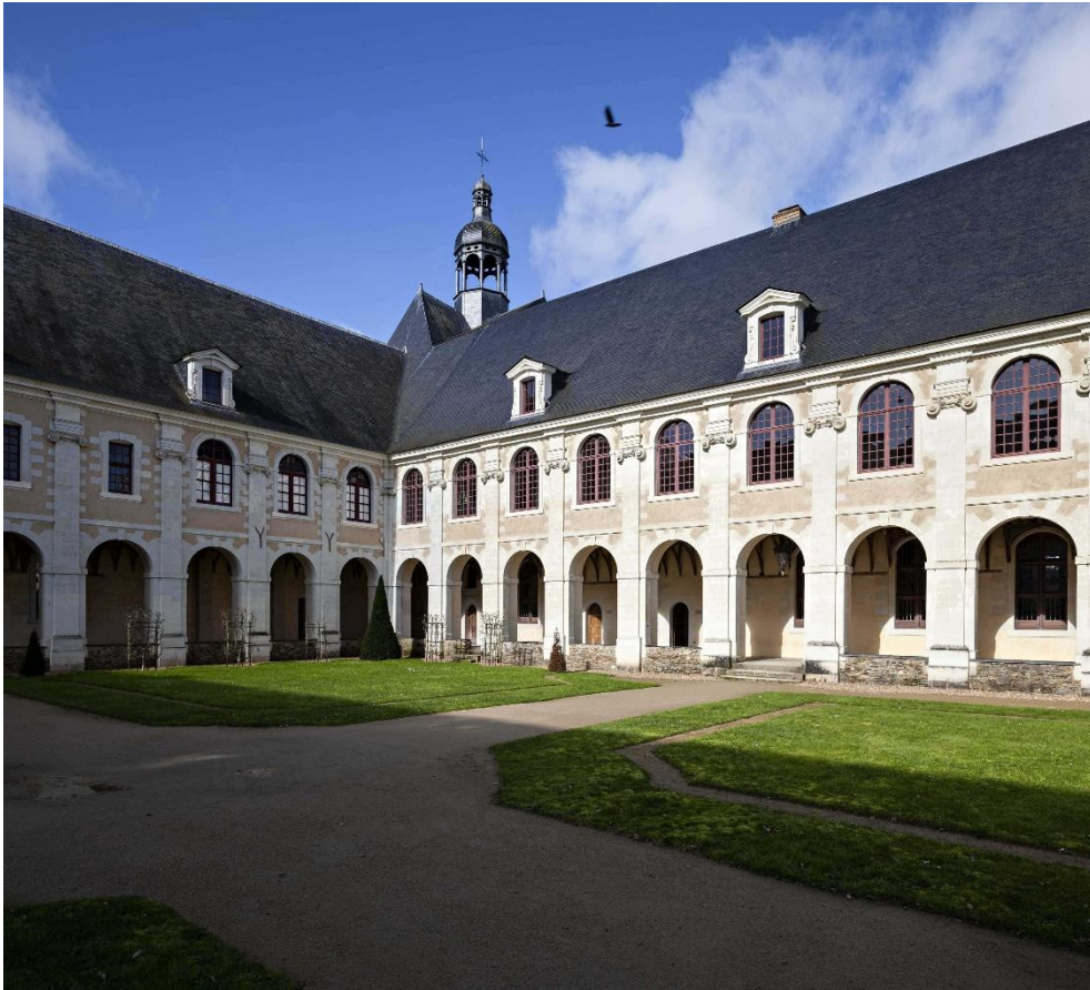
Figure 276 : Ailes sud-ouest (1642-1648) et aile nord-ouest du cloître (1658-1664). Cl. Yves Guillotin, Inventaire du Patrimoine Région Pays de la Loire, 2020, IVR52_20205300180NUCA.
