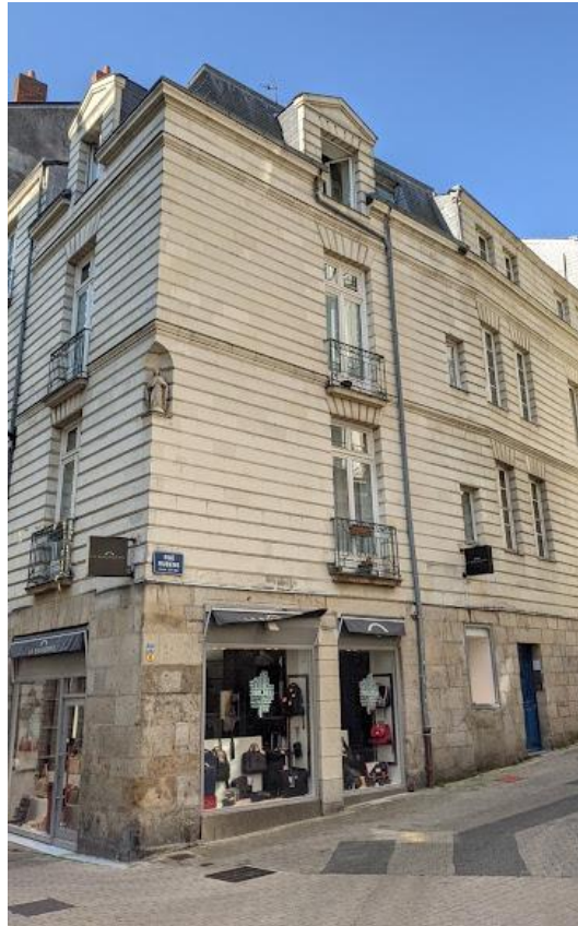
Figure 484 : Immeuble à façade traitée en bossages continus en table l'angle des rues Contrescarpe et Rubens, Nantes, fin XVII e - début XVIII e siècle. Cl. Jessy Jouan, 2021.
