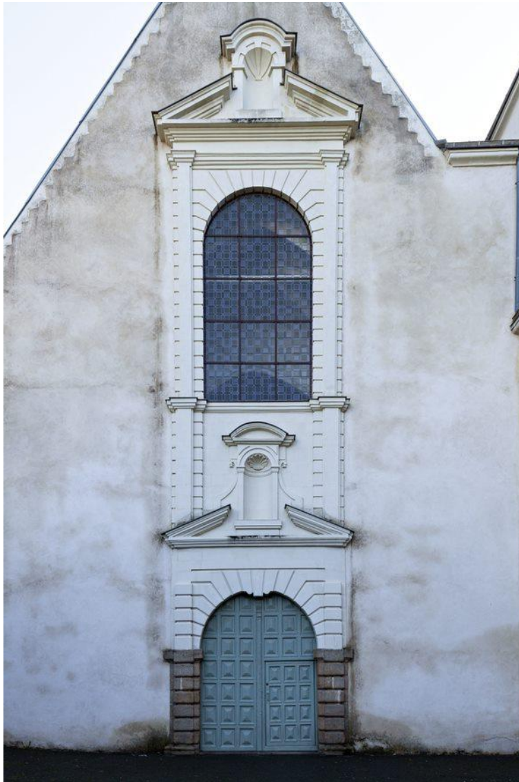
Figure 179 : Étienne Corbineau, Portail de l'ancienne chapelle du couvent des ursulines de Laval, 1621-1626 (fortement remanié). Cl. Yves Guillotin, Inventaire du patrimoine des Pays de la Loire, 2019, IVR52_20195301132NUCA.
