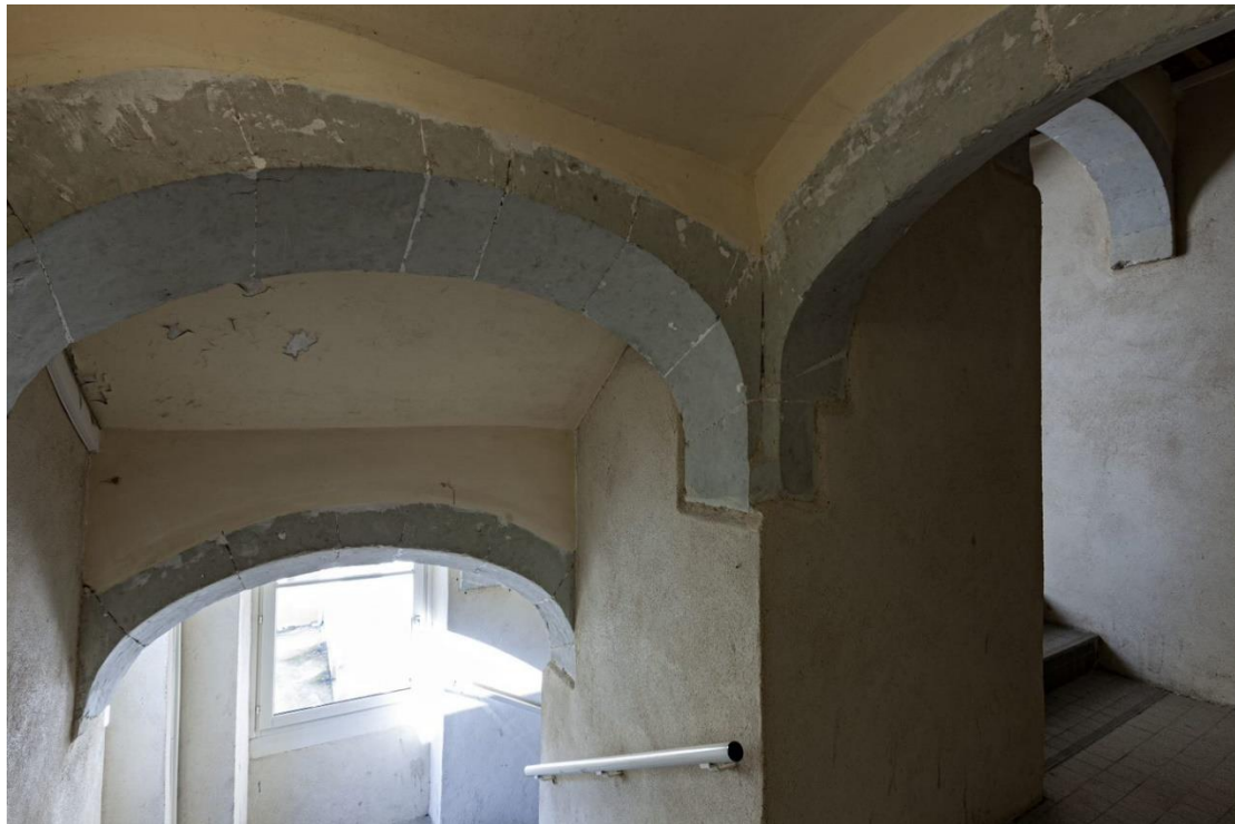
Figure 176 : Montée de l'escalier nord-ouest et son système d'arc surbaissés portant les volées. Cl. Yves Guillotin, Inventaire du Patrimoine des Pays de la Loire, 2019, IVR52_20195301091NUCA.
