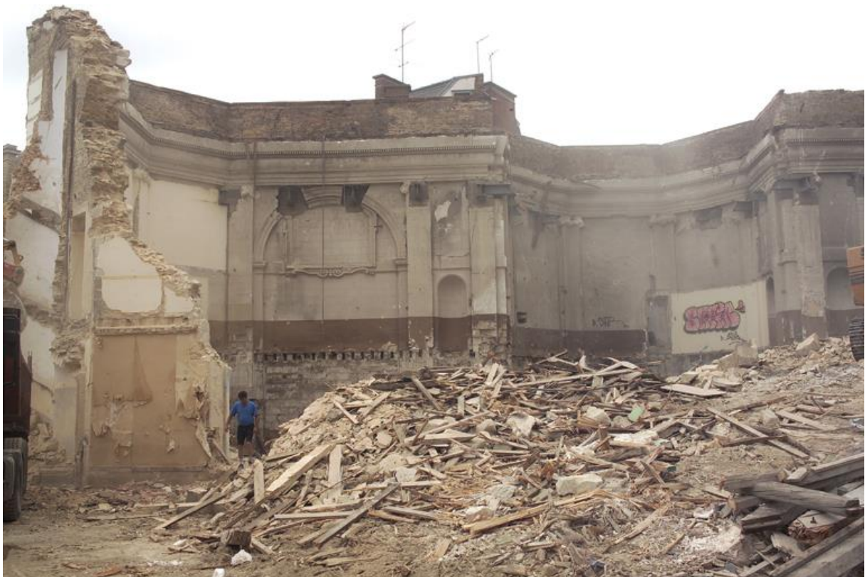
Figure 325 : Vue de l'intérieur de la chapelle. Chantier de démolition du collège de l'Immaculée, rue de la Visitation et la chapelle en ruine. Cl. Gérard Prudor, Musée de Bretagne, Rennes, 2004.
