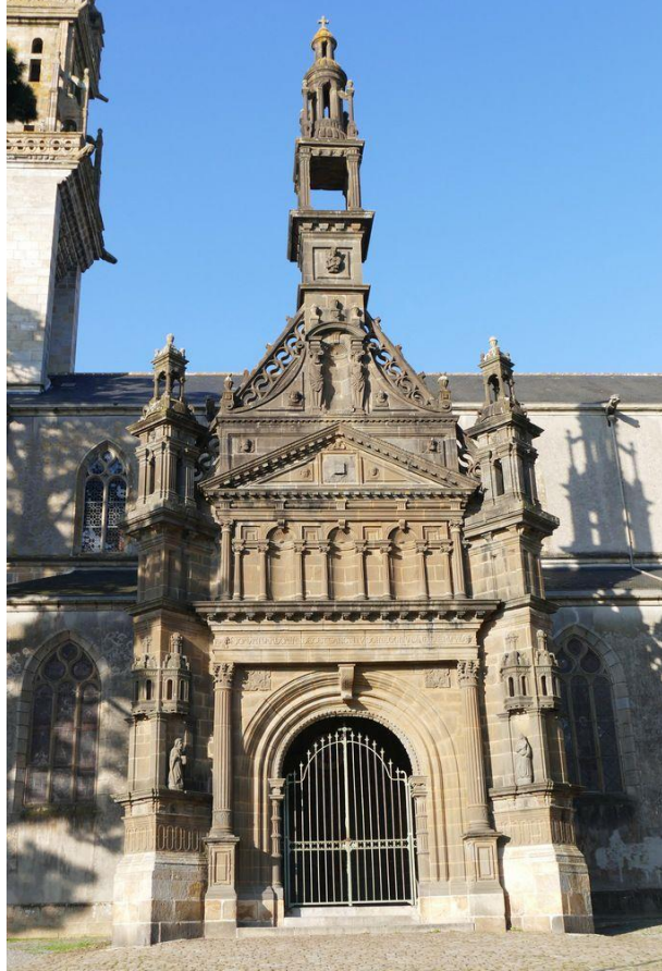
Figure 92 : Porche Sud de l'église Saint-Houardon de Landerneau (Finistère), 1606. Cl. lavieb-aile.
