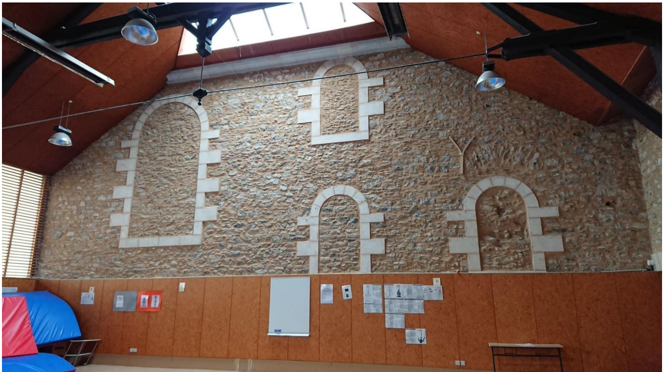
Figure 181 : Anciennes baies située dans le mur gouttereau nord de l'ancienne chapelle du couvent des ursulines. Elles sont aujourd'hui masquées par le gymnase attenant. Cl. Jessy Jouan, 2019.
