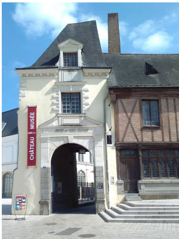
Figure 577 : Portail du porche d'entrée du château de Laval, Mayenne, vers 1631. Source : Wikimedia commons.
