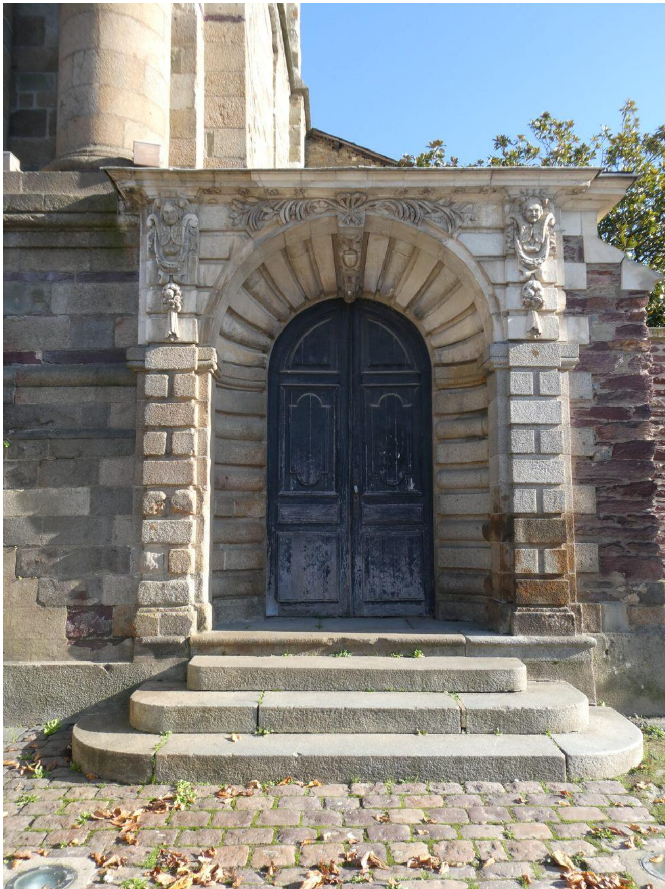
Figure 414 : Porte latérale de la tour clocher conduisant vers le jardin (droite) à décor de bossages alternés, 1672-1675. Cl. Julien Huon, 2020.
