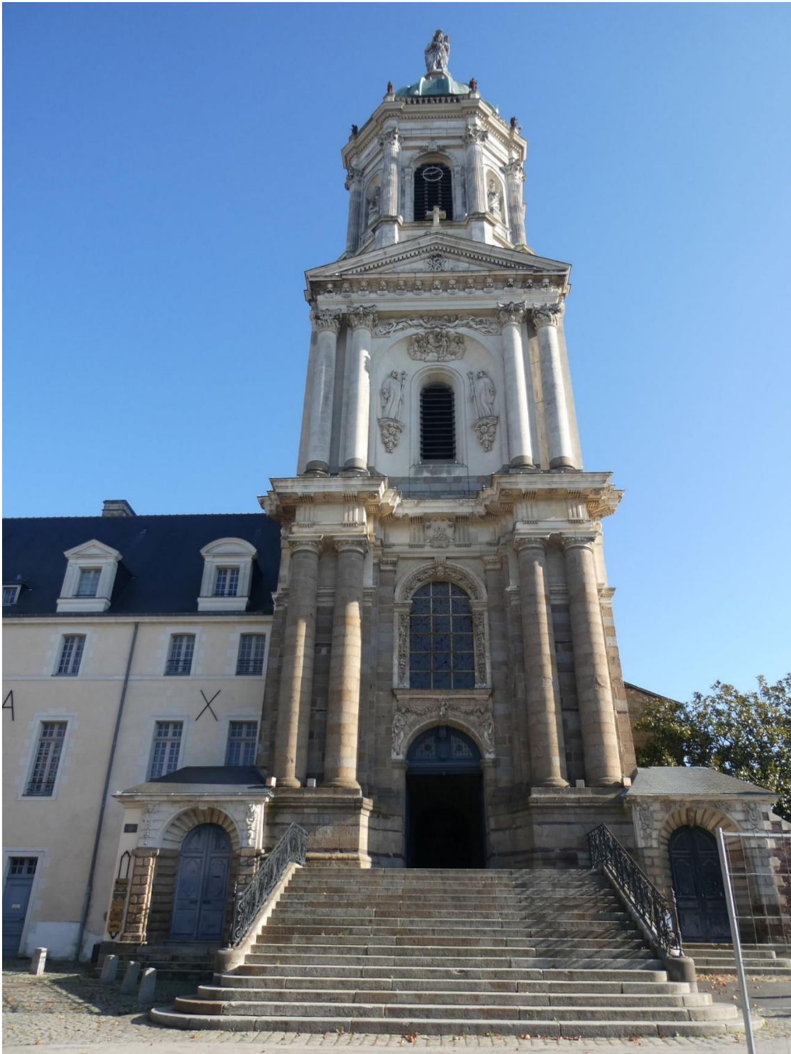
Figure 410 : Élévations de la tour clocher de l'église Notre-Dame-en-Saint-Melaine sur la place Saint-Melaine, 1672-1678. Cl. Julien Huon, 2020.
