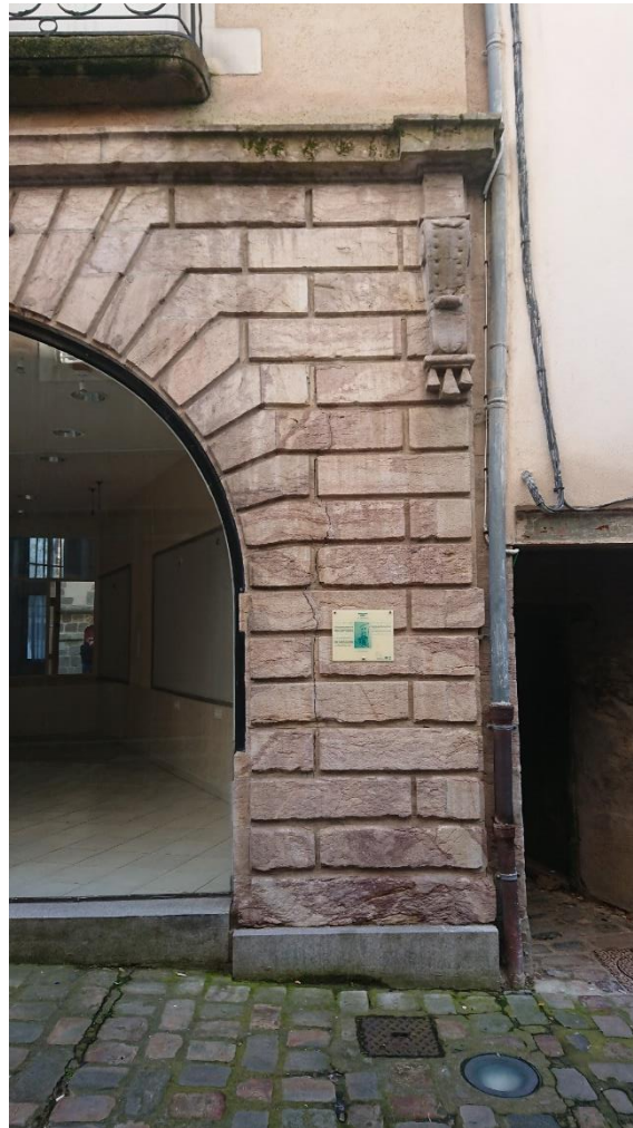
Figure 256 : Détail de l'arcade habillée en bossages plats de marbre rouge, n°9 de la rue des Orfèvres de Laval, 1641. Cl. Jessy Jouan 2018.
