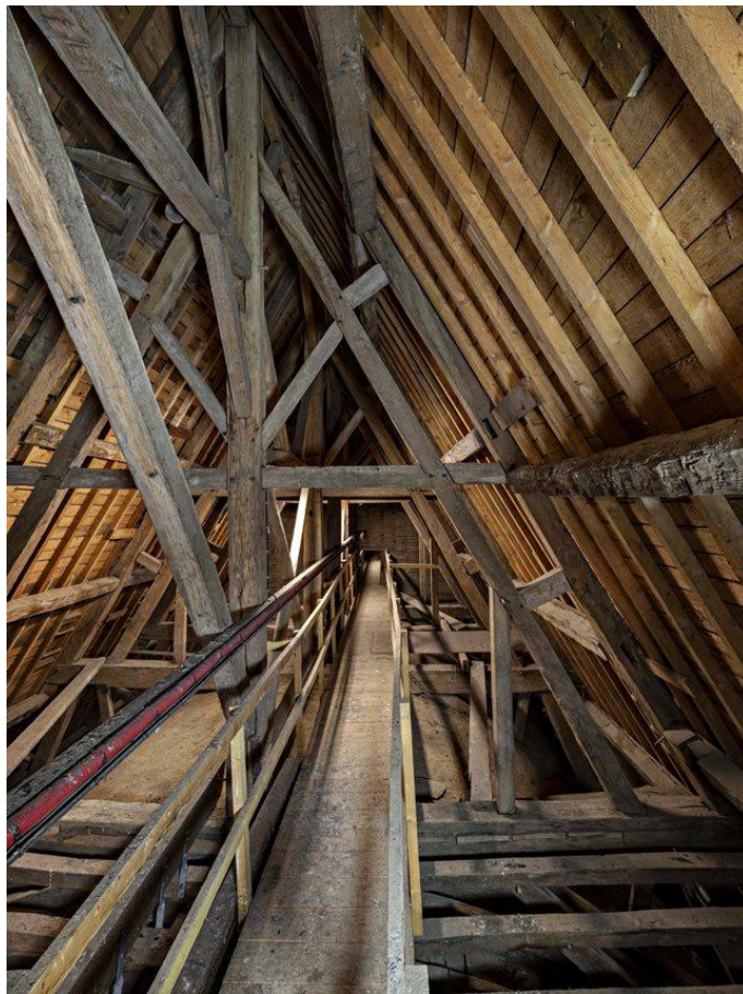
Figure 450 : Charpente à fermes et à pannes de la nef de l'église de la Trinité du couvent des ursulines. Cl. Yves Guillotin, Inventaire du patrimoine Région Pays de la Loire, 2020, IVR52_20205300184NUCA.
