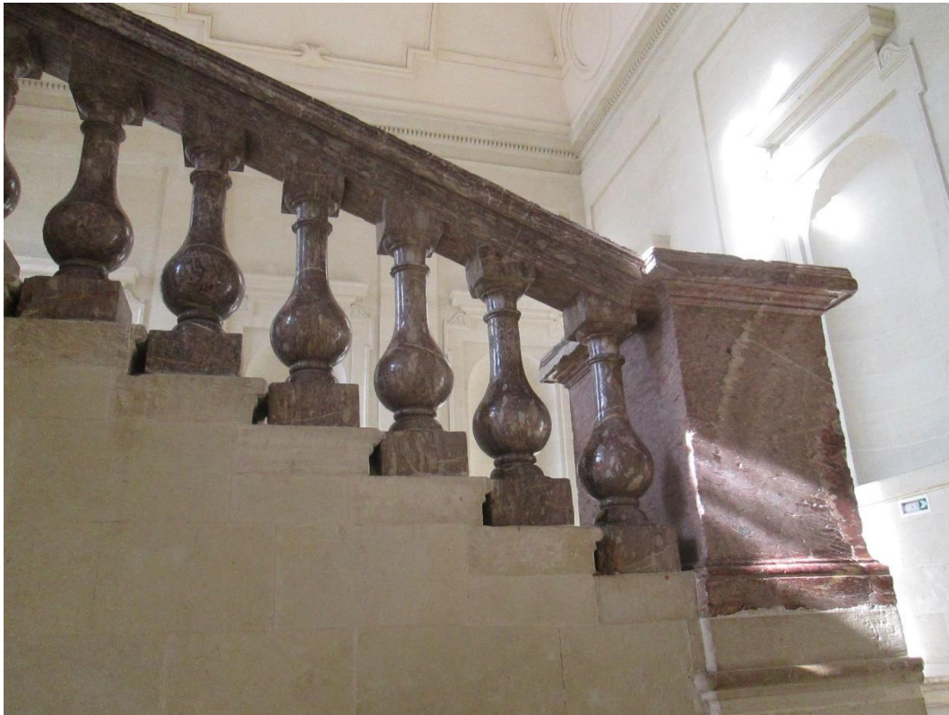
Figure 302 : Pierre Corbineau, Balustres et main courante en marbre rouge de Laval du grand escalier du château de Thouars, 1642-1644, aujourd'hui collège Marie De la Tour d'Auvergne. Source : Internet.
