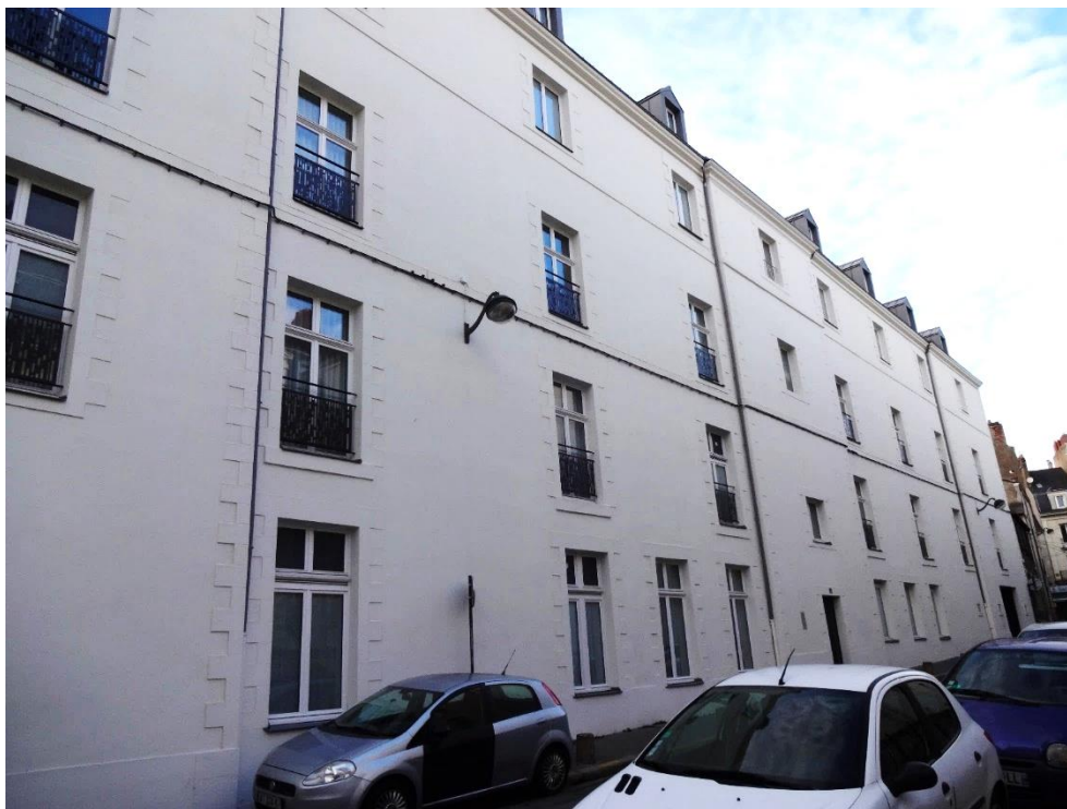
Figure 487 : Élévations actuelles sur la rue Dugast Matifeux du corps de logis nord-est de l'ancien collège St-Clément. Cl. Jessy Jouan 2021.
