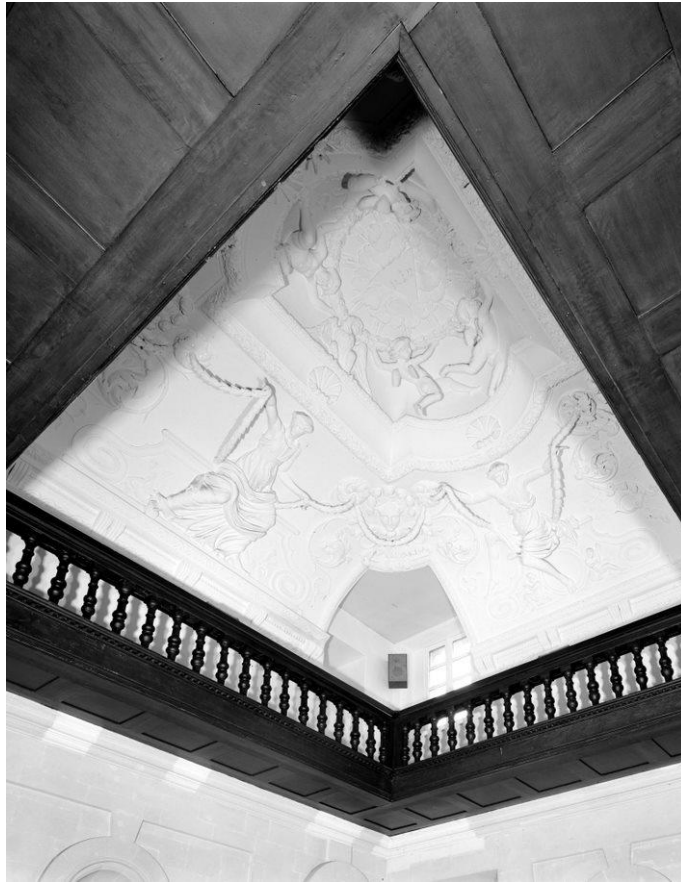
Figure 475 : Coursive en bois et plafond voussuré à décors d'allégories en plâtre du grand escalier suspendu à jour central de l'hôtel Rosmadec. Cl. Denis Pillet, Inventaire du patrimoine Région Pays de la Loire, 1992, IVR52_19924400378V.
