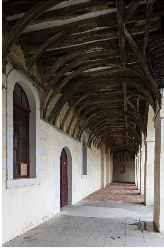
Figure 278 : Galerie voûtée de bois sur le cloître. Aile sud-ouest du couvent. Cl. Yves Guillotin, Inventaire du Patrimoine Région Pays de la Loire, 2020, IVR52_20205300064NUCA.
