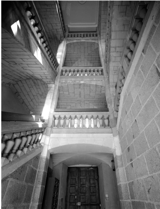
Figure 495 : Grand escalier de l'aile nord-est de l'ancien collège St-Clément, actuellement immeuble d'habitations. Cl. Denis Pillet, Inventaire du patrimoine Région Pays de la Loire, 1992, IVR52_19924400417V.
