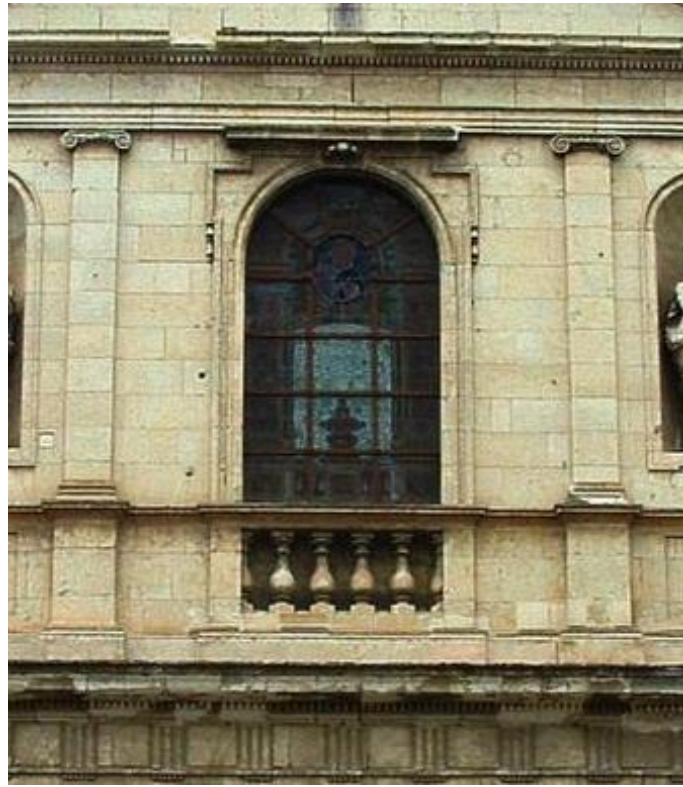
Figure 553 : Jacques Lemercier, Baie axiale de la façade de l'église Notre-Dame, Richelieu, Indre-et-Loire, 1633-1638. Source : Structurae.
