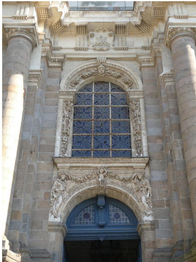
Figure 411 : Vue rapprochée de la travée centrale du premier registre. Cl. Julien Huon, 2020.
