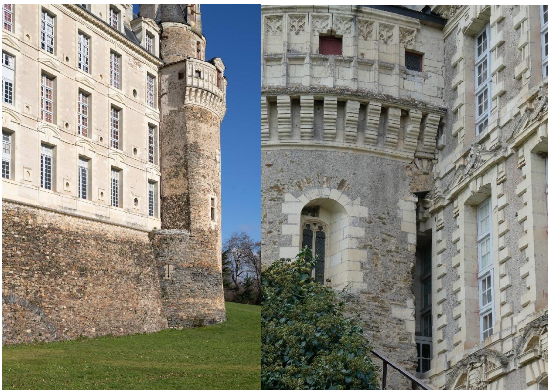
Figure 11 : Détail de la jonction entre la tour médiévale sud (1506) et l'angle du sud-est du grand corps de logis de méridional du château de Brissac. À gauche Cl. Armelle Maugin, Département du Maine-et-Loire, Inventaire du Patrimoine des Pays de la Loire, 2021, IVR52_20214900102NUCA. À droite, Cl. Jessy Jouan, 2019.
