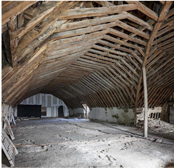
Figure 290 : Grand comble de l'aile sud-ouest à charpente à chevrons formant fermes (1642-1646). Cl. Yves Guillotin, Inventaire du Patrimoine Région Pays de la Loire, 2020, IVR52_20205300176NUCA.
