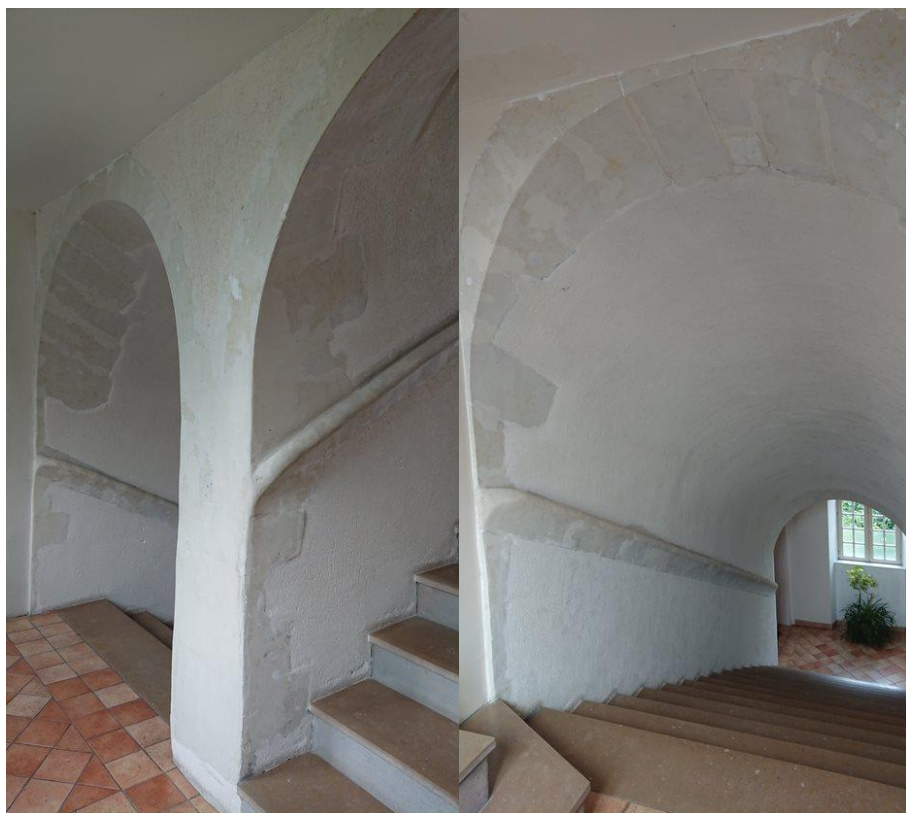
Figure 193 : Volées voutées en berceau du grand escalier de l'aile orientale de l'ancien couvent des patiences de Laval, premier quart XVI e siècle. Cl. Jessy Jouan, 2020.
