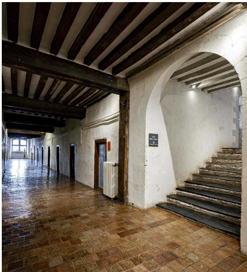
Figure 288 : Vue du grand escalier et du couloir des cellules depuis le palier du premier niveau (aile sud-ouest). Cl. Yves Guillotin, Inventaire du Patrimoine Région Pays de la Loire, 2020, IVR52_20205300081NUCA.
