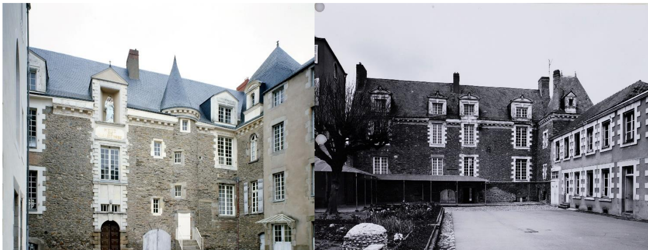
Figure 569 : Auteur inconnu, « Grande maison » ayant supposément appartenue à Pierre Corbineau, 27 rue du Paradis, Laval, reconstruite autour de 1619. Cl. Inventaire du Patrimoine des Pays de la Loire, IVR52_19885300582XA et IVR52_19825300168V, 1988 et 1982.
