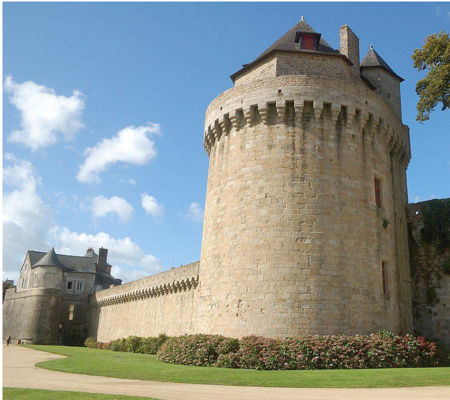
Figure 111 : Tour du connétable et muraille vers le bastion dit, éperon de la garenne, des remparts de Vannes. Source : Wikimedia Commons.
