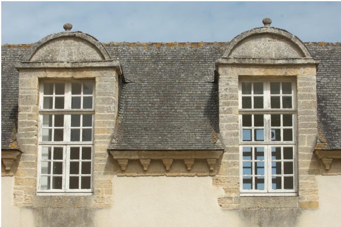
Figure 139 : Lucarnes de l'aile nord du château de Beaumanoir à Evran (Côtes-d'Armor), Cl. Norbert Lambert, Inventaire du Patrimoine de la Région Bretagne, 2011, IVR53_20112200721NUCA.
