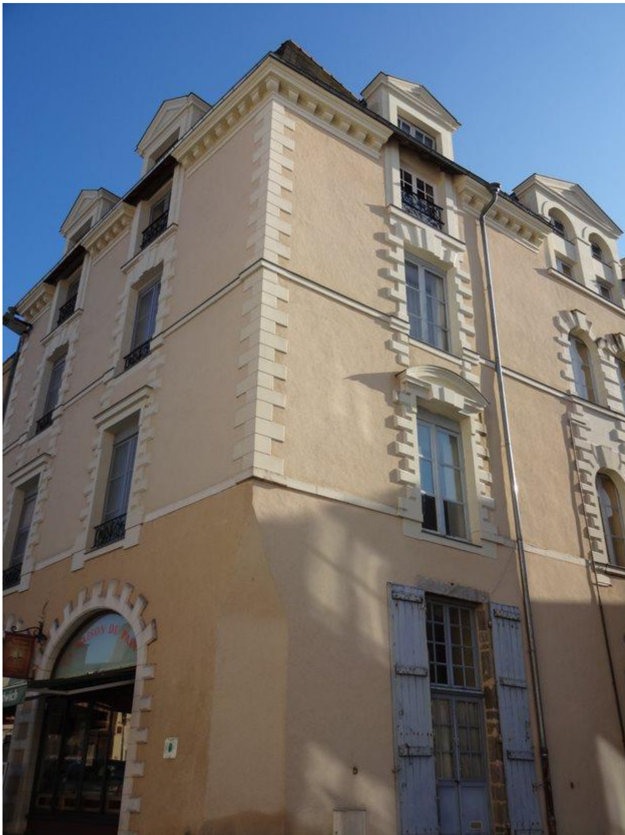
Figure 198 : Élévations sur la place de la Trémoille et du Piliers Vert de la maison de la Bazoche. Cl. Jessy Jouan, 2020.
