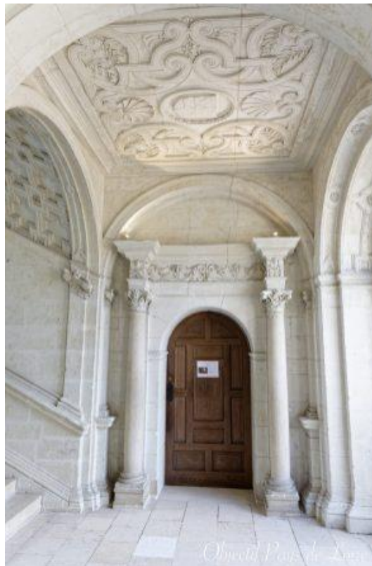
Figure 564 : Jean Delespine, Palier du grand escalier du château de Serrant avec ses voûtes plates, Saint-Georges-sur-Loire, Maine-et-Loire, 1560-1575. Source : Internet.
