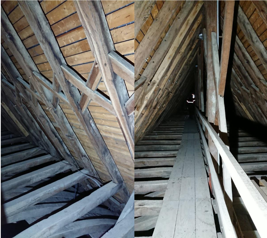
Figure 184 : Charpente à chevrons formant fermes de la chapelle des ursulines de Laval, avant 1626. Cl. Jessy Jouan, 2019.
