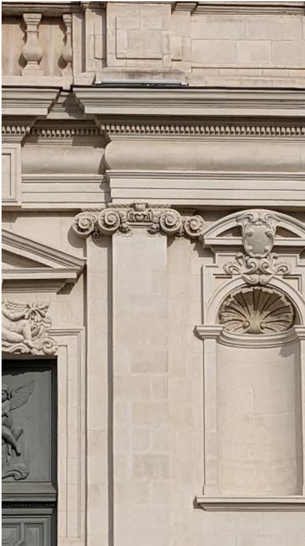
Figure 457 : Détail de l'ordre ionique du registre inférieur de la façade de la chapelle de l'oratoire de Nantes. Cl. Jessy Jouan 2022.
