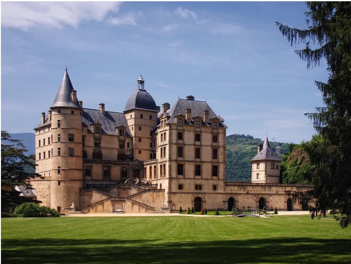
Figure 56 : Pierre La Cuisse (architecte), Château de Vizille, reconstruit pour François de Bonne à partir de 1602, Isère. La terrasse portait initialement un long corps de logis contenant une galerie, aujourd'hui détruit. Source : Internet
