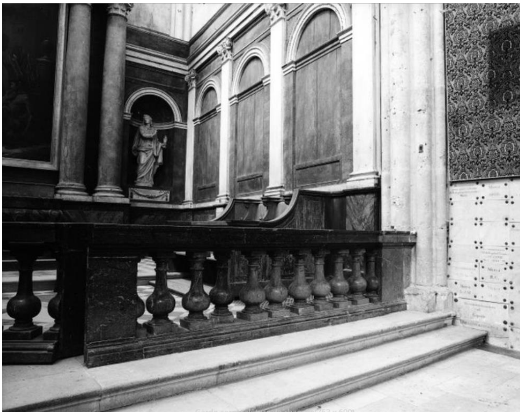
Figure 303 : Balustrade en marbre rouge de Laval exécutée pour le grand escalier du château de Richelieu, aujourd'hui remontée dans le croisillon nord de la cathédrale Saint-Gatien de Tours. Cl. Robert Malnoury, Inventaire du Patrimoine Région Centre-Val-de-Loire, 1988, IVR24_19883700602X.
