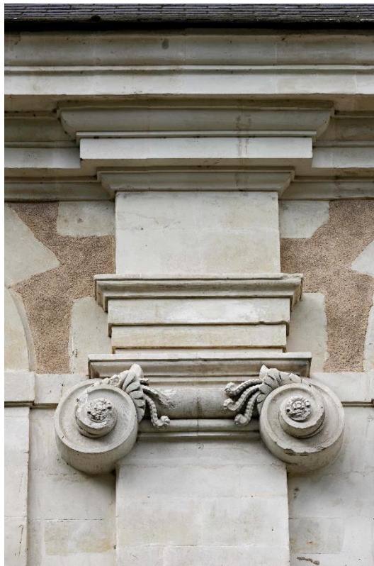
Figure 281 : Détail d'un chapiteau ionique complété de son entablement. Cl. Yves Guillotin, Inventaire du Patrimoine Région Pays de la Loire, 2020, IVR52_20205300145NUCA.
