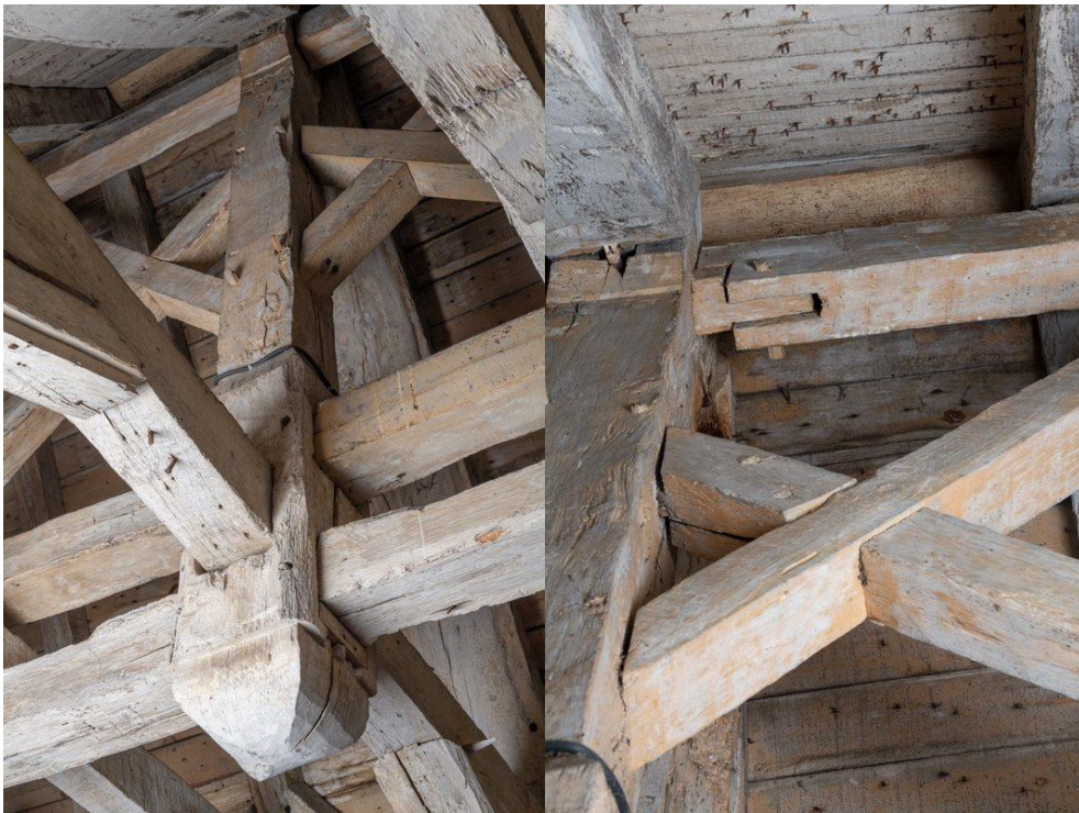
Figure 20 : Détail d'un poinçon retroussé et du système d'assemblage des poutres faîtières de la charpente de l'aile de la galerie du château de Brissac. Cl. Armelle Maugin, Département du Maine-et-Loire, Inventaire du Patrimoine des Pays de la Loire, 2021, IVR52_20214900045NUCA & IVR52_20214900051NUCA.
