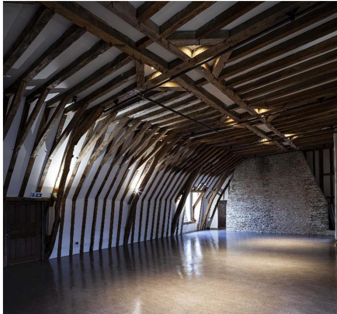
Figure 445 : Comble de l'aile nord-ouest à charpente à chevrons formant fermes. Cl. Yves Guillotin, Inventaire du patrimoine Région Pays de la Loire, 2020, IVR52_20205300110NUCA.
