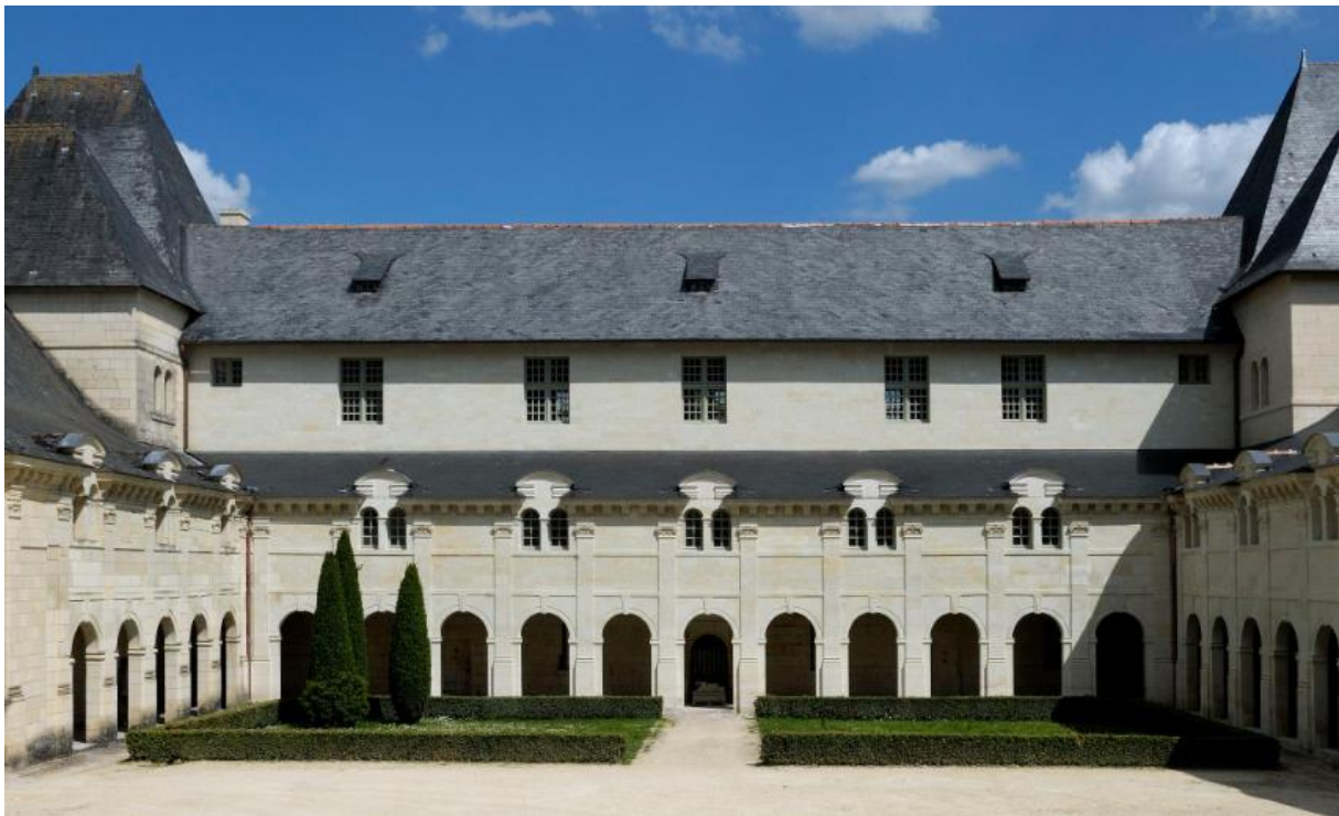
Figure 544 : Cloître Saint Benoît de l'abbaye de Fontevraud, Maine-et-Loire, vers 1580. Cl. Bruno Rousseau, Département du Maine-et-Loire, inventaire du patrimoine Région Pays de la Loire, 2013.
