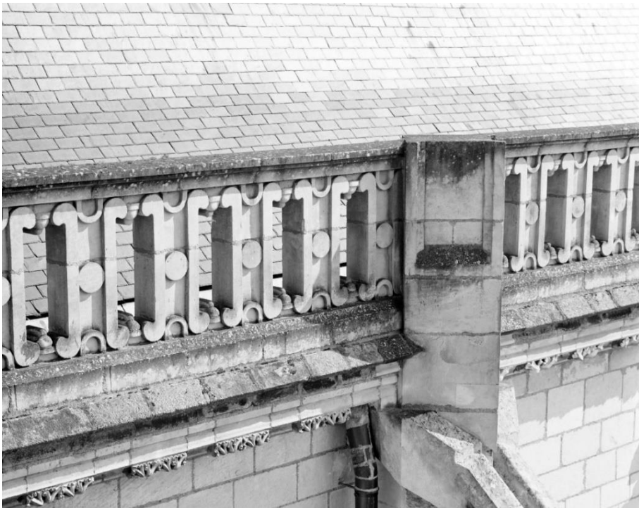
Figure 118 : Sommet du mur gouttereau sud de la nef de la cathédrale Saint-Pierre de Nantes avec sa balustrade mise en œuvre entre 1626 et 1631. Cl. Patrice Giraud et Denis Pillet, Inventaire du Patrimoine des Pays de la Loire, IVR52_19914401584XA.
