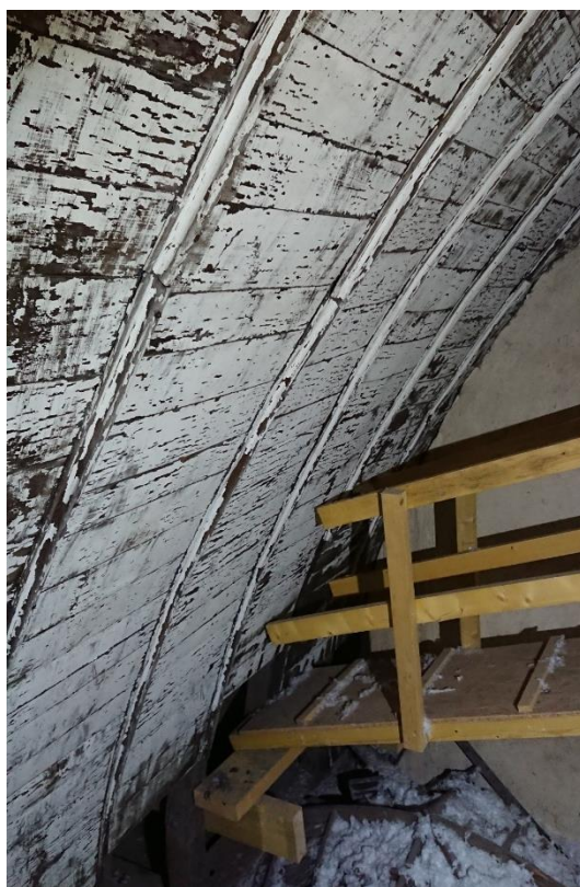
Figure 550 : Ancien lambris, toujours en place au-dessus du voutement d'ogives du XIX e siècle, de l'ancienne chapelle des ursulines de Laval, avant 1626 ? Cl. Jessy Jouan, 2019.
