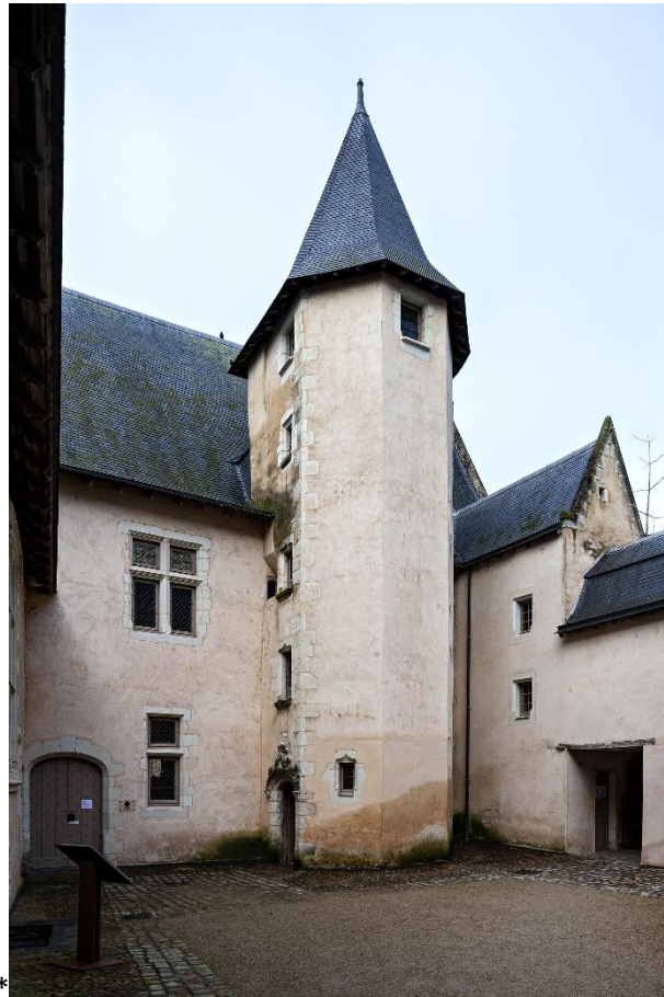
Figure 269 : Manoir dit de la Touche et sa tour d'escalier (fin XV e siècle) depuis la cour du tour. Ancien couvent des ursulines de Château-Gontier. Cl. Yves Guillotin, Inventaire du Patrimoine Région Pays de la Loire, 2020, IVR52_20205300127NUCA.
