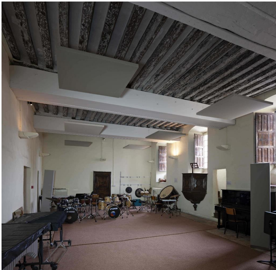
Figure 283 : Vue intérieure de l'ancien réfectoire de l'aile sud-ouest aujourd'hui salle des percussions. Cl. Yves Guillotin, Inventaire du Patrimoine Région Pays de la Loire, 2020, IVR52_20205300174NUCA
