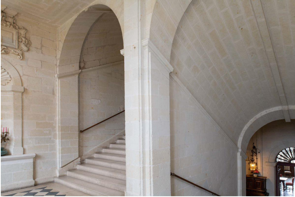
Figure 37 : Volées et repos du grand escalier du château de Brissac situé entre les niveaux R+1 et R+2. Cl. Armelle Maugin, Département du Maine-et-Loire, Inventaire du Patrimoine des Pays de la Loire, 2021, IVR52_20214900171NUCA.
