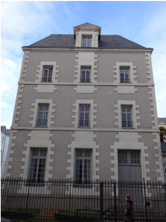
Figure 505 : Élévations sur la rue Gambetta du corps de logis sud-ouest de l'ancien couvent de la visitation. Cl. Jessy Jouan, 2019.
