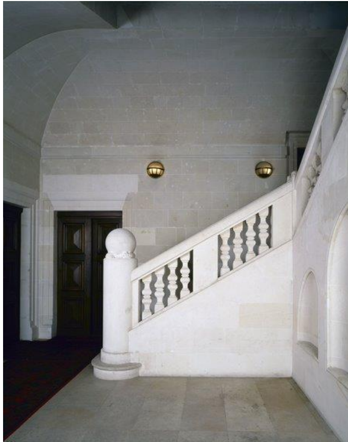
Figure 473 : Départ du grand escalier suspendu à jour central de l'hôtel Rosmadec. Cl. Denis Pillet, Inventaire du patrimoine Région Pays de la Loire, 1990, IVR52_19904400867VA.
