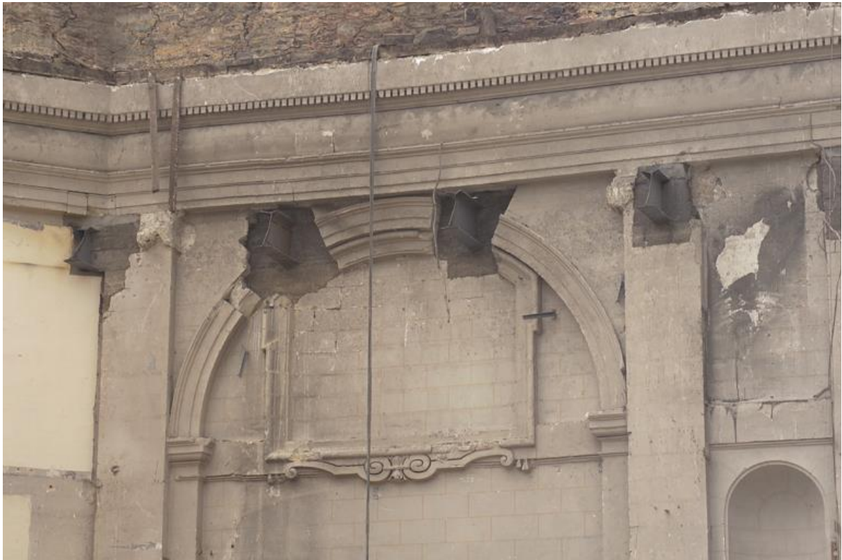
Figure 326 : Détail de la sculpture intérieure. Chantier de démolition du collège de l'Immaculée, rue de la Visitation et la chapelle en ruine. Cl. Gérard Prudor, Musée de Bretagne, Rennes, 2004.
