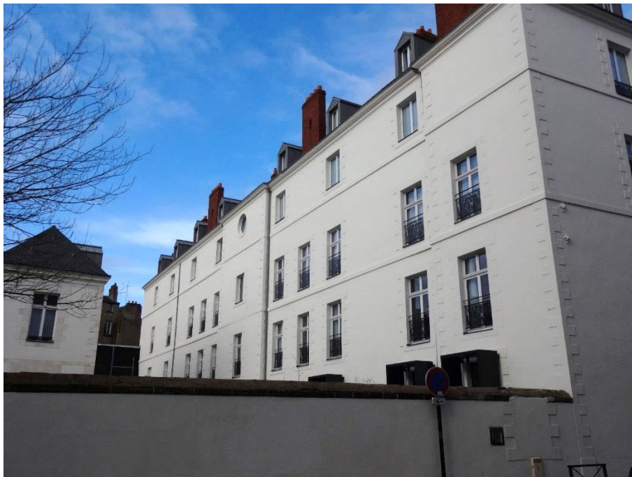
Figure 486 : Élévations actuelles sur cour du corps de logis nord-est de l'ancien collège St-Clément. Cl. Jessy Jouan 2021.
