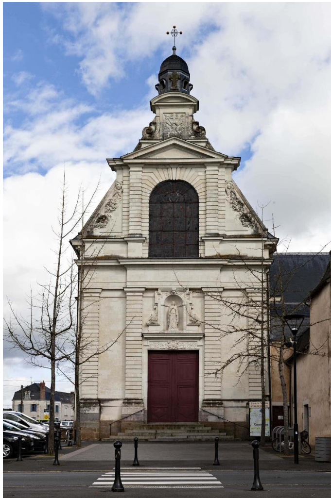
Figure 291 : Pierre et Gilles Corbineau, Façade de la chapelle de l'ancien couvent des ursulines de Château-Gontier (1658-1664). Cl. Yves Guillotin, Inventaire du Patrimoine Région Pays de la Loire, 2020, IVR52_20205300166NUCA.
