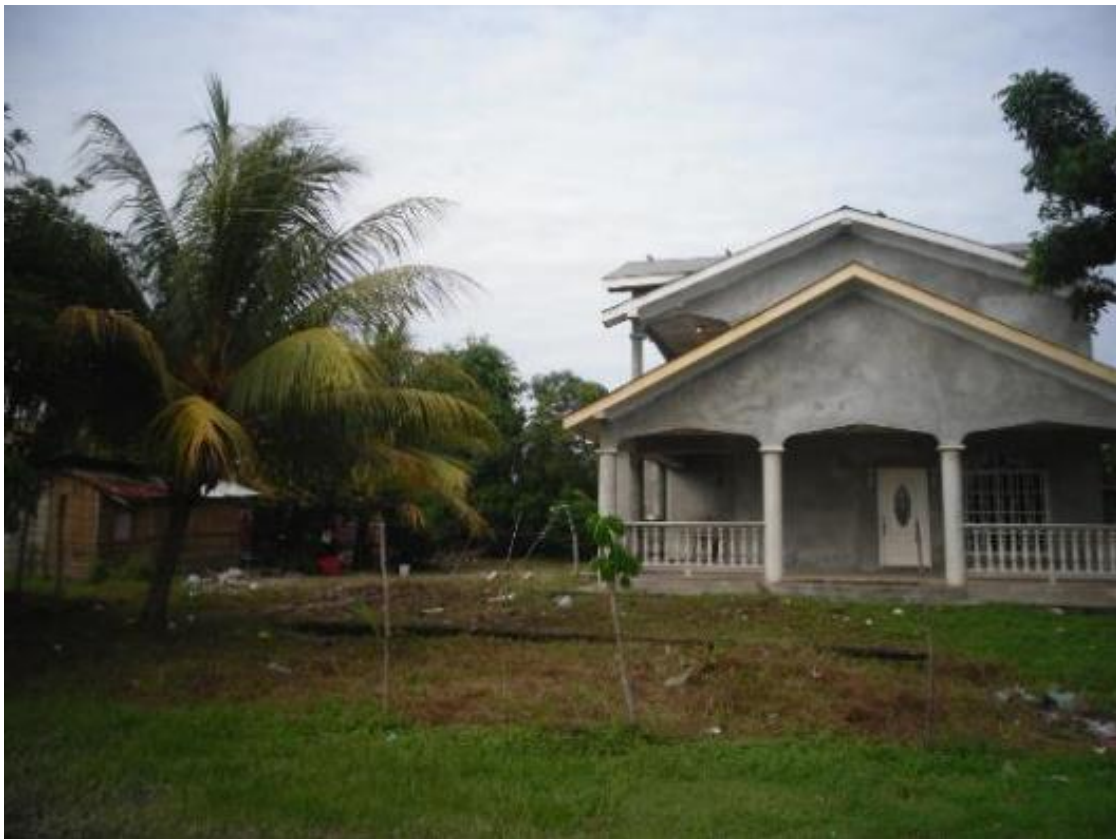
3. Construction en « dur » (parpaings et ciment) à Tocamacho et à Tornabé (photos O. C.).
