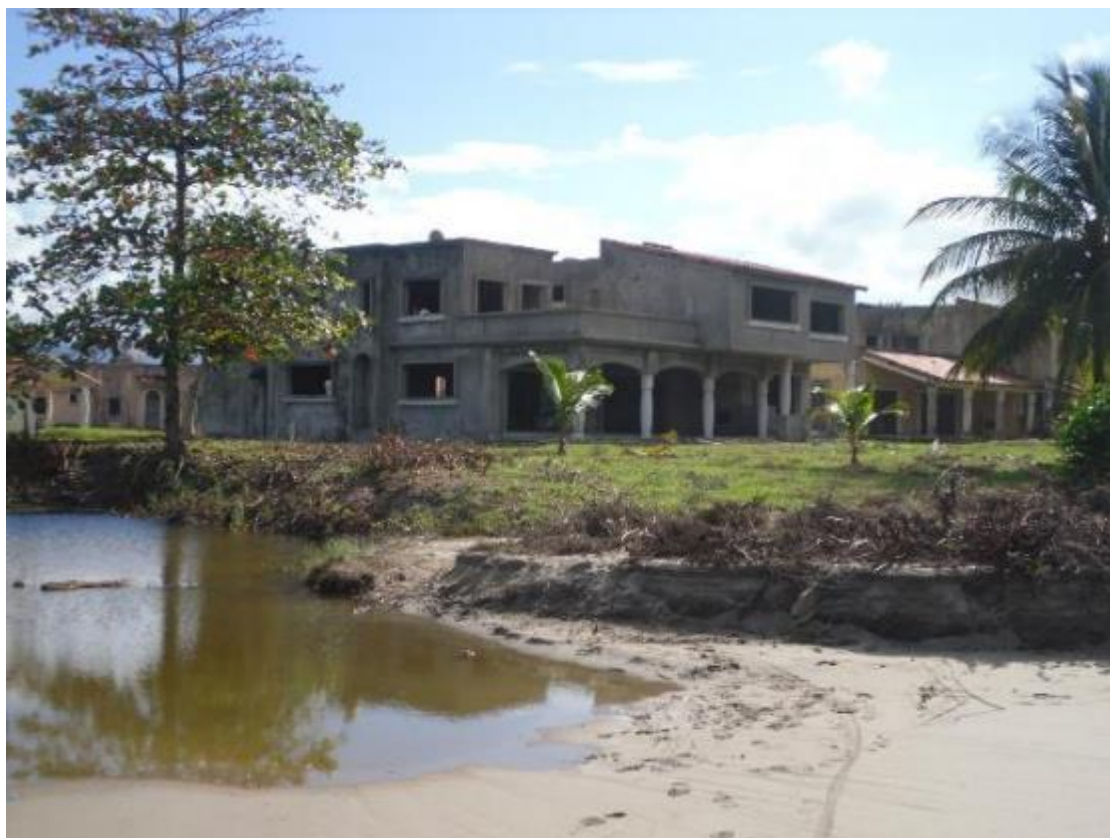
1. Le projet de construction Marbella en 2012 (photo O. C.).
