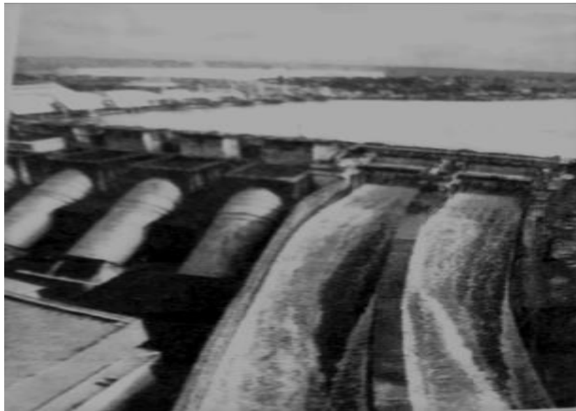
Figure 53: Image d'un barrage hydro électrique pour évoquer l'importance de l'eau proposé par l'enseignante A
