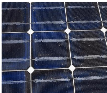
Figure 39 : Délamination de modules exposés en Floride [138]. Elle intervient ici au niveau des rubans d'interconnexion et des bords de cellule et se distingue par des tâches laiteuses dues à la présence d'air entre l'encapsulant et la cellule.
