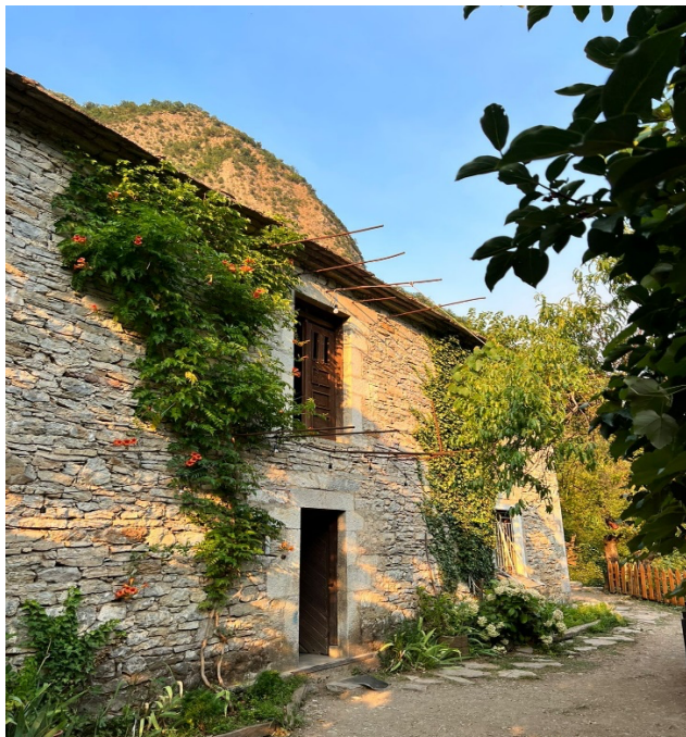
Photo 28 : Rénovation du bâti traditionnel à Dukagjini (Shkodra)
