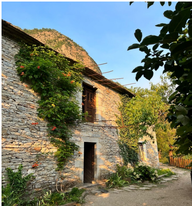
Photo 28 : Rénovation du bâti traditionnel à Dukagjini (Shkodra)
