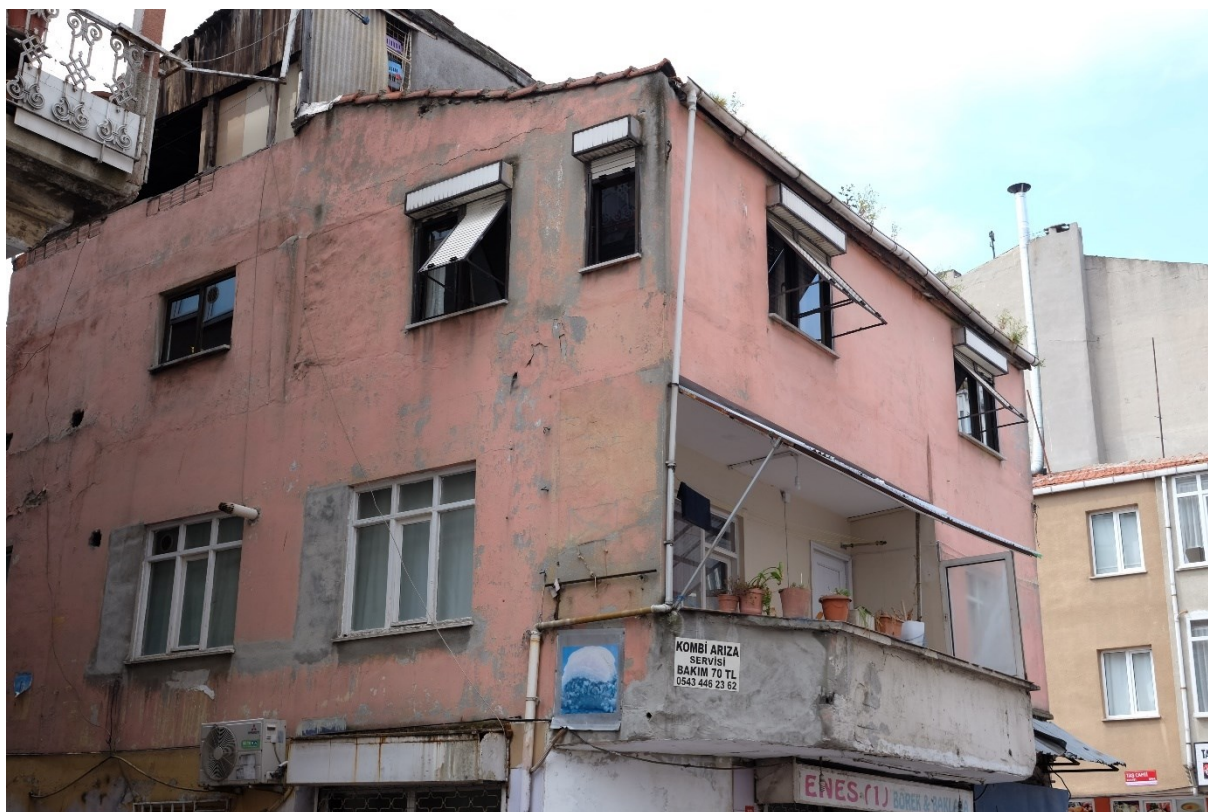
Photographie 17 : Multiplécité des porte-à-faux sur un apartkondu dans l'arrondissement de Zeytinburnu (Gourain, 2021)
