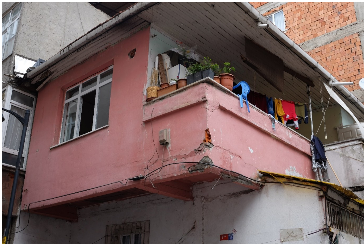
Photographie 10 : Un bâtiment dans l'arrondissement de Zeytinburnu (Gourain, 2021)
