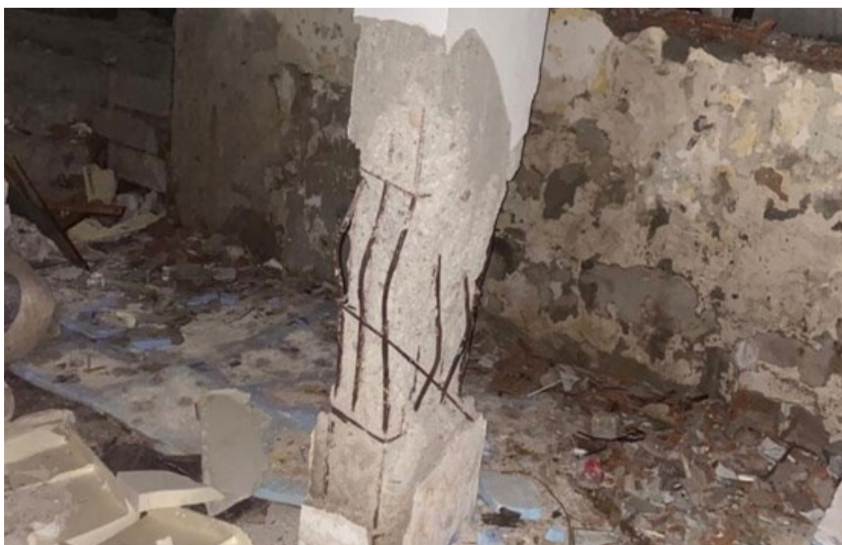
Photographie 13 : Poteau d'un des bâtiments effondrés à Bahçelievler (emlakkulisi, 2020)
