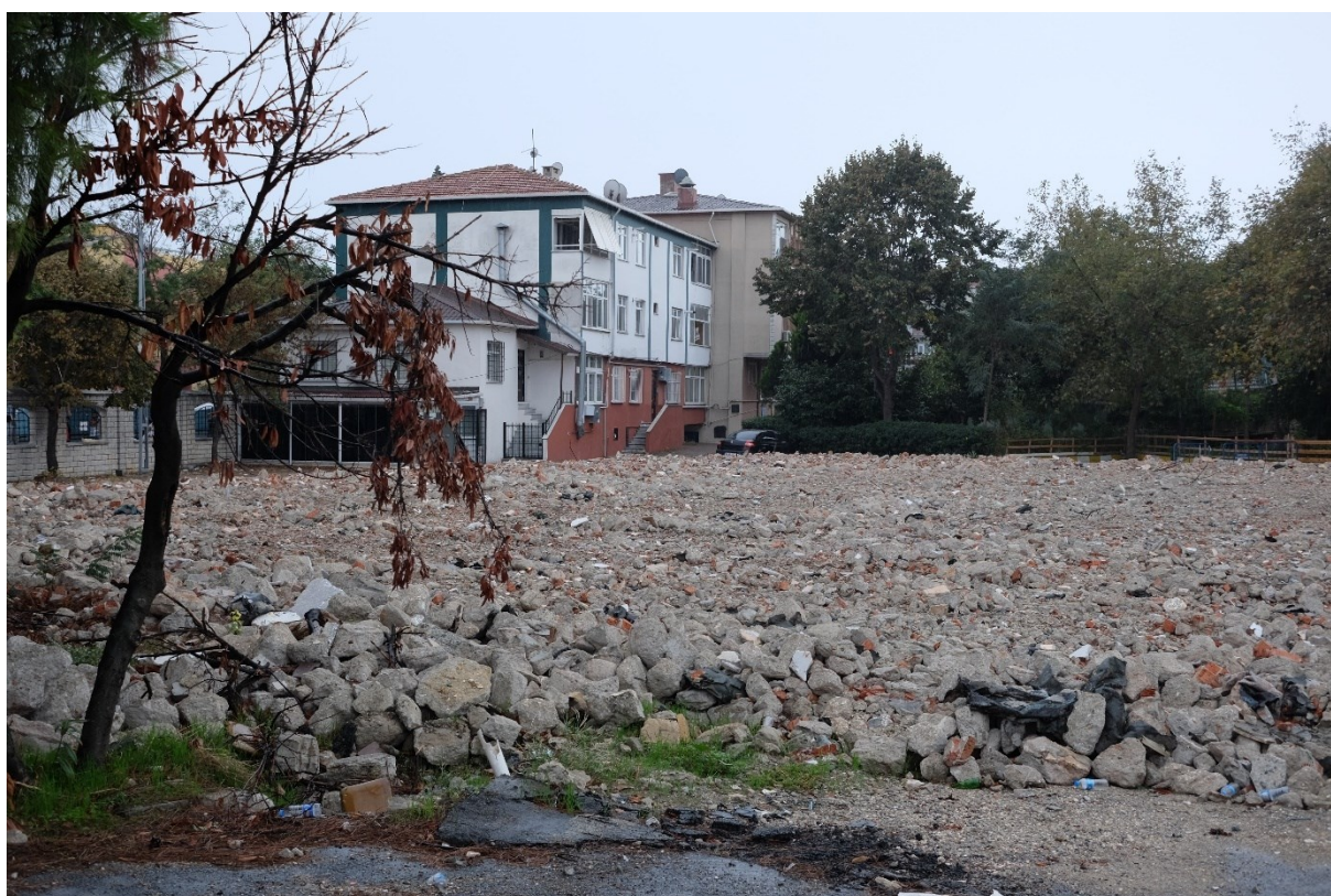
Photographie 8 : Emplacement de la mosquée Hacı Ahmet Tükenmez à Avçılar immédiatement démolie après l'effondrement du minaret lors du séisme du 26 septembre 2020 (Gourain, 2020)
