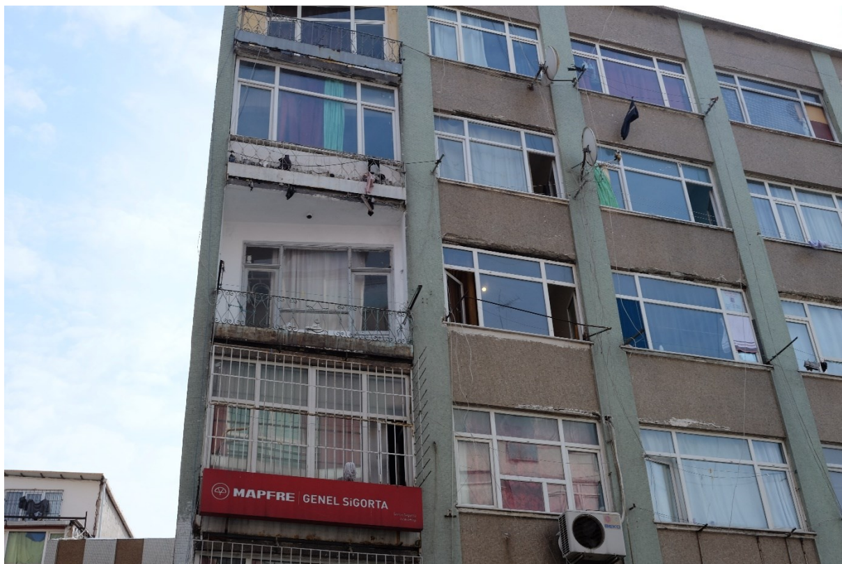
Photographie 11 : Bâtiment dans le quartier de Kumkapı dans l'arrondissement de Fatih (Gourain, 2020)
