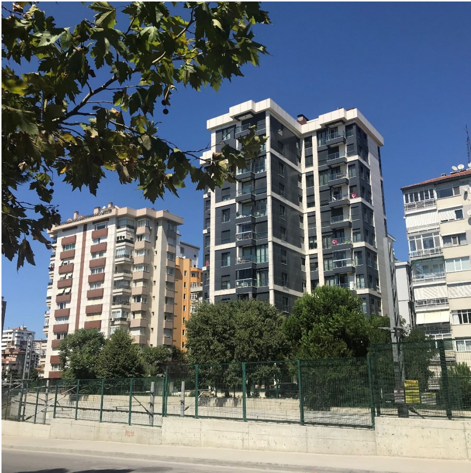
Photographie 15 : Logements du quartier de Bostancı (Gourain, 2020)
