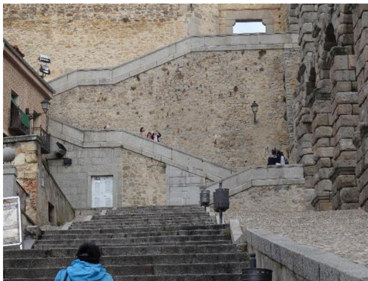
FIG. 16 : Ségovie, Escalier d'accès aux premières arches de l'aqueduc, depuis la Plaza del Azoguejo (photographie prise le 15 septembre 2016).
