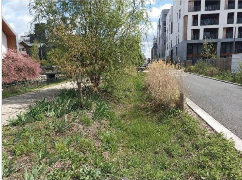
Fossé végétalisé (Bordeaux)
