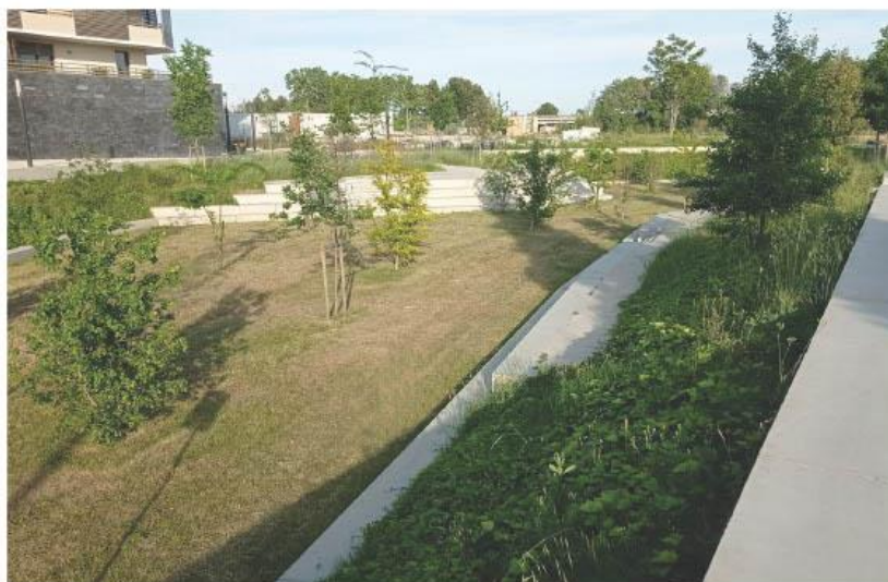
Bassin végétalisé (Montpellier)
