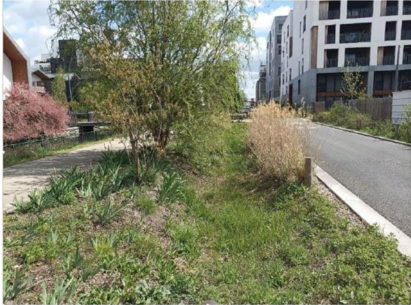
Fossé végétalisé (Bordeaux)
