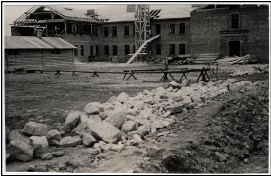
Source : Archives audiovisuelles du CICR, en ligne, V-P-HIST-03183-21A, « Guerre 1939-1945. Rawa-Ruska / Lemberg, Stalag 325. La seule fontaine du camps devant des casernes en construction », août 1942.
