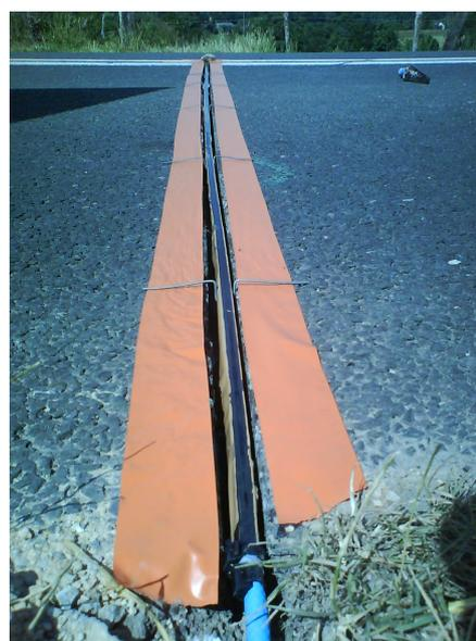
FIGURE 9.2 – Exemple d'installation d'un capteur résistif dans la chaussée.
