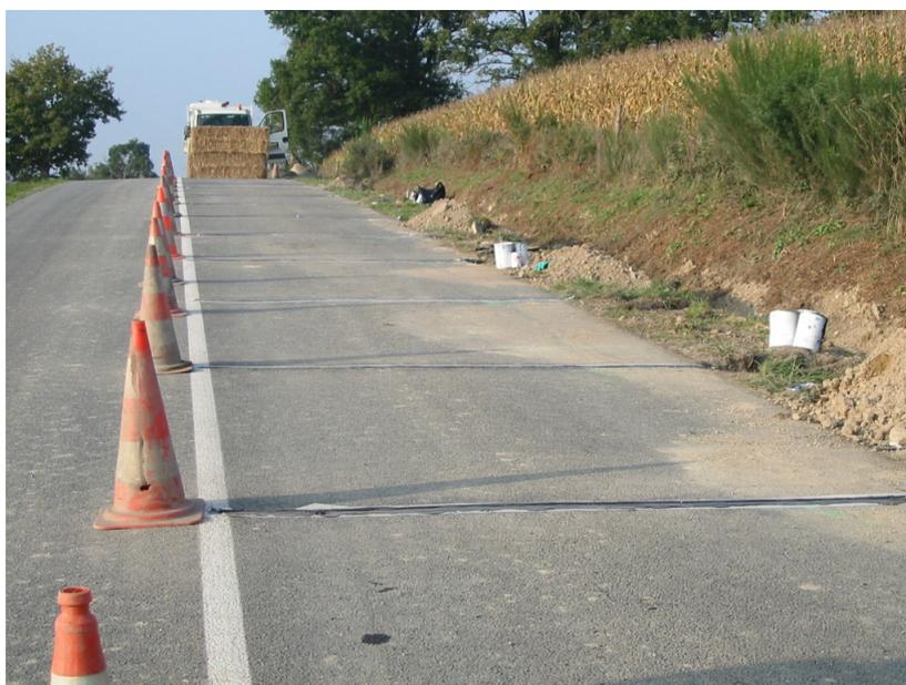
FIGURE E.5 – Visualisation de la position des capteurs dans la chaussée dans le sens Marans vers Segré avant le sommet de côte. La résine a été coulée.
