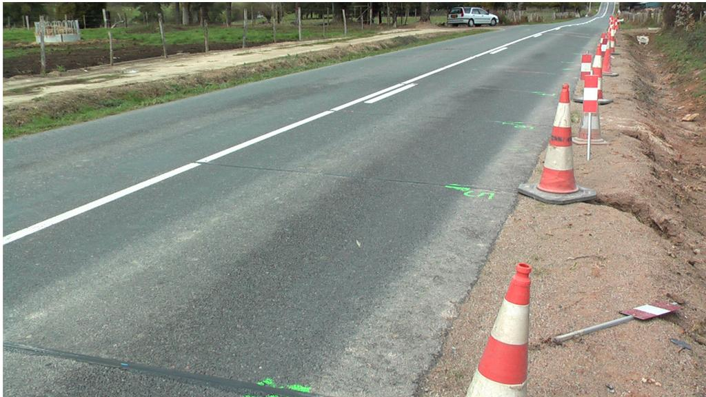
FIGURE E.6 – Visualisation d'une partie des capteurs résistifs et du remblayage sur l'accotement.
