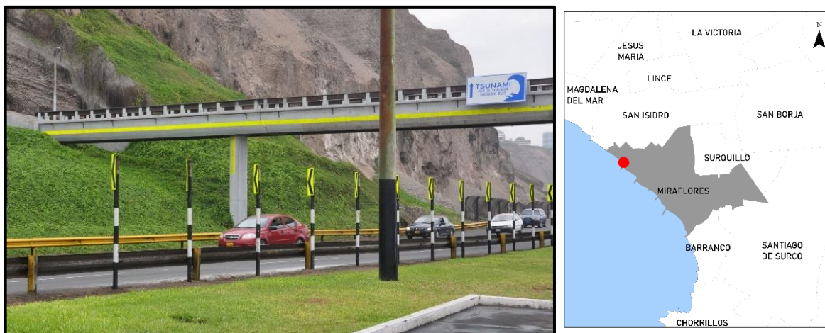
Photographie 14 : Le pont piétonnier, une issue de secours face au tsunami, Miraflores. @Andina, 2012.
