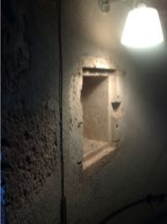
Niche dans l'escalier principal
