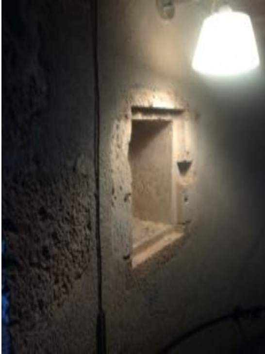
Niche dans l'escalier principal
