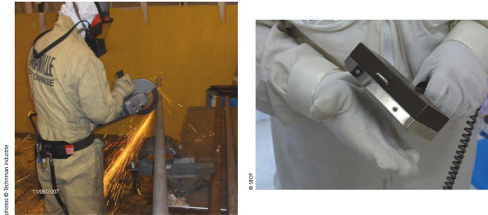
FIGURE 2.30: Exemple de situation sur chantier en zone contrôlée et de contrôle réalisé à chaque sortie de chantier.
