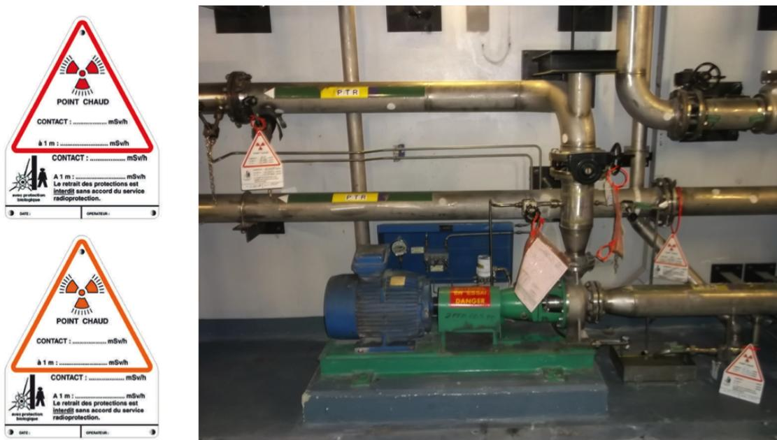
FIGURE 1.14: Exemple de signalisation de points chauds (à droite). Types de signalisation utilisés pour le marquage des points chauds orange et rouge (à gauche).
