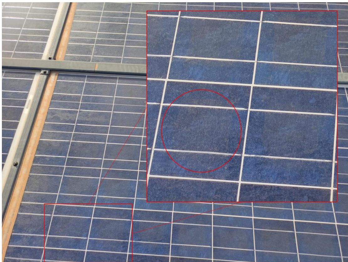
Figure 3.23: Symptômes de la délamination sur les modules
