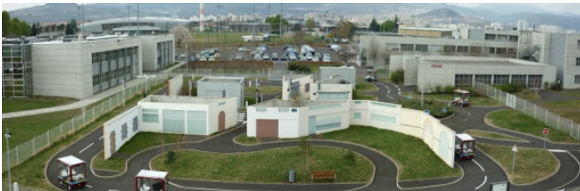
FIGURE 1.1 – Plateforme PAVIN « Véhicule Urbains » [48].
