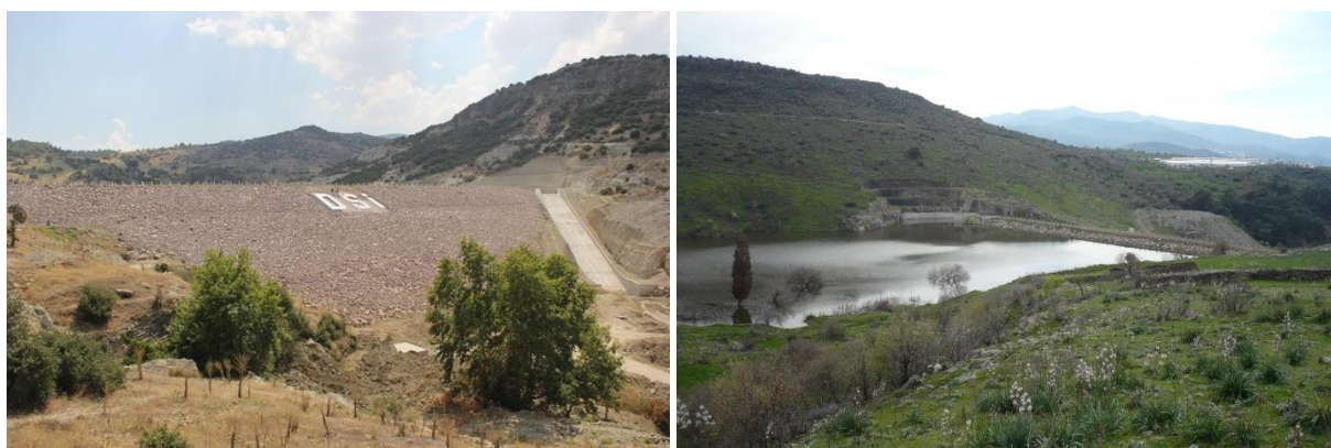
Gölet de Süleymanlı, Menemen (DSI, 2014 à gauche ; terrain, 2016 à droite) : barrage de remblai homogène ; hauteur : 36 mètres ; volume d'eau : 1,18 million m 3 ; superficie irriguée : 153 ha.
