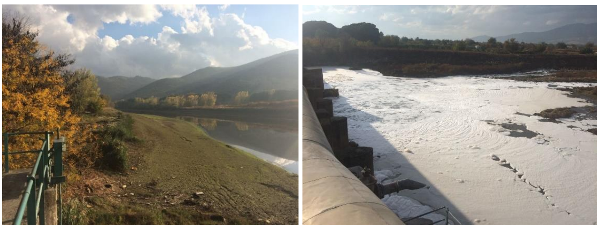
Figure 58. Pollution visible sur le Gediz au niveau du régulateur d'Emiralem (2017)
