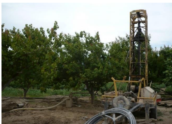
Réalisation d'un forage (Emiralem, 2015)
