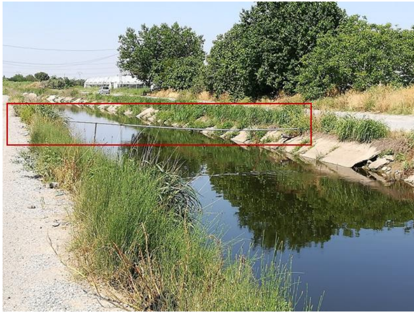
Figure 70. Raccord effectué avec le gölet, passage du tuyau au-dessus du canal (2017)
