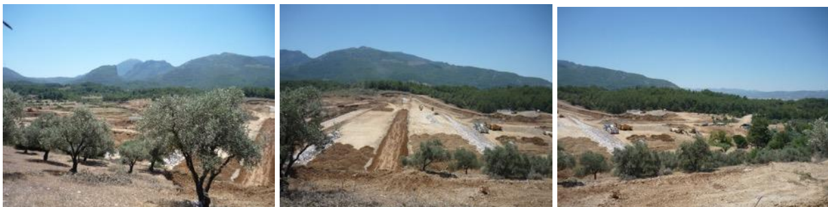
Figure 81. Photos du chantier de la retenue collinaire à Yukarıkızılcıca (juillet 2017)
