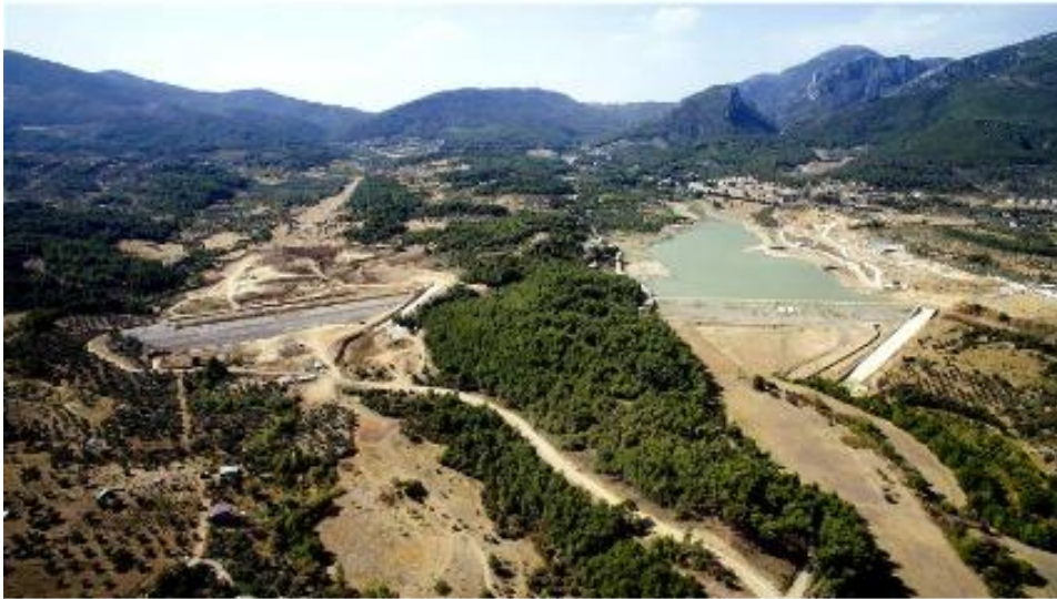
Figure 80. Gölet de Savanda (Nazarköy) et retenue en construction à Yukarıkızılca
