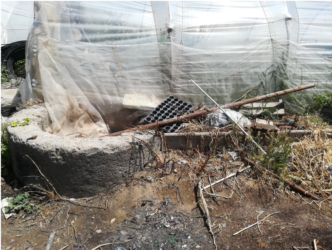
Figure 59. Marques de l'intégration d'Emiralem à la grande hydraulique (2018)
