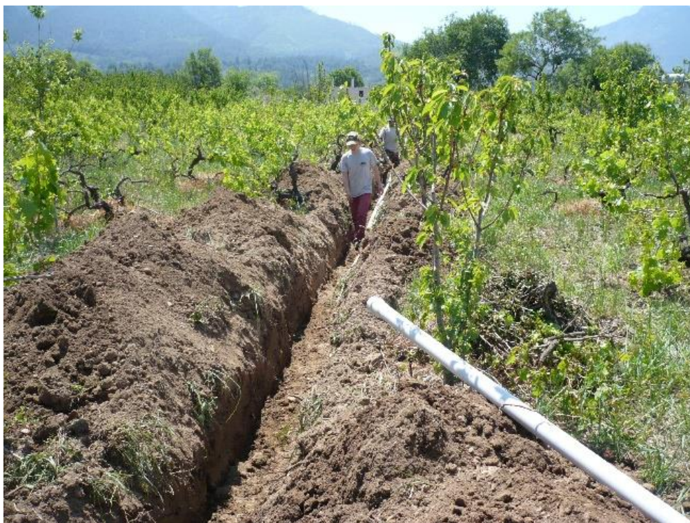
Figure 47. Photo d'installation d'un nouveau système de goutte-à-goutte enterré pour les jeunes cerisiers plantés dans une vigne à Armutlu (2015)
