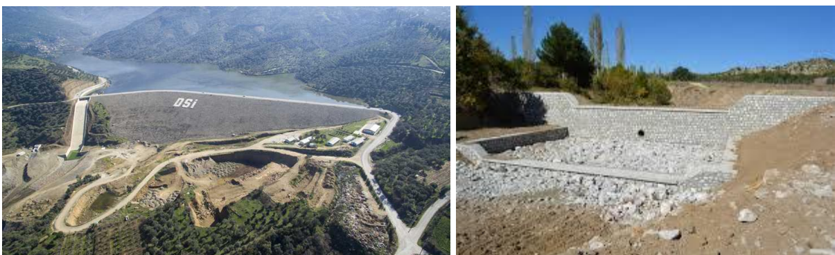
Gölet de Bademli, Ödemiş (DSI, 2016) : barrage de remblai mixte (gravier/sable) à noyau d'argile ; hauteur : 57 mètres ; volume d'eau : 4,95 millions m 3 ; sup. irriguée : 1048 ha.
