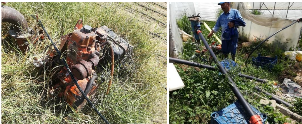
À gauche : moteur diesel Süperstar (2018) ; à droite : unité de filtration ( hydrocyclone ) à la sortie d'un forage privé avant d'irriguer les serres (toiles blanches visibles à l'arrière-plan) en goutte-à-goutte (2018)
