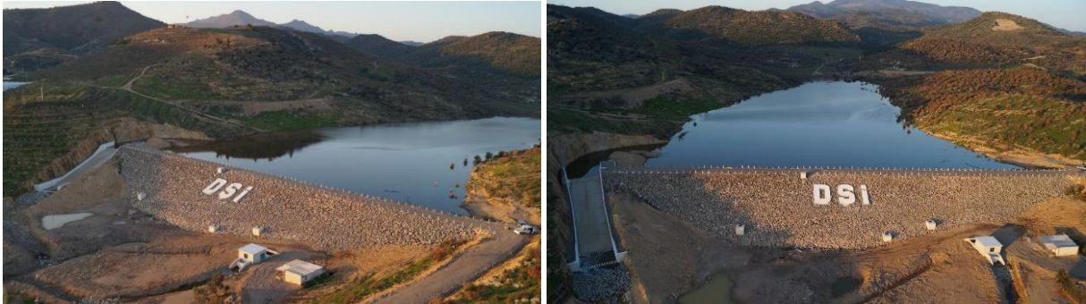
Gölet Harputlu à Kocaoba, Dikili (DSI, 2016) : barrage de remblai mixte (gravier/sable) à noyau d'argile ; hauteur : 21 mètres ; volume d'eau : 0,5 million m 3 ; superficie irriguée : 90 ha.
