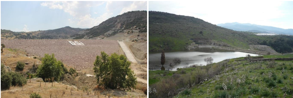
Gölet de Süleymanli, Menemen (DSI, 2014 à gauche ; terrain, 2016 à droite) : barrage de remblai homogène ; hauteur : 36 mètres ; volume d'eau : 1,18 million m 3 ; superficie irriguée : 153 ha.
