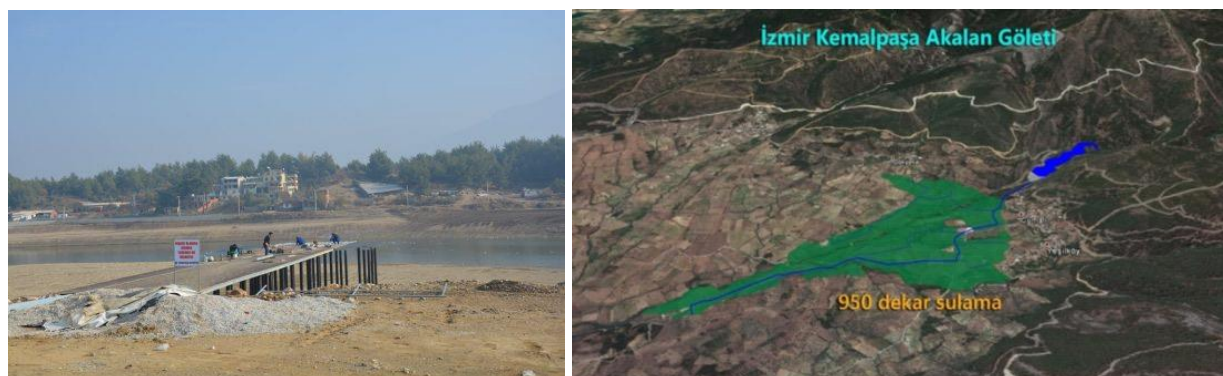
À gauche : photo des travaux autour du gölet de Savanda sur le site de la mairie de Kemalpaşa (décembre 2016)
