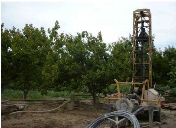
Réalisation d'un forage (Emiralem, 2015)
