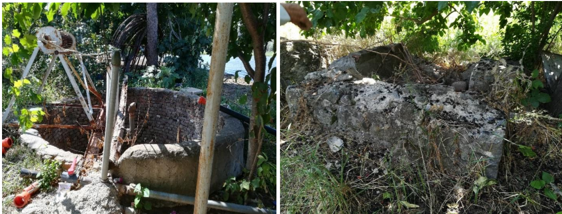
À gauche : ancien puits à rotation ( dönme kuyu ) ; à droite : ancien puits individuel comblé (2018)
