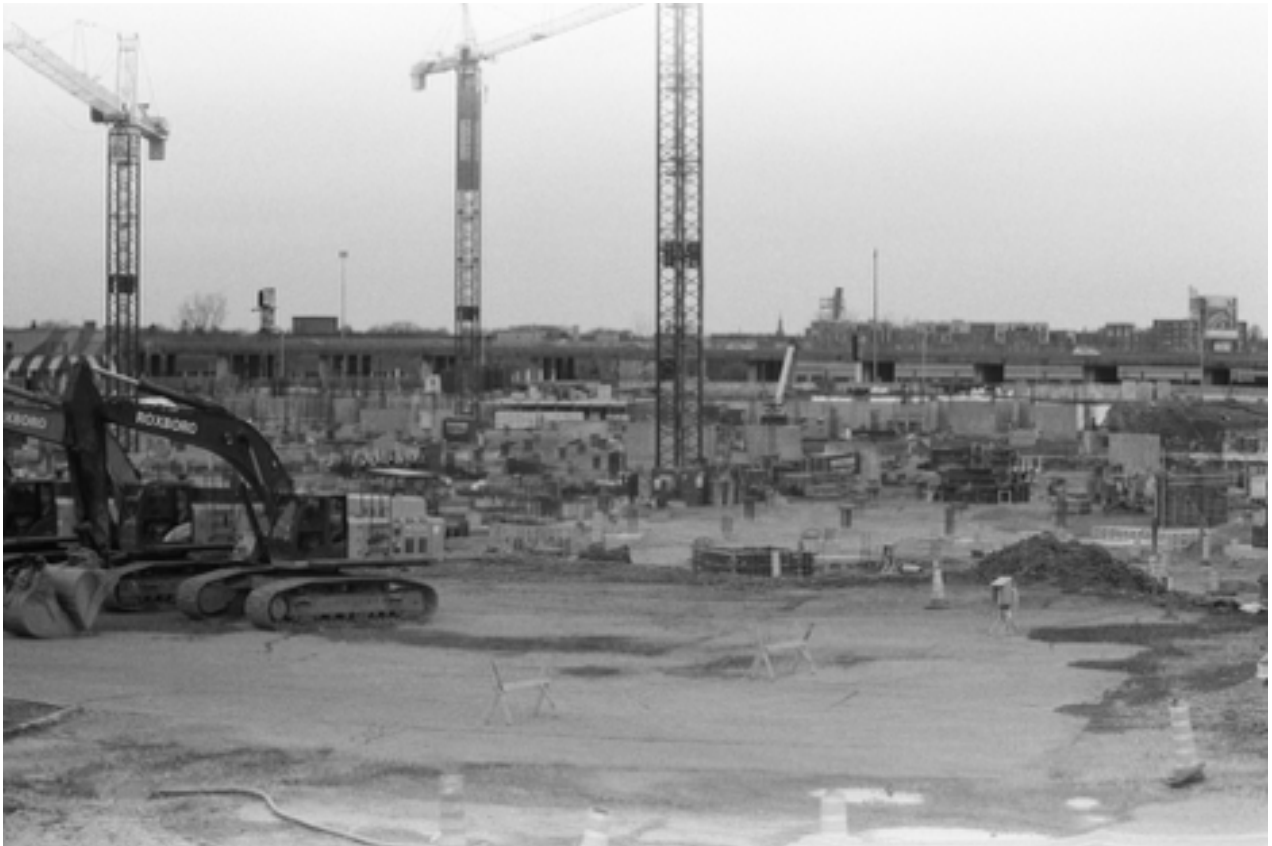
Photo argentique, Maude Cournoyer-Gendron (2020) Chantier du projet Royalmount.
