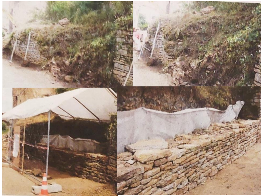
Figure 132 - Intervention sur le mur de Pierre-Sèche.
