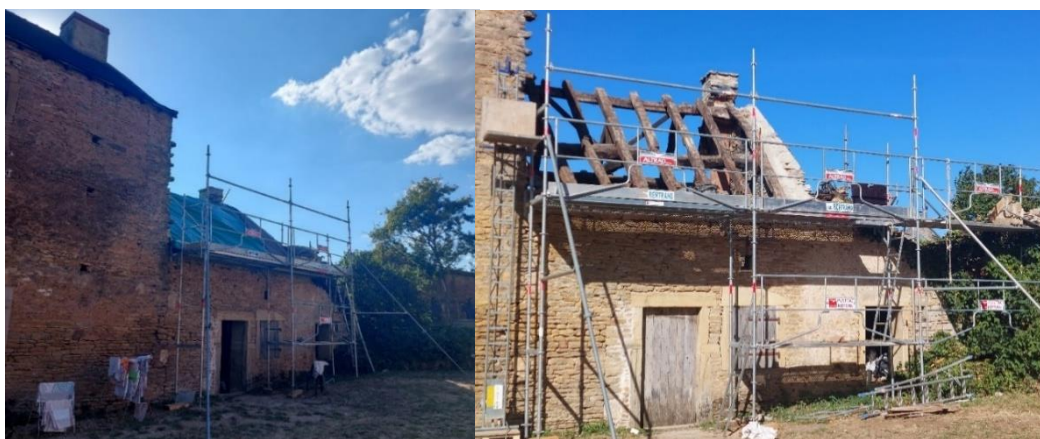
Figure 151 - Travaux de restauration du toit du château de Pontus à Tyard. Source : Préparé par l'auteur, 2022.
