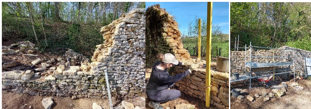
Figure 129 – Chantier de Bénévoles au Château Bussy-Rabutin. Source : Préparé par l'auteur, 2022.
