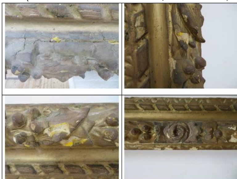
Figure 112- Détails de l'état de conservation du cadre La descente de Croix, avant restauration. Source : BÉRINGUER, 2021.
