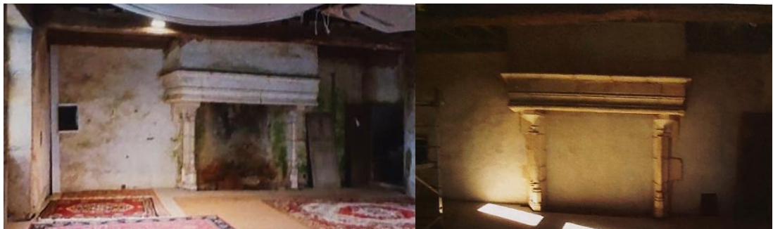
Figure 133 – Avant l'intervention sur le revêtement et après l'intervention, respectivement, en 2013. Source : Rapport 2014 fourni par REMPART et compilé par l'auteur (2023).
