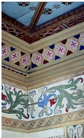
Figure 34 - Intérieur de l'Ancienne Église, illustrant les peintures murales, sans date. Source : Archives de l'IPHAÉ, 2020.
