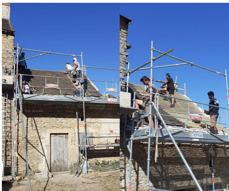
Figure 154- Bénévoles lors des travaux de restauration du château de Pontus à Tyard. Source : Minardj, 2022.
