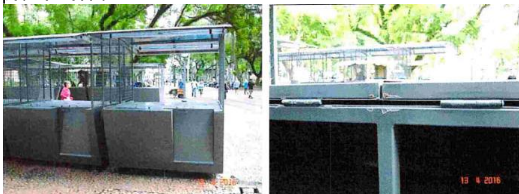
Figure 25 - Vue arrière des stands 01 et 02 et dommages causés aux peintures, respectivement. Source : PIBERNAT, 2016.
