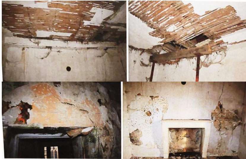
Figure 142 – État de la conversation de la guérite avant l'intervention en 2018. Source : Rapport 2018 du chantier de bénévoles fourni par REMPART.
