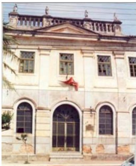
Figure 39 - Photographie de l'Ancienne École Militaire de Rio Pardo avant restauration, non datée. Source : Archives de l'IPHAE.
