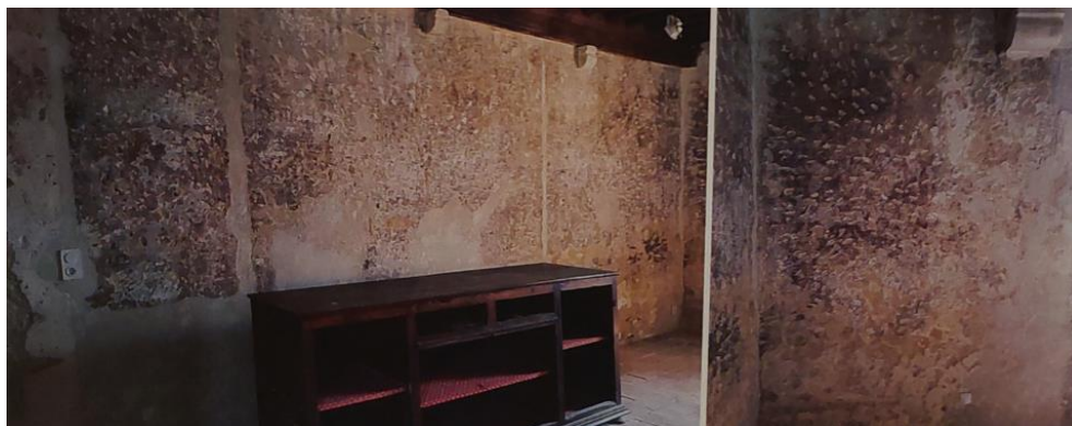
Figure 141 – Vue générale de la salle.
