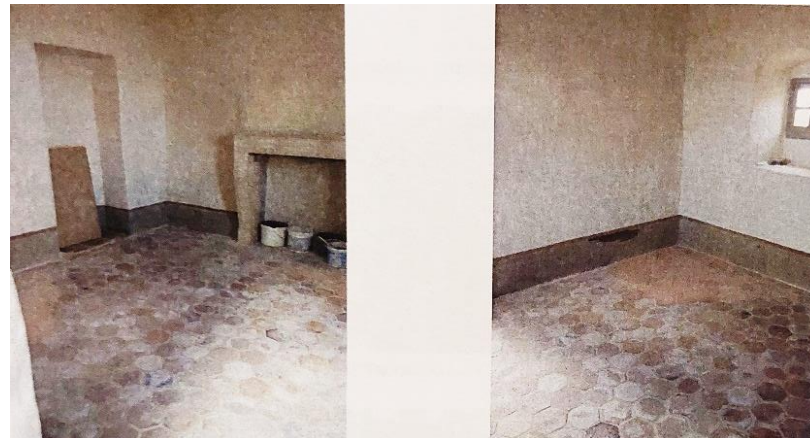
Figure 143 – Fin du site volontaire après l'intervention en 2019. Source : Rapport 2018 du chantier de bénévoles fourni par REMPART.
