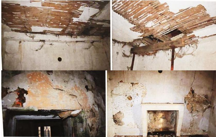
**Figure 142** – État de la conversation de la guérite avant l'intervention en 2018.
