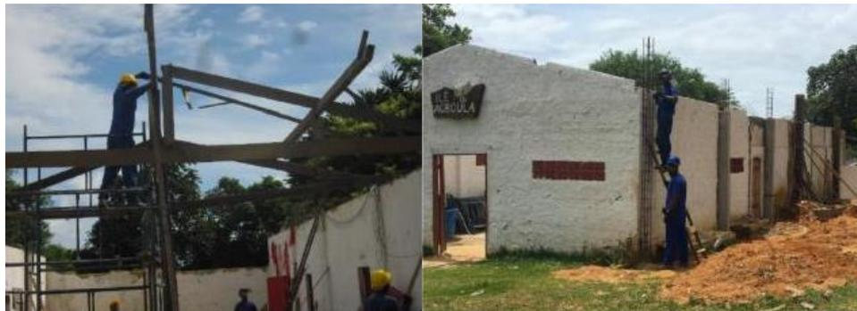
**Figure 60** - Démontage des vieilles poutres détériorées du toit de l'abri et assemblage des nouveaux piliers.
