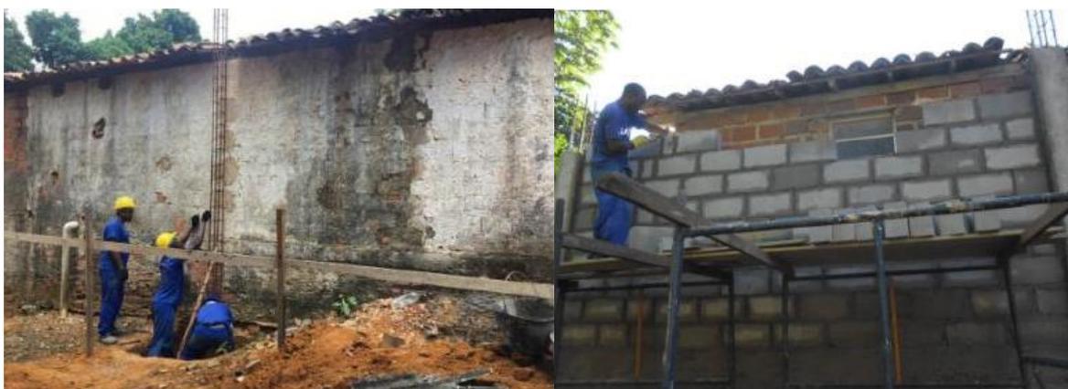
**Figure 61** - Réalisation des ferrures pour les nouveaux piliers du sacré et élévation du mur du sacré. Source : 3ème RAPPORT PHOTOGRAPHIQUE - PÉRIODE 21/11/2018 AU 31/12/2018<sup>1192</sup>.
