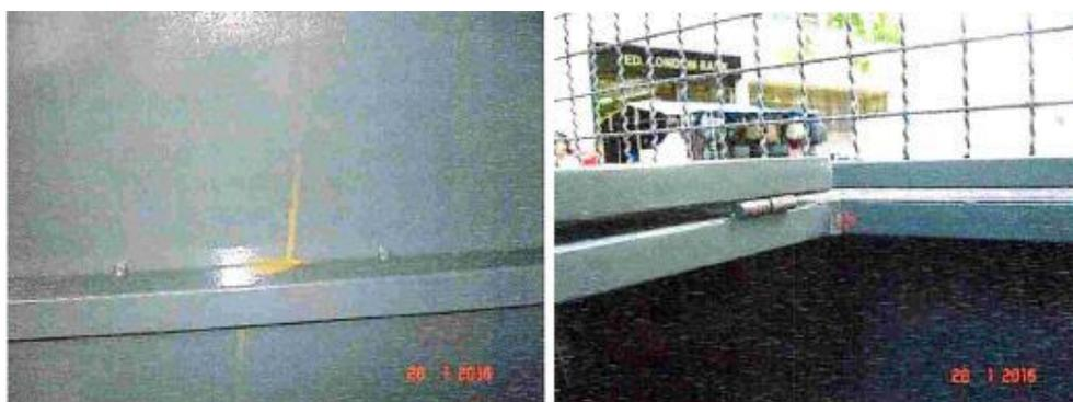
**Figure 23** - Marques d'infiltration et peinture écaillée sur le stand de l'artisan.
