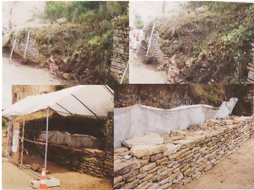
**Figure 132** - Intervention sur le mur de Pierre-Sèche.
