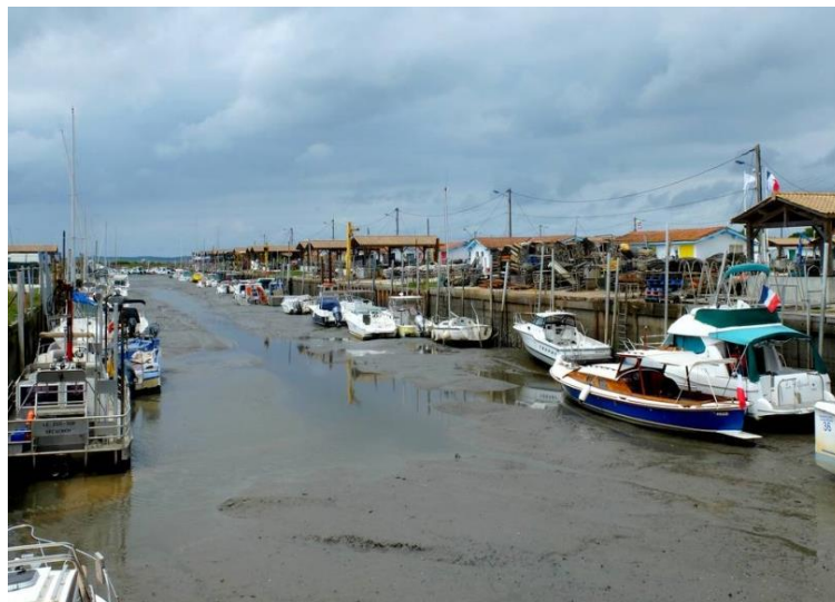
Figure 1-1 : Exemple d'envasement de port à marée basse – Photo du Port de Gujan-Mestras
